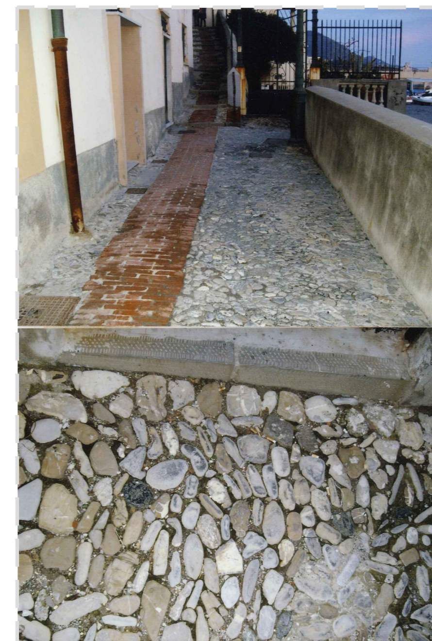
VERNAZZOLA - esempio di corsia in mattoni fuori asse rispetto al fondo di ciottolato che riempie l'intera strada
