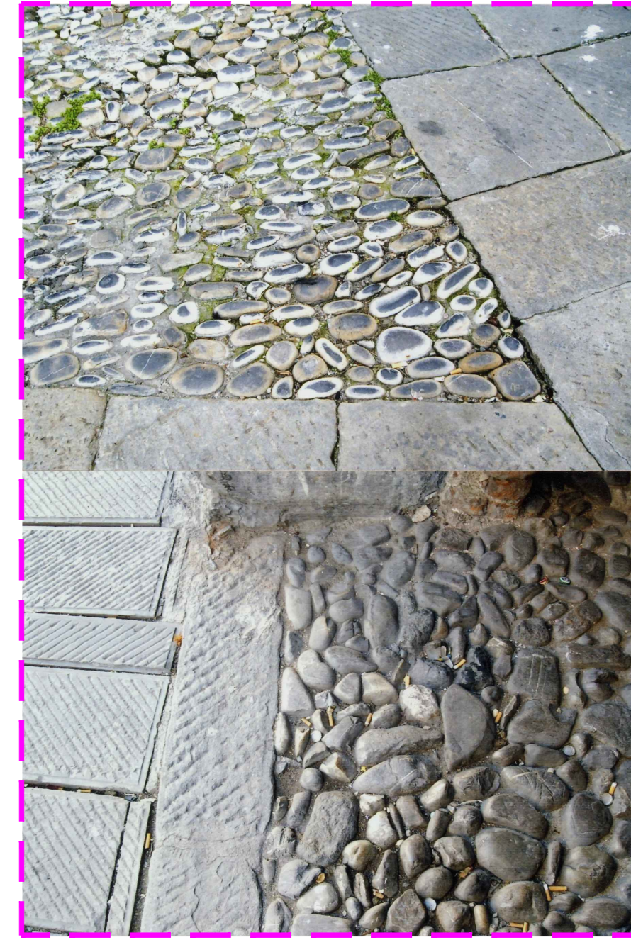
CAMOGLI - attacco fra pietre e ciottolato in due particolari d'angolo
