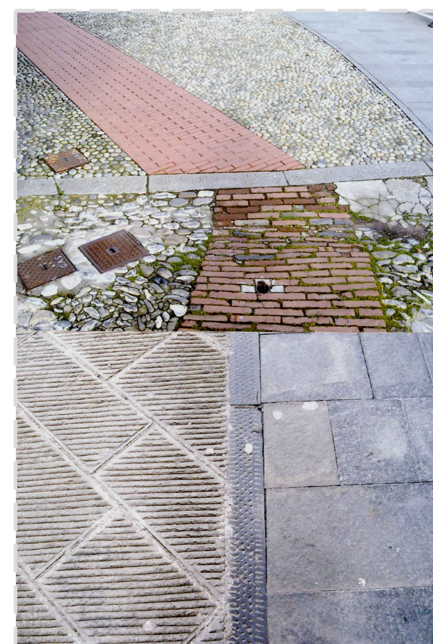
SANTA MARGHERITA - attacco fra parte nuova e parte antica in due particolari in pietra e in mattoni
