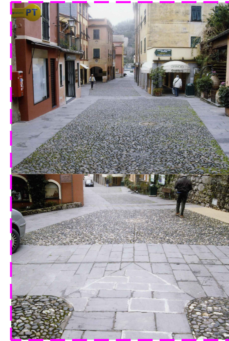
vari esempi di strade con corsi di pietra alternati a corsi di mattoni con eventuali inserti in ciottolato
