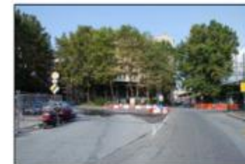
FOTO: IN CORSO DI REALIZZAZIONE
