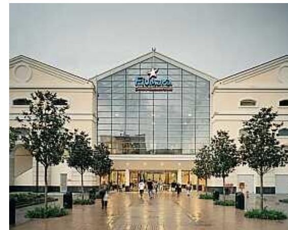
Centro Commerciale Fiumara
