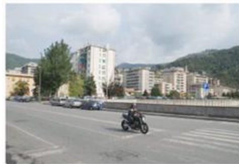
FOTO STATO DI FATTO
