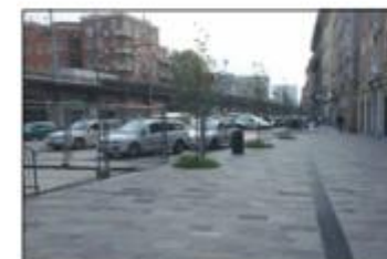
FOTO: IN CORSO DI REALIZZAZIONE
