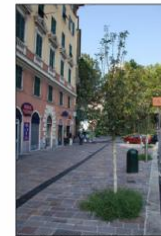
FOTO: IN CORSO DI REALIZZAZIONE
