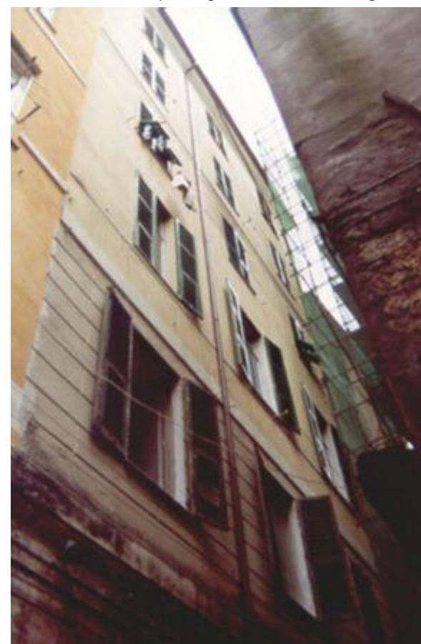
Edificio di via Prè
