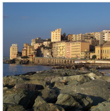
Veduta verso Capo Risveglio
