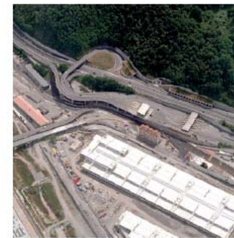
Bolzaneto svincolo autostrada
