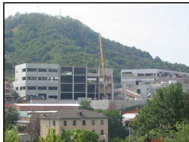
area 1: edificio produttivo in costruzione
