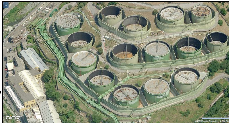
vista aerea area Fondegga nord
