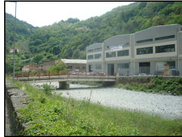
area 5: sede ditta Solari (impianti elettrici)
