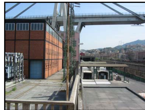
Area 2 – edificio ENEL ed Isola Ecologica -
