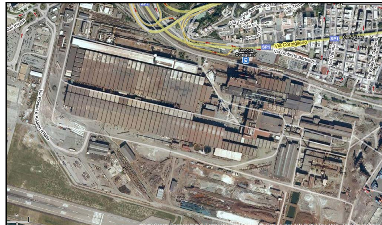
area 9: vista aerea dello stabilimento ILVA
