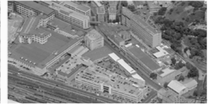
area 10 – deposito materiali edili, sulla sinistra, sopra la ferrovia, edificio ex fabbrica del cacao –
