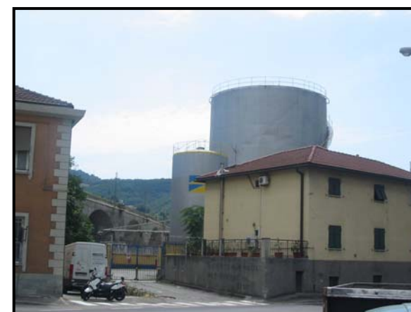
Deposito petrolifero lungo via Ferri
