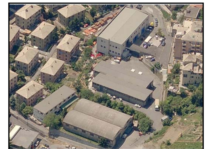
area produttiva a margine di via Lagofigoi
