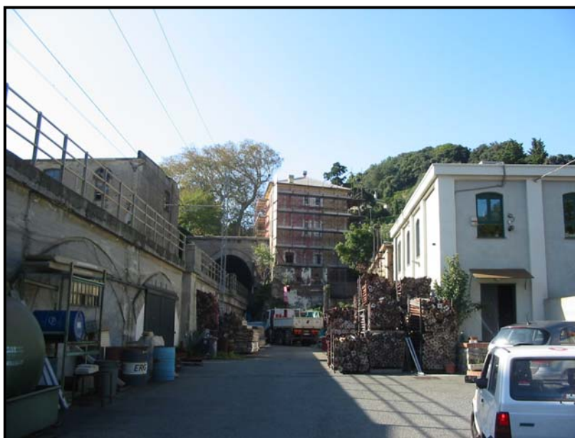
10 Via Luigi D'Albertis, fra le due linee ferroviarie, alle spalle di un piccolo isolato di edifici residenziali, è presente la vecchia fabbrica del cacao inutilizzata ormai da tempo.
