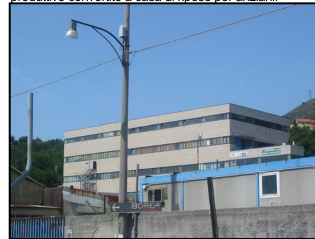
Area 18 – edificio artigianale -
