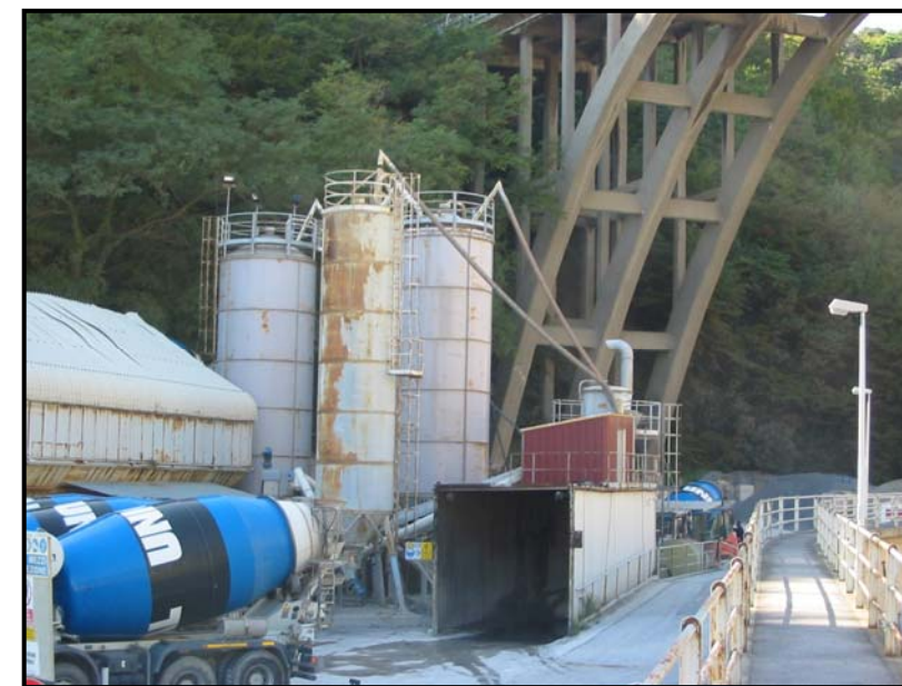
11 Via Luigi D'Albertis sottozona DD l'area disposta lungo il torrente Leira, in sponda destra, ospita un deposito nella parte più prossima alla linea ferroviaria, un officina di carpenteria metallica, un fabbricato inutilizzato, un carrozzeria; nella parte a nord, all'esterno della sottozona DD, è presente una centrale di betonaggio.
