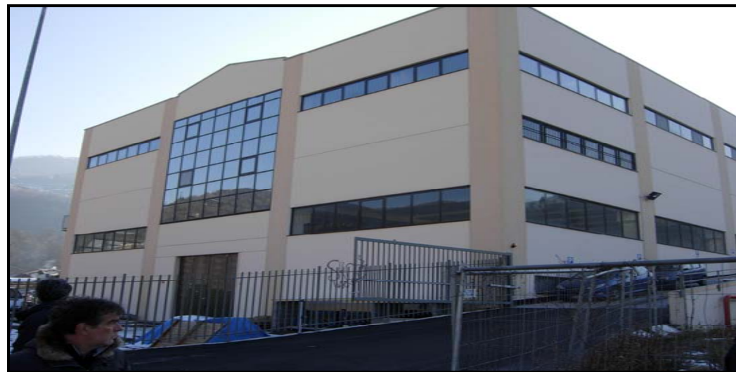
area 23: edificio di recente costruzione
