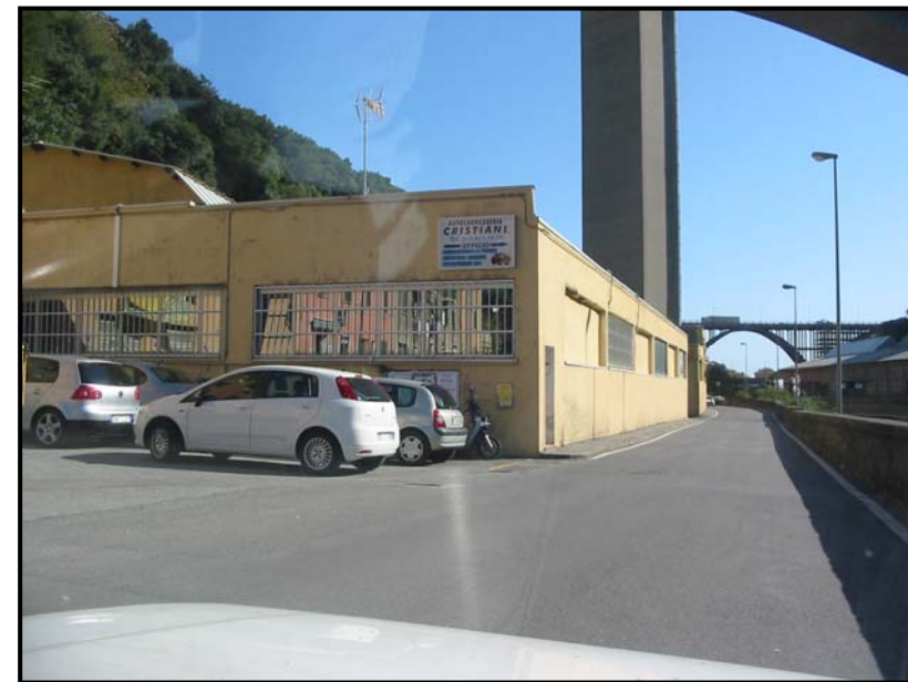
9 Via delle Fabbriche sottozona DD, sulla sponda sinistra del torrente, sottostante il viadotto autostradale, un complesso di volumi in buon stato di conservazione, che ospitano una carrozzeria, la ditta CISA, impianti elettrici, ed altre attività artigianali.
