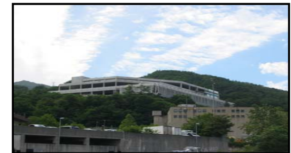
Area 17 – edificio in via di completamento -
