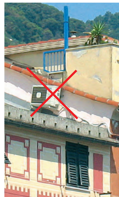
fronte palazzata via Caboto
