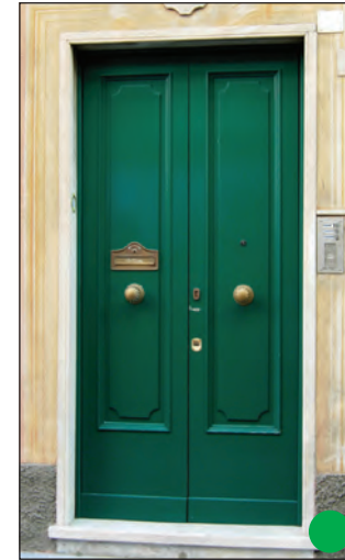
Portoncino a doppia anta simmetrica e a telaio
