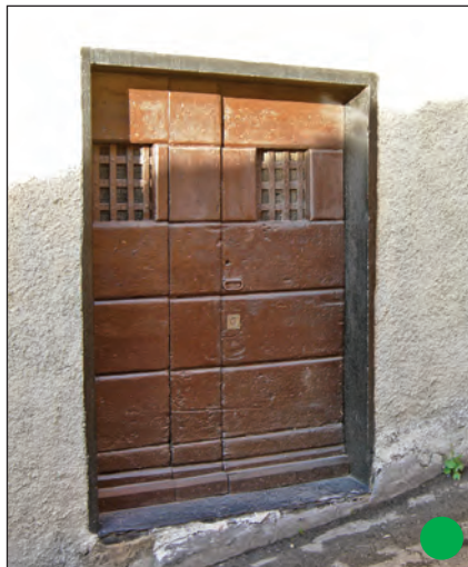
Porta da magazzino a tavole affiancate orizzontalmente
