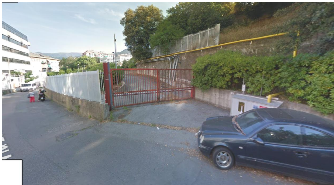
- DETTAGLIO DELL'ACCESSO DA VIA CALDA -
