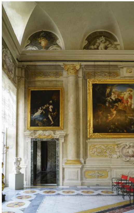
Foto 17 : Piano Secondo Nobile – Salone – Particolare parete EST con lunette - Locale 209
