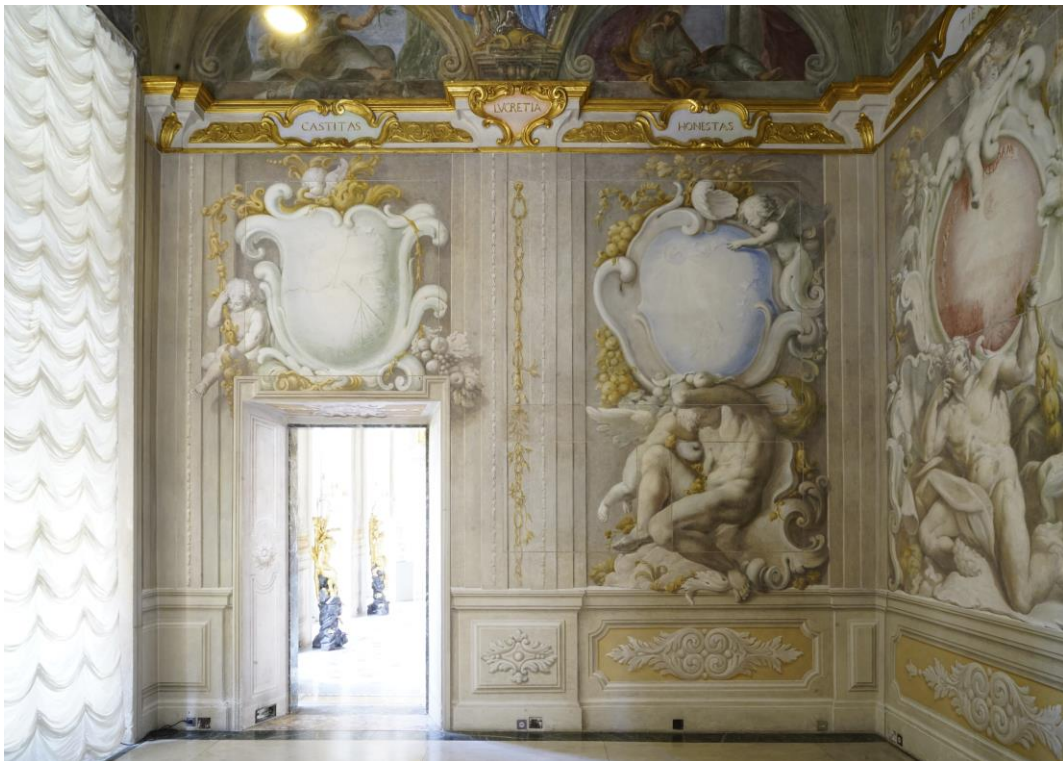
Foto 19 : Piano Secondo Nobile – Parete EST - Sala della Gioventù in cemento – Locale 208
