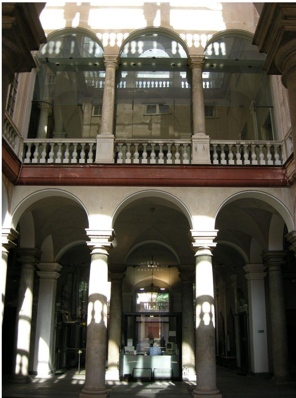
Foto 4 : Vista dal Cortile
