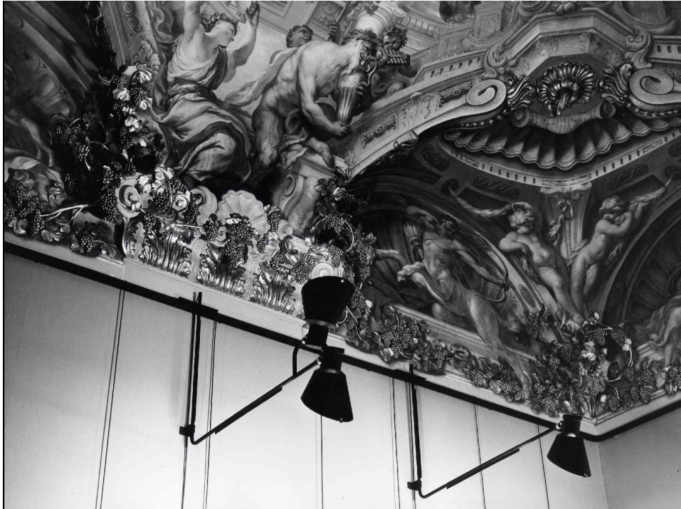
Foto 9 : Lampade dotate di doppio riflettore nelle sale con volte affrescate.
