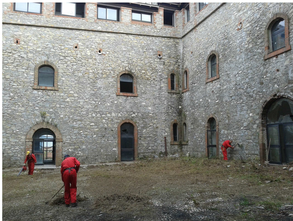
Cortile caserma — dopo i lavori
