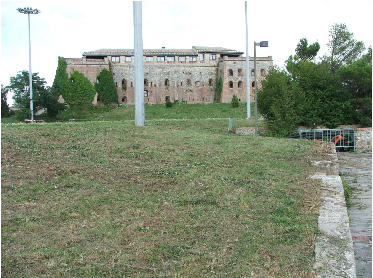
Vista del prospetto principale dalla caserma — dopo i lavori
