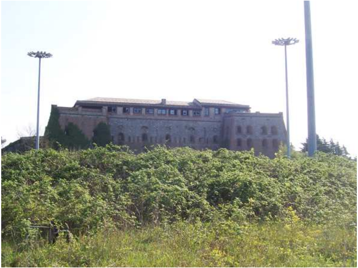
Vista del prospetto principale dalla caserma — prima dei lavori
