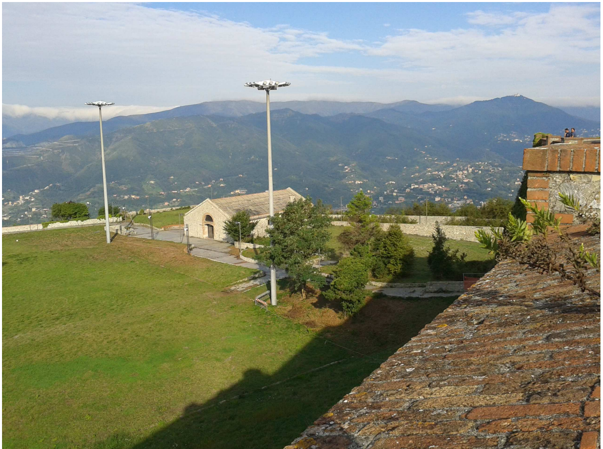
Spazi esterni attorno all'ex-foyer — dopo i lavori
