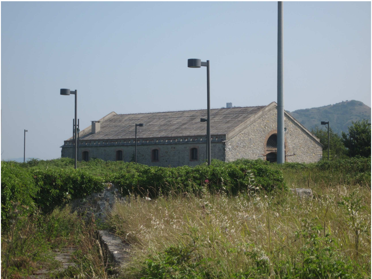
Spazi esterni attorno all'ex-foyer — prima dei lavori
