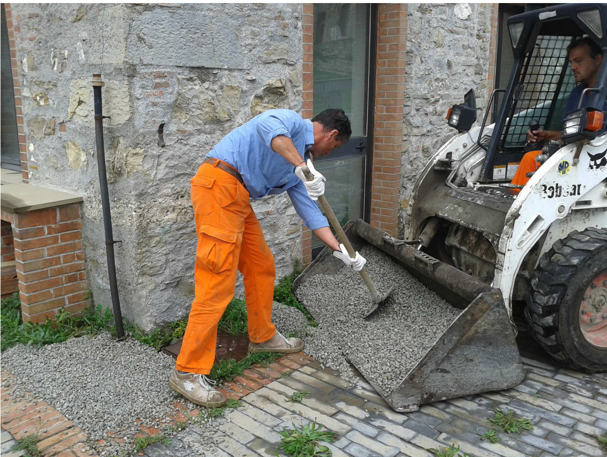
Riempimento con ghiaietto delle parti sconnesse
