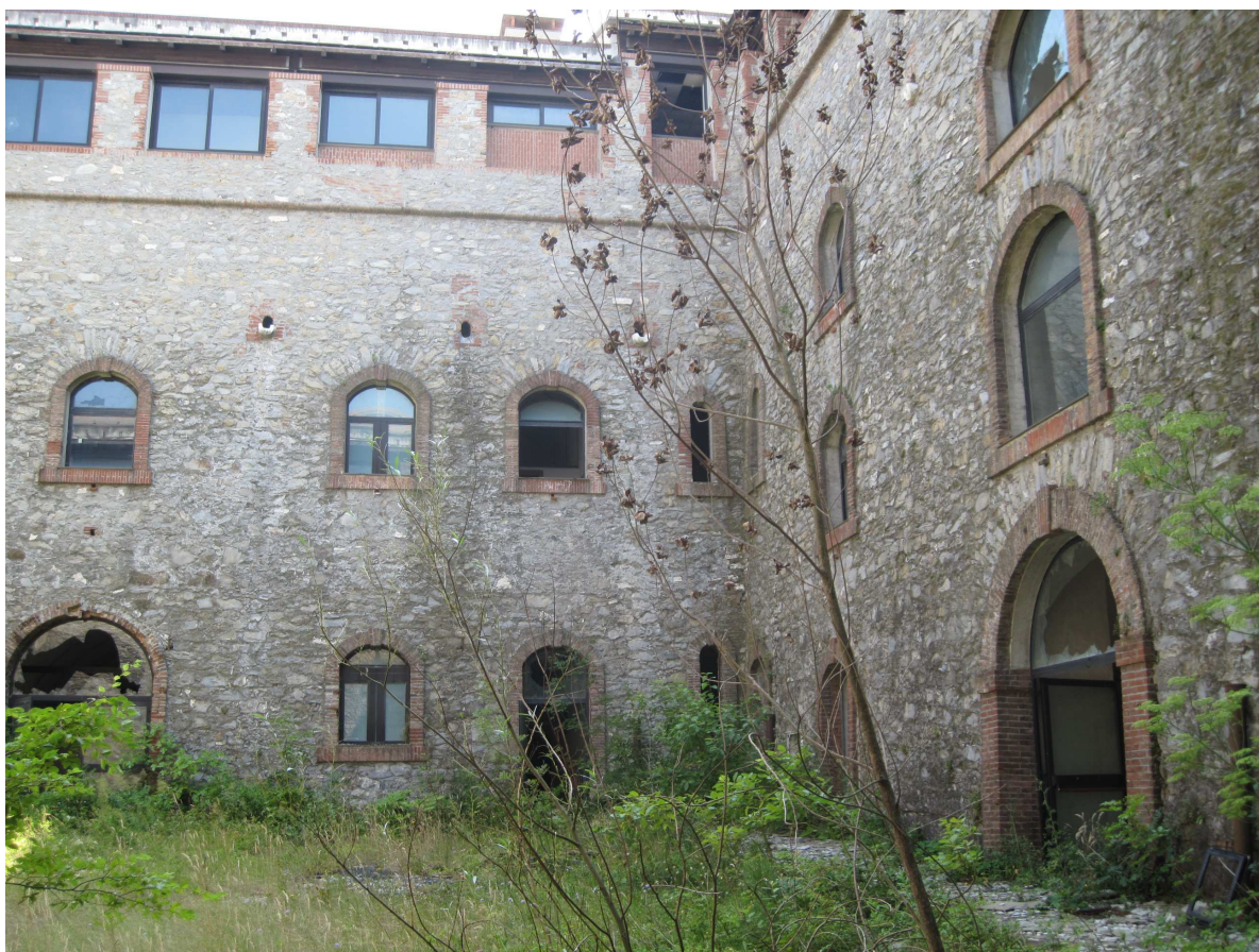
Cortile caserma — prima dei lavori
