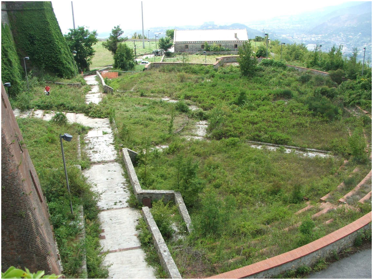
Arena — prima dei lavori
