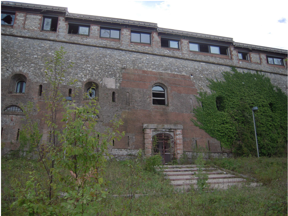
Caserma lato prospiciente all'arena — prima dei lavori
