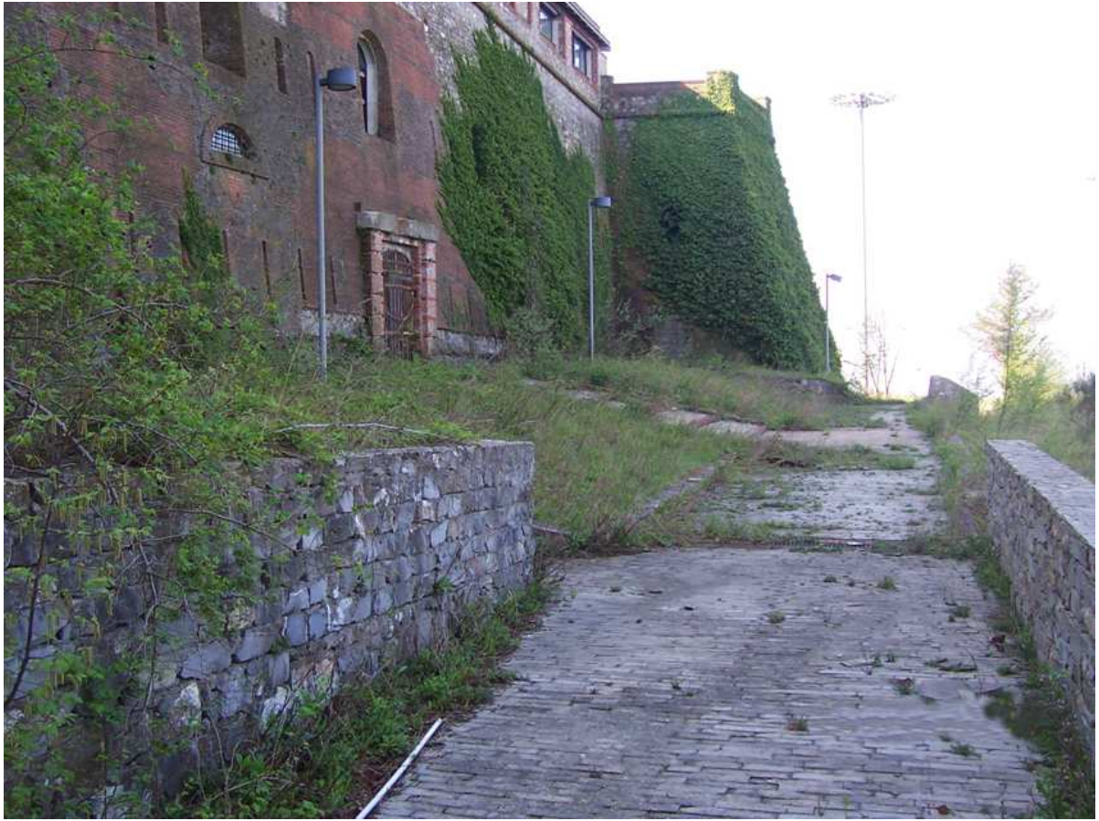
Camminamento tra la caserma e l'arena — prima dei lavori
