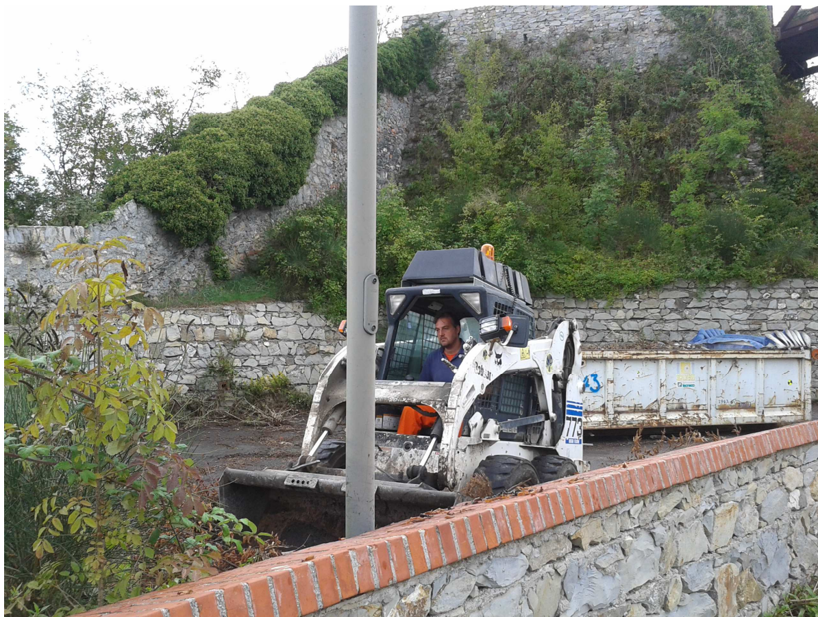
Cortile caserma — prima dei lavori
