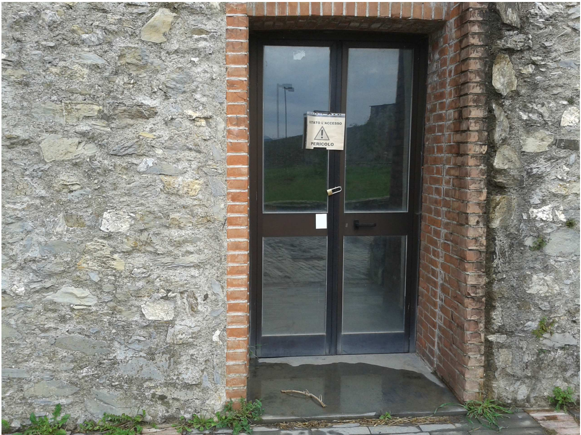
Chiusura con lucchetto di tutti gli accessi degli edifici minori
