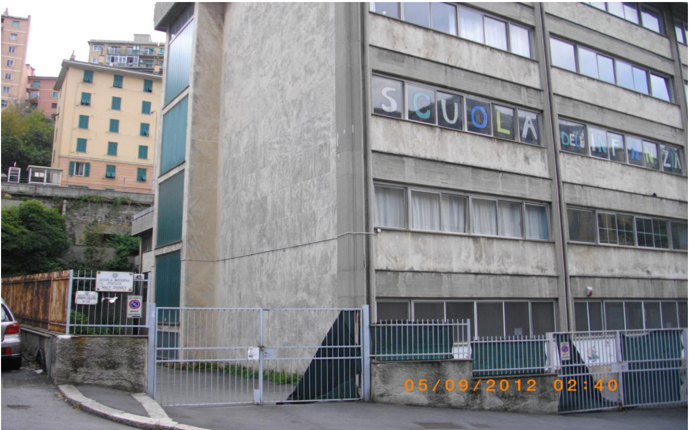
Foto n. 3 – Angolo nord-ovest sulla strada: a destra del vano scala è prevista l'apertura di una nuova uscita
