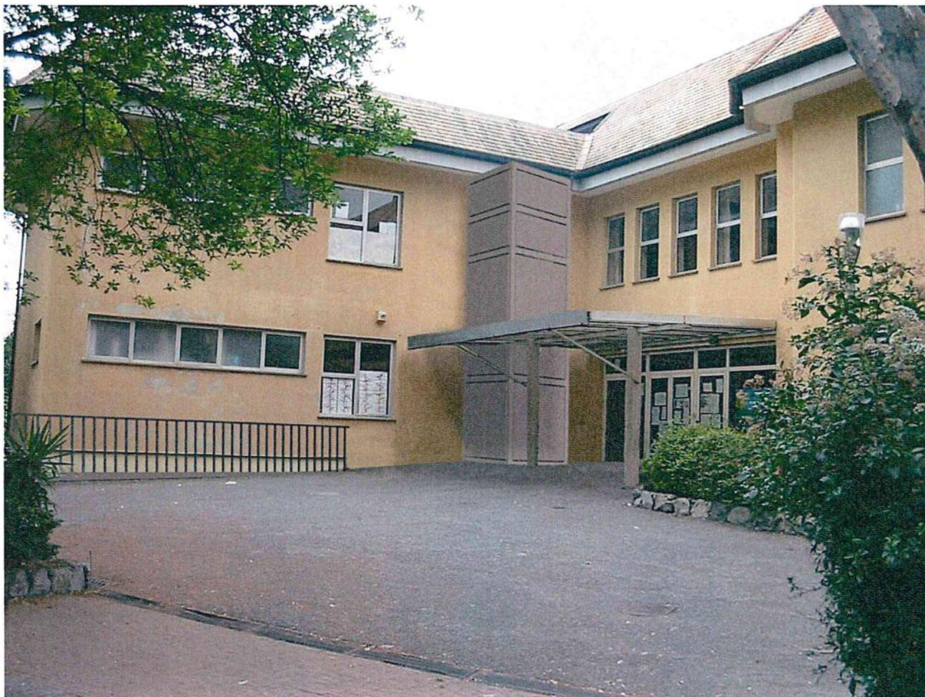
**Immagine 21** - Ingresso Scuola Primaria – Simulazione di inserimento degli interventi previsti dal Progetto: Nuovo Elevatore e rifacimento del percorso di accesso e innalzamento della quota del piazzale per eliminazione dei dislivelli in corrispondenza dell’atrio di ingresso.
