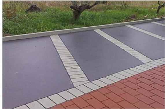
Foto 15 – 16 – Esempi e Tipologie di Pavimentazione in Asfalto Stampato e Resinato
