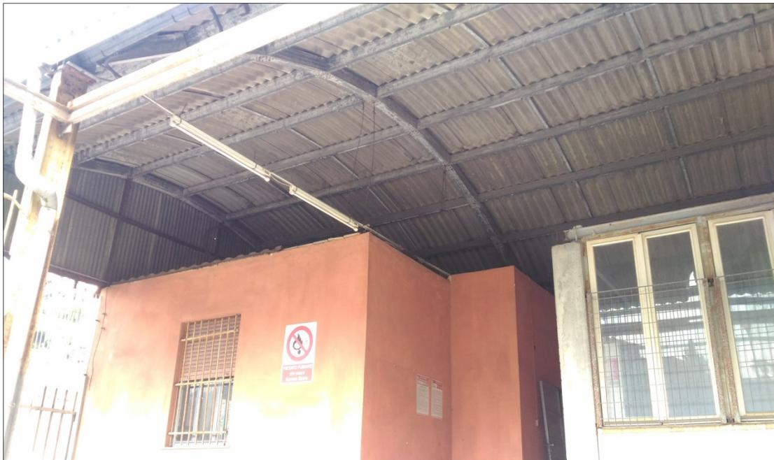
*Foto 01: Volumi con solaio di copertura piana ricavati sotto alla copertura semicircolare.*
