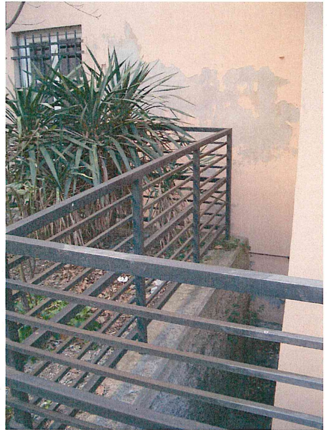
Foto 10 – Particolare ringhiera esterna in prossimità secondario dell'intercapedine che corre lungo l'edificio
