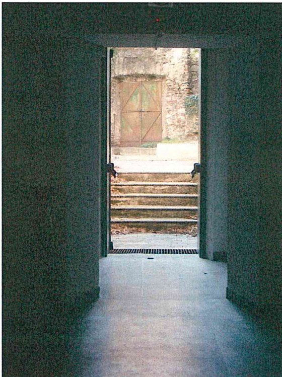
Foto 11 – Locali a piano terra in prossimità della zona di inserimento della piattaforma elevatrice
