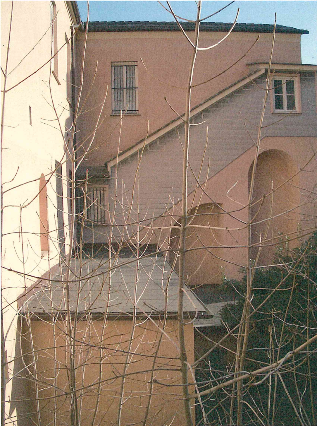
Foto 8 – scorcio sulla copertura del blocco bagni – l’area verrà resa calpestabile e servirà da sbarco a piano primo per l’elevatore
