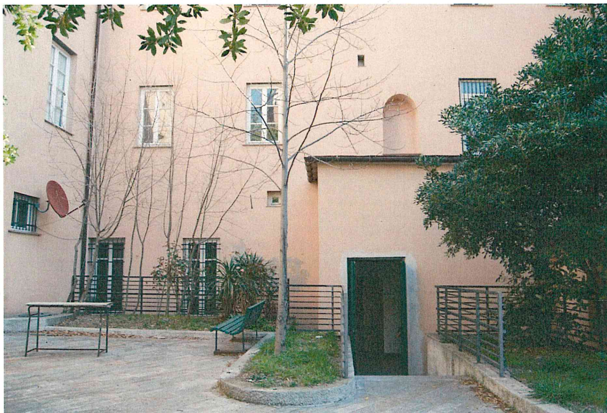
Foto 6 – Prospetto Sud Ovest
