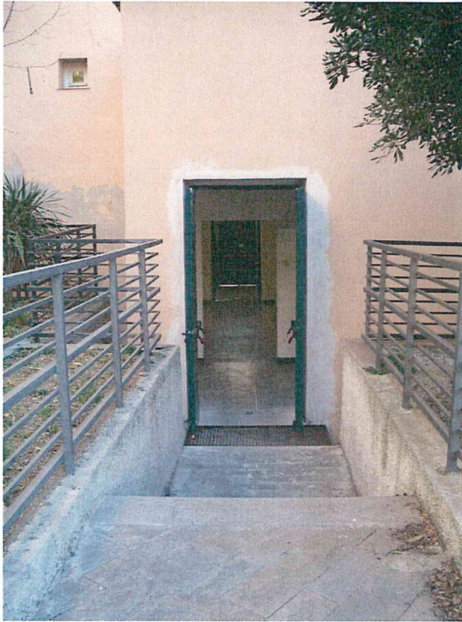
Foto 9 – Particolare Prospetto Sud: portone di ingresso alla scuola/uscita di sicurezza
