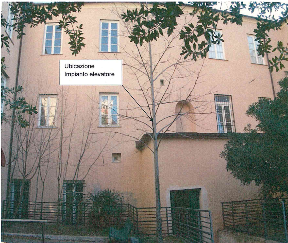
Foto 3 – Prospetto sud su cui insiste l'impianto elevatore
