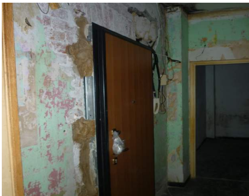
Locale 03 – l'ingresso e il nuovo portoncino di accesso all'interno 14
