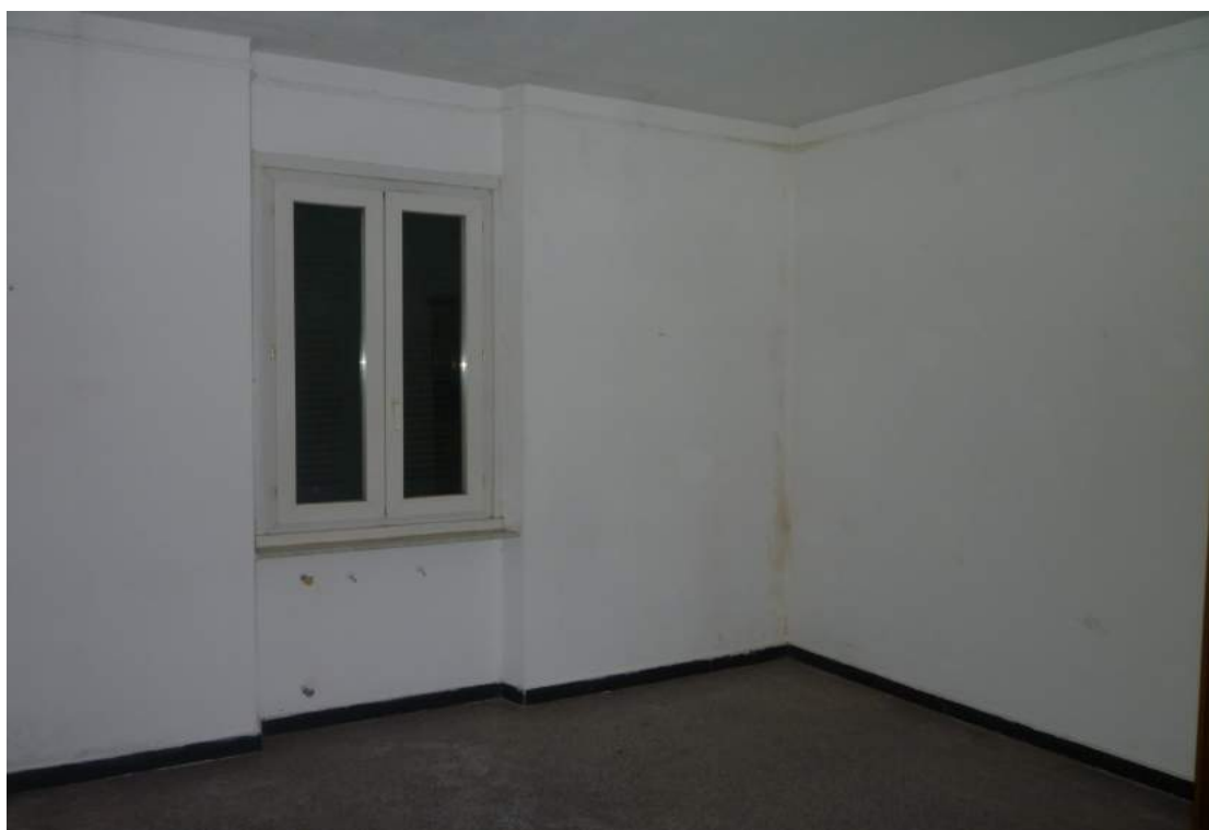
Locale 10 – la camera in buono stato di conservazione dell'interno 13
