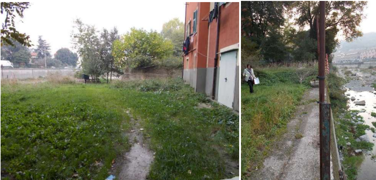
Figura 2 area di cantiere e l'argine sul Polcevera
