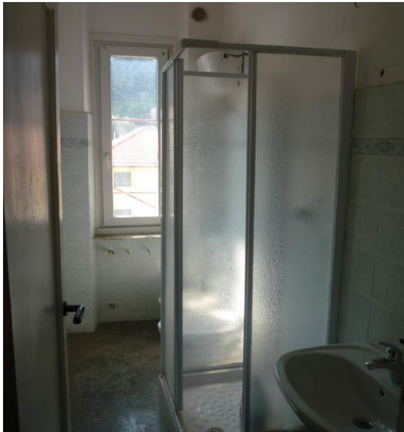
Locale 08 – il bagno in discreto stato dell'interno 13
