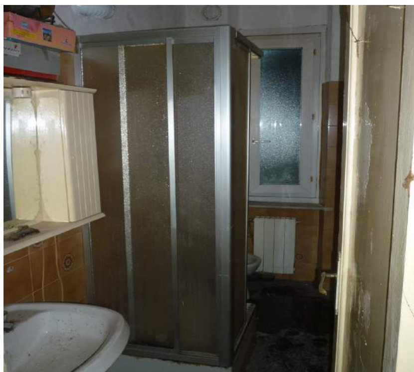
Locale 04 – il bagno dell'interno 14
