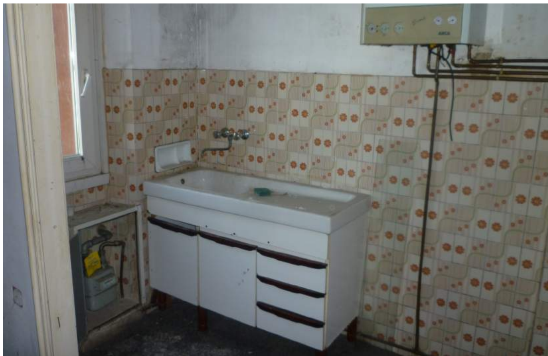
Locale 02 – l'angolo cottura dell'interno 14
