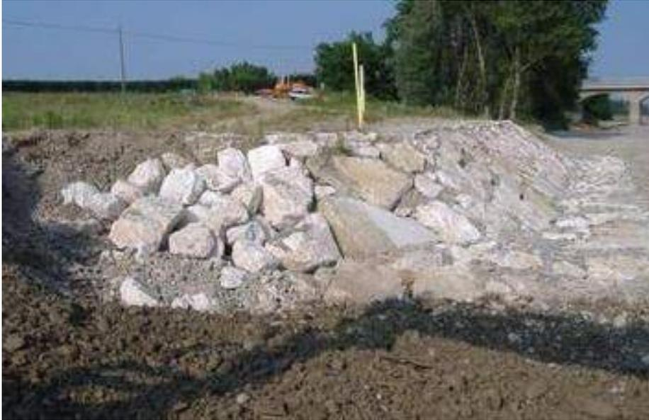
**Figura 26 Esempio di scogliera in massi cementati**
