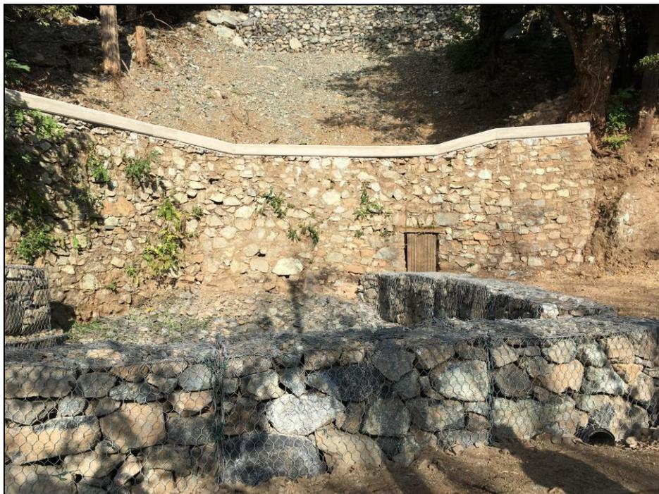
Figura 30 Esempio di gabbione in pietrame
