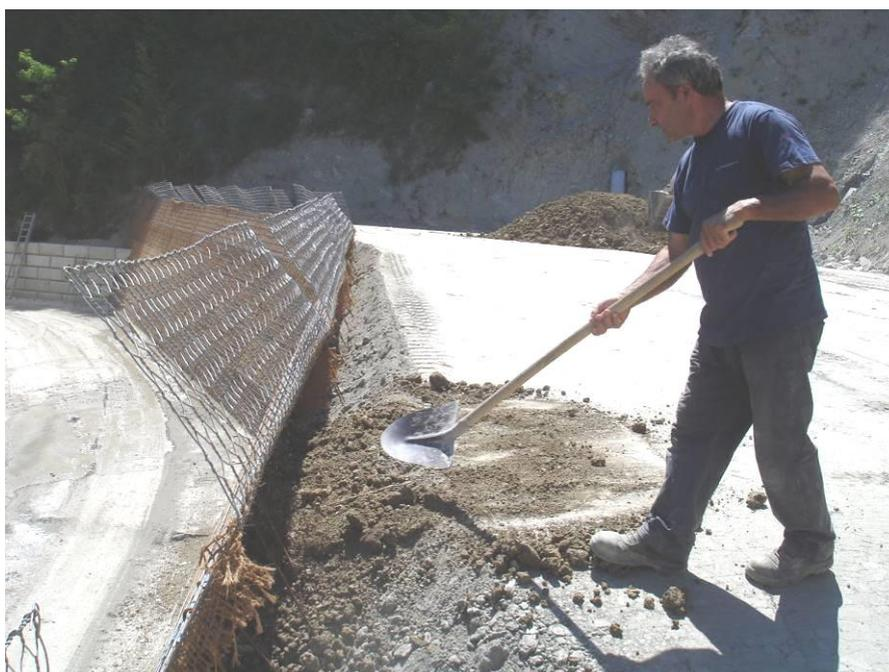
**Figura 17 – Riempimento a tergo del paramento**
