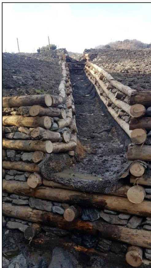
Figura 40 Esempio applicativo: Canaletta in Trenchmatt
