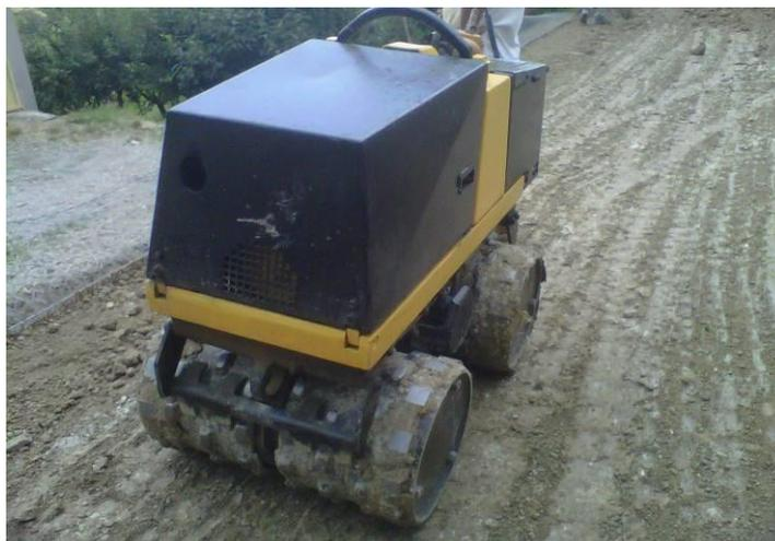
Figura 19 – Compattazione del materiale per ciascuno degli strati
