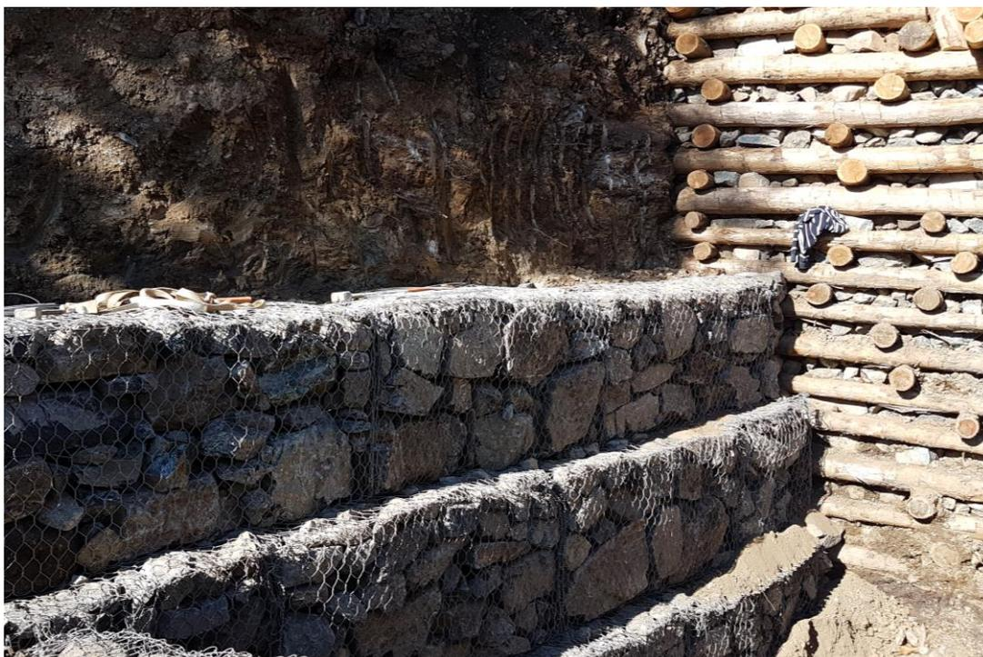
**Figura 22 Esempio di gabbione in pietrame**
