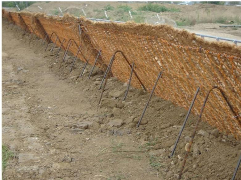
Figura 16 – Tiranti di irrigidimento del frontale
