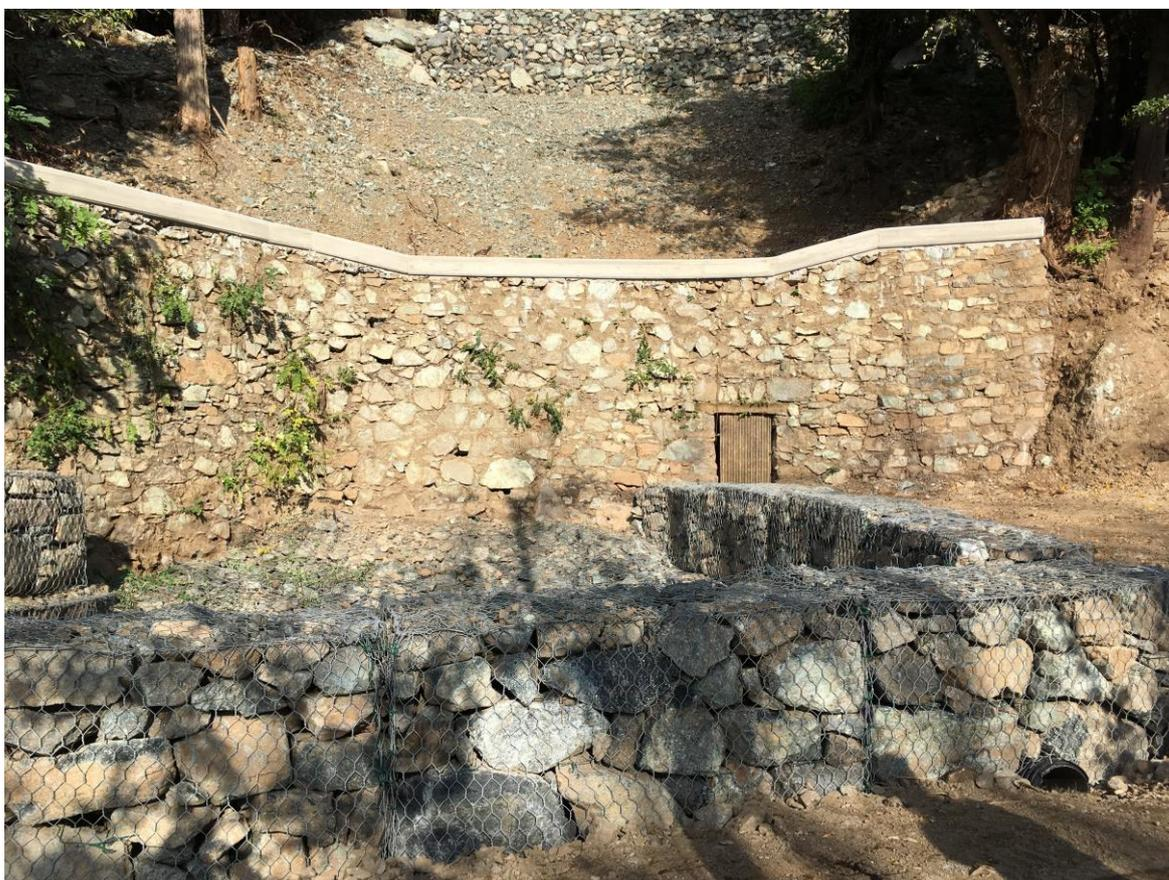
Figura 21 Esempio di gabbione in pietrame
