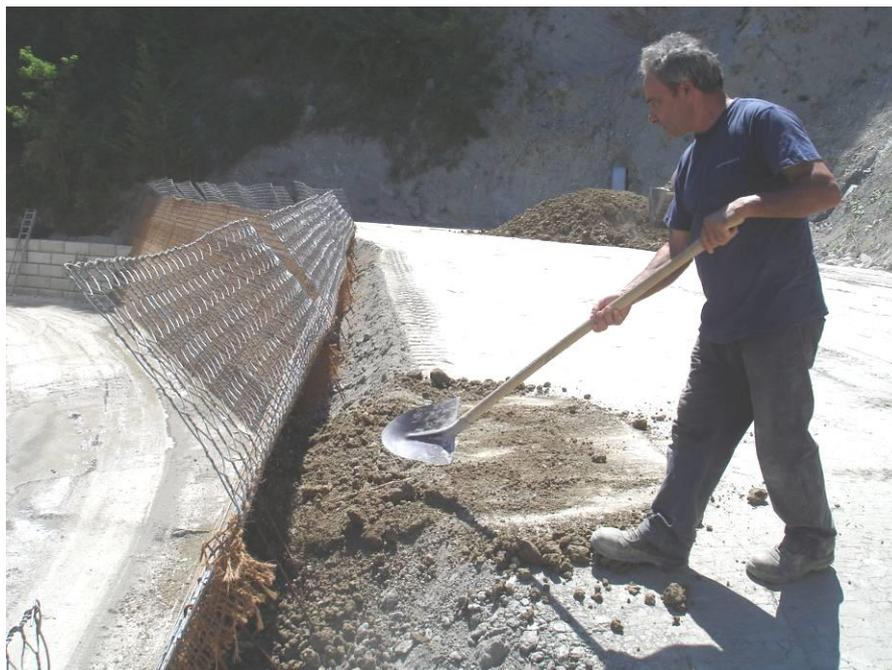
**Figura 24 - Riempimento a tergo del paramento**
