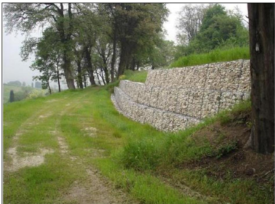
Figura 38 Esempio applicativo: gabbioni rinverditi per la stabilizzazione del versante
