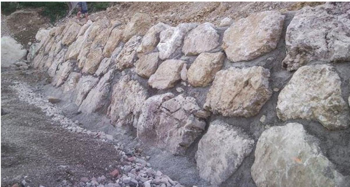
**Figura 24 Esempio di scogliera tipo in massi cementati**
