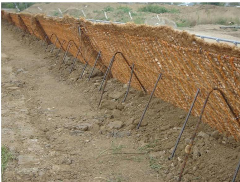
**Figura 23 - Tiranti di irrigidimento del frontale**
