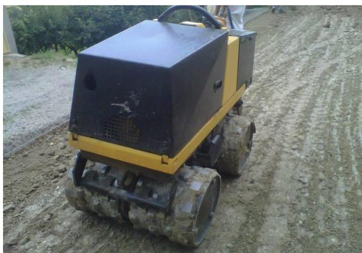
Figura 26 - Compattazione del materiale per ciascuno degli strati
