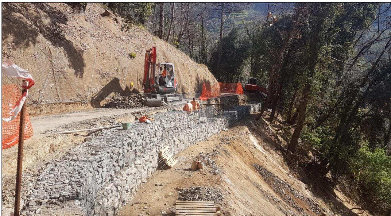
Figura 31 Esempio applicativo: impiego dei gabbioni come sostegno sottostradale
