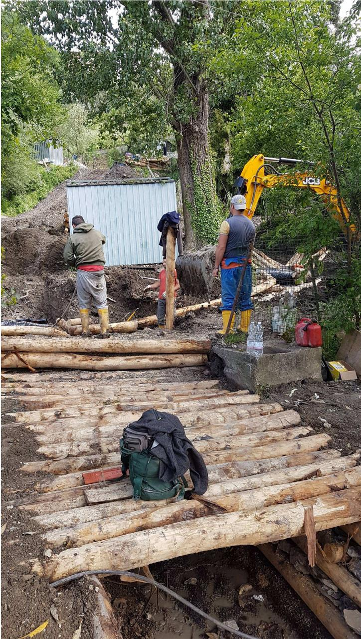
**Figura 18 esempio applicativo di attraversamento del canale trenchmat.**
