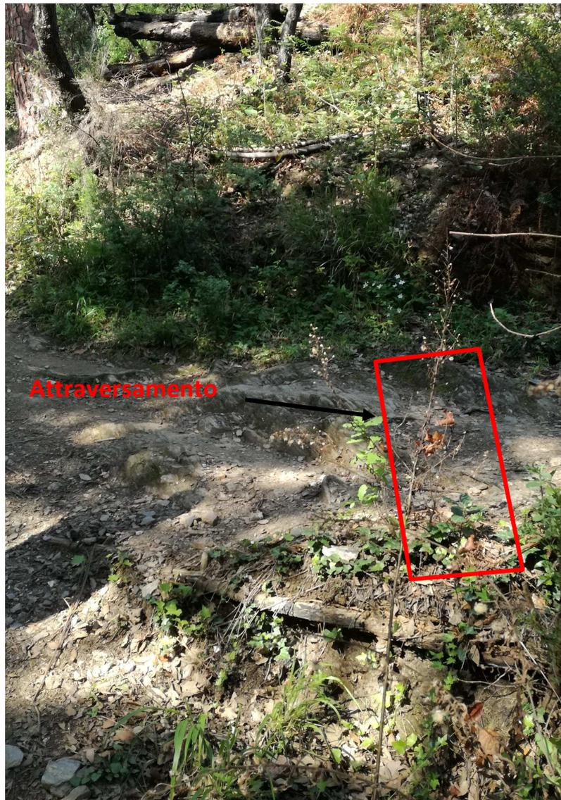
**Figura 16 Attraversamento del sentiero con canaletta trenchmat**
