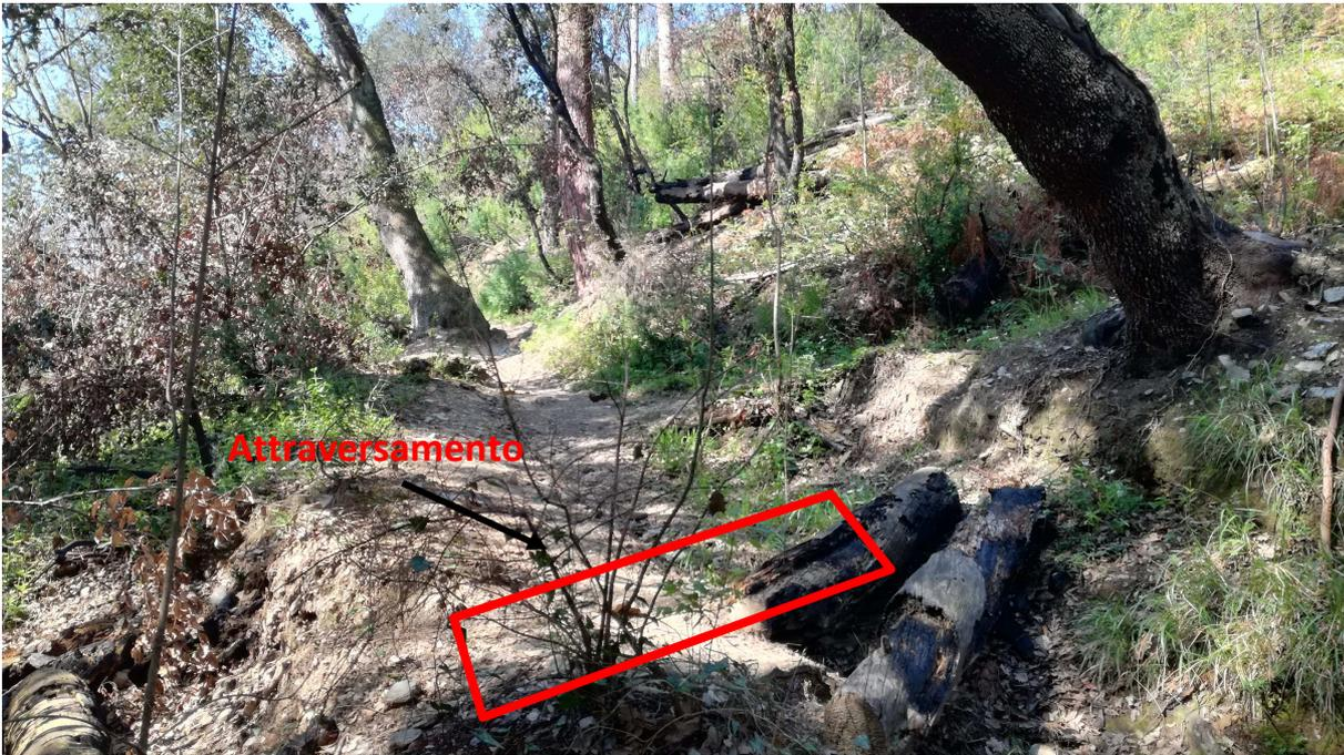
**Figura 17 Attraversamento del sentiero con canaletta trenchmat**
