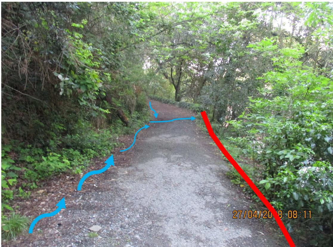
Figura 14 Intervento 4 (vista da nord a sud) in rosso la traccia del prolungamento del muretto; in azzurro le linee di scorrimento delle acque
