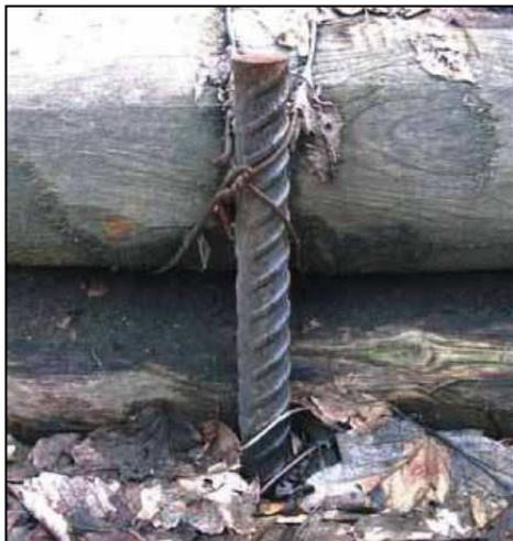
Tecnicamente la costruzione di una palificata semplice, anche detta *palizzata*, si utilizza tondame scortecciato di latifolia (castagno) o conifera (larice) di diametro minimo 20 cm, disposto perpendicolarmente rispetto alla massima pendenza, legato e fissato a valle da picchetti (pilotti) in legno o metallici, infissi nel terreno. Nel caso in esame, in ragione di una generale condizione di sub affioramento del substrato roccioso, si predilige
