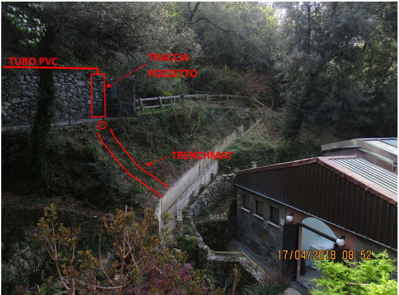
Figura 11 Intervento zona 2: particolare del sistema di scarico delle acque verso l'impiuvio principale
