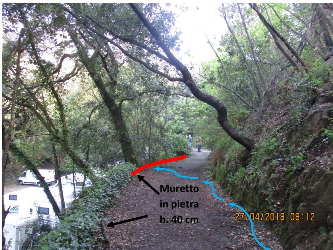
Figura 15 Intervento zona 4 (vista da sud a nord) In rosso la traccia del prolungamento del muretto; le frecce azzurre indicano il percorso di scorrimento delle acque.
