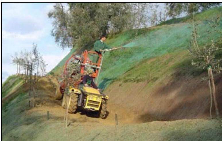
Foto 13: caricamento dell'idroseminatrice e idrosemina su scarpata
