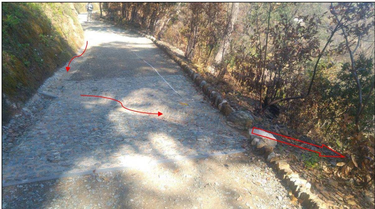
Foto 9: dettaglio della canaletta rompitratta in corrispondenza della quale le acque incanalate si riversano senza alcun presidio nella scarpata sottostante.
