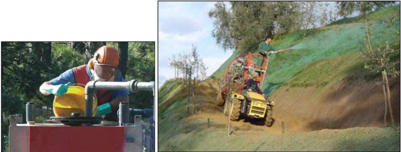
Foto 10: caricamento dell'idroseminatrice e idrosemina su scarpata
