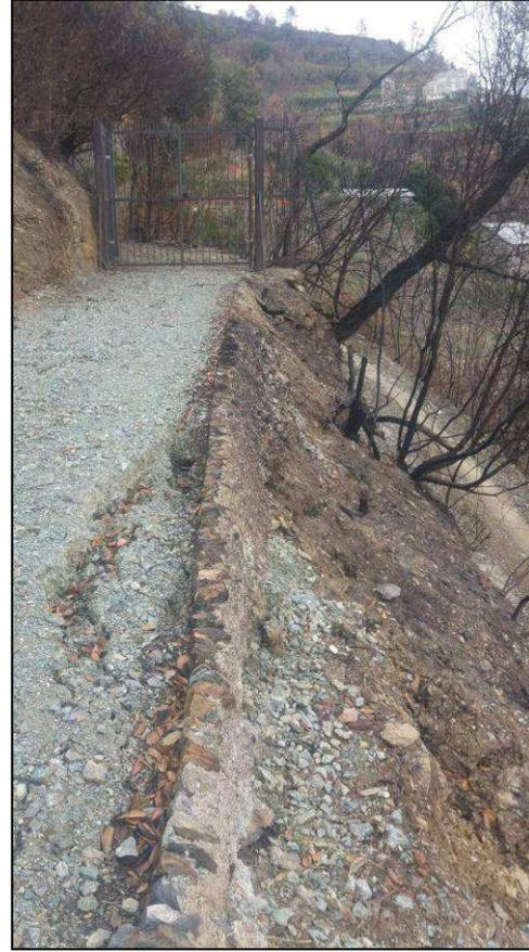
Foto 4: dettaglio del cordolo sottoescavato e progressivo coinvolgimento della carreggiata
