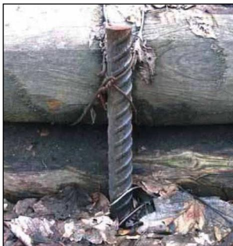
disposto perpendicolarmente rispetto alla massima pendenza, legato e fissato a valle da picchetti (pilotti) in legno o metallici, infissi nel terreno. Nel caso in esame, in ragione di una generale condizione di sub affioramento del substrato roccioso, si predilige l'impiego di picchetti metallici costituiti da tondini in acciaio ad aderenza migliorata posati con densità di circa 3 pilotti a metro lineare e diametro pari 22-24 mm.
