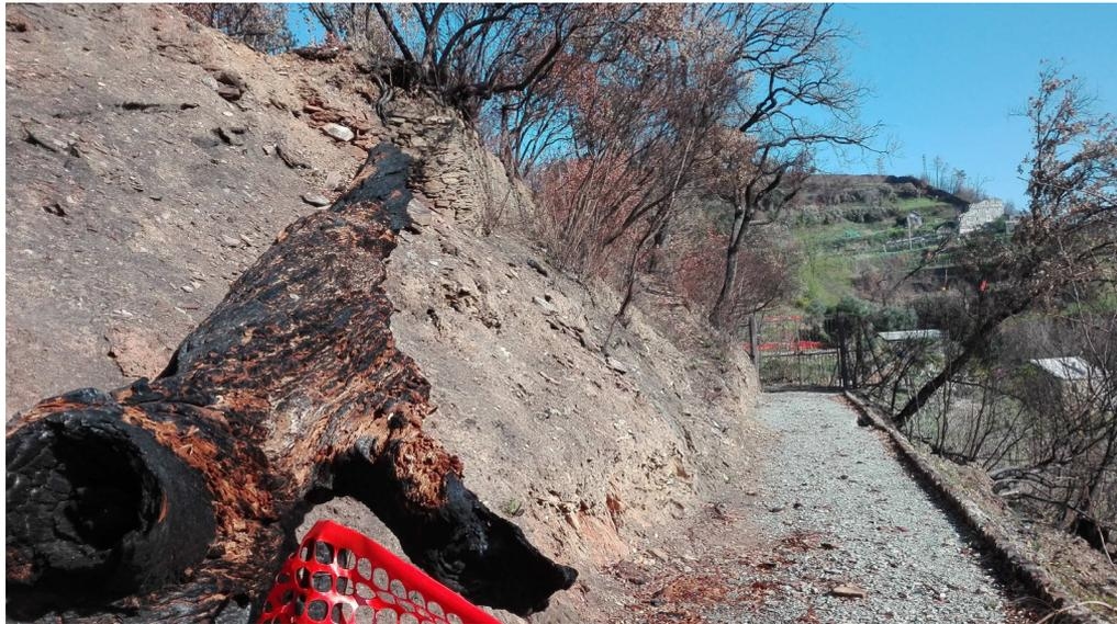
Figura 4 A sx: scarpata da rivestire con geocomposito tridimensionale
