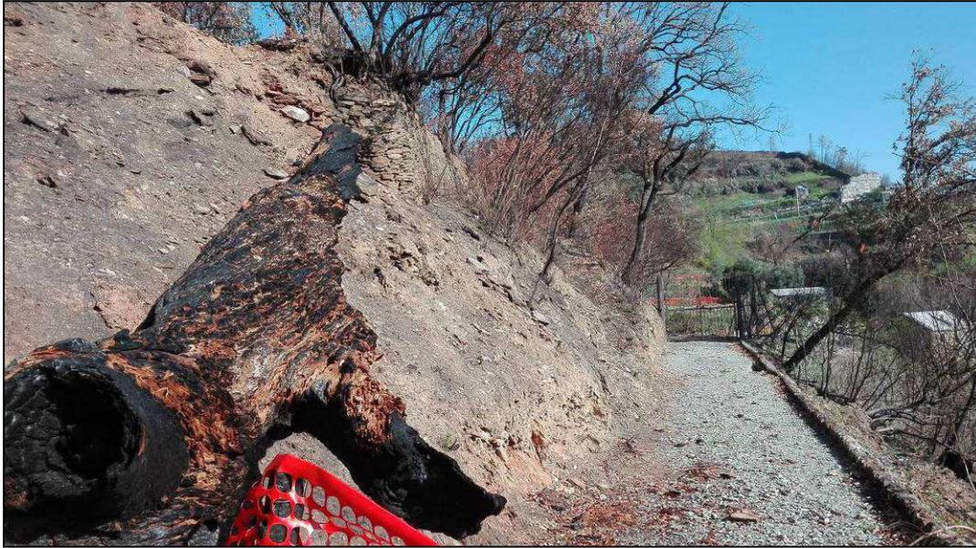
Foto 5: la scarpata a monte del tratto di strada in dissesto si trova in condizioni di erosione e progressivo arretramento per distacco di frammenti e volumi litoidi.
