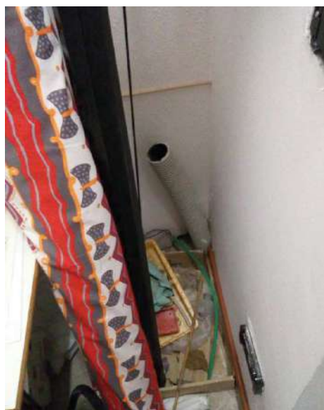
Guaina di predisposizione passaggio condutture dal Quadro elettrico Generale all'Oratorio
