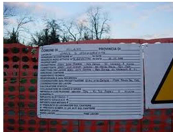
Figura 5.8 – Cartello di cantiere
