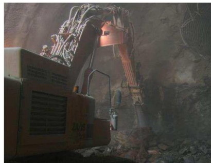
Figura 10.7 – Bagnatura della testa del martellone
