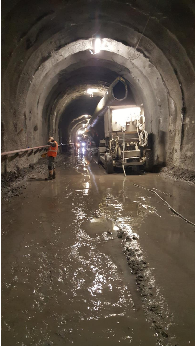
Figura 5 Pista all'interno della galleria
