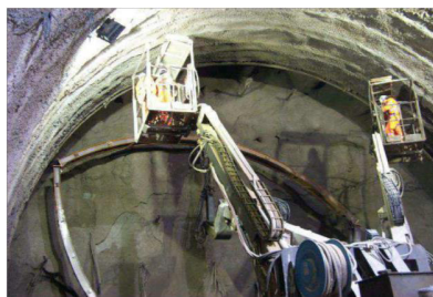
Figura 12.4 – Macchine posa centine
