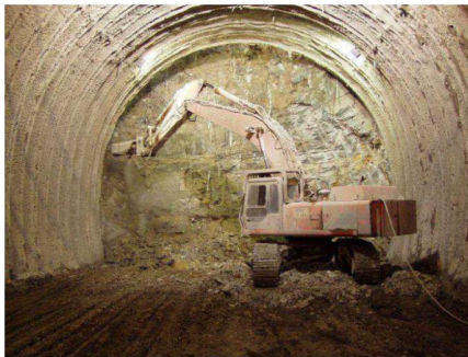
Figura 12.1 – Disgaggio con martellone
