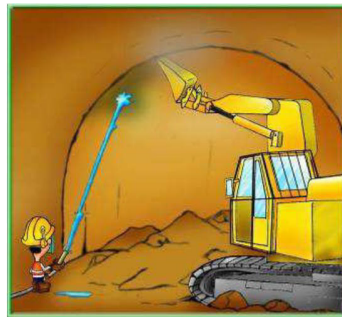
Figura 12.1 – Disgaggio con martellone
