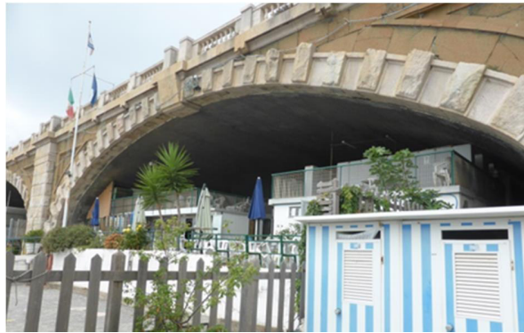
Figura 5.4 - Viste dell'arcata del ponte di C.so Italia
