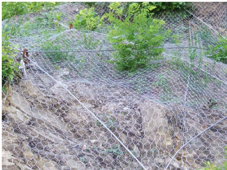
Figura 5 – Esempio applicativo della rete metallica a doppia torsione
