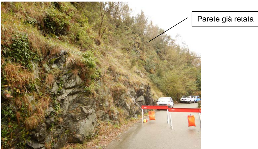
Foto 3 – Foto del tratto meridionale del settore in esame. Sullo sfondo il settore di parete già rivestito di rete metallica in aderenza. In primo piano uno scorcio del più ampio settore di parete rocciosa non presidiata
