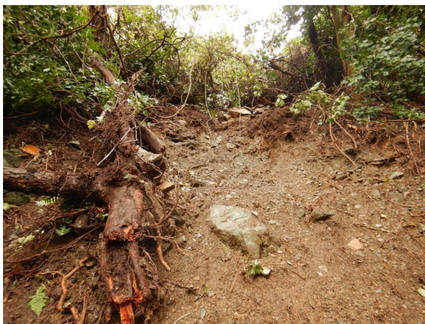
Foto 5 – Lizza di frana e ciglio di distacco nella parte apicale del settore di versante in frana a monte della strada
