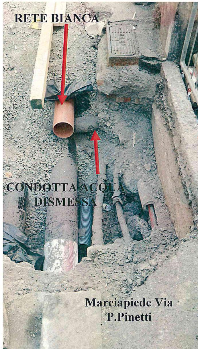
*Figura 5 posizionamento condotte vista da valle a monte (a destra il torrente Fereggiano)
