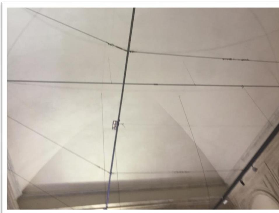
Anche la volta, elemento di grande rilevanza per il monumento, appare – ad un esame visivo non ravvicinato - in condizioni positive, senza manifesti fenomeni di degrado dovuto a percolazioni, solfatazioni, rigonfiamenti o distacchi di intonaco.
