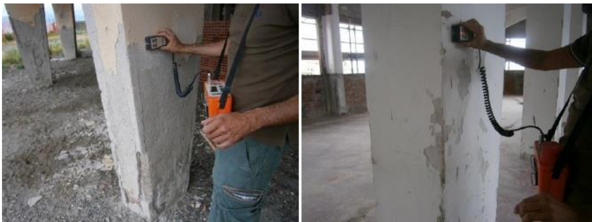
Figura 7. Realizzazione di prova pacometrica
