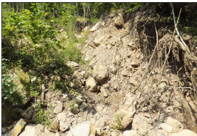
Foto 12: particolare sponda sx da valle verso monte
