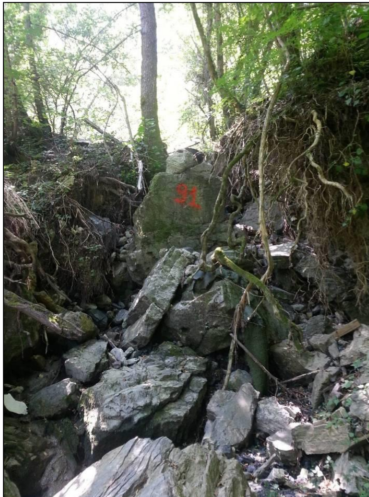
Foto 6: Salto h 3 m alla progressiva 90-91 m
