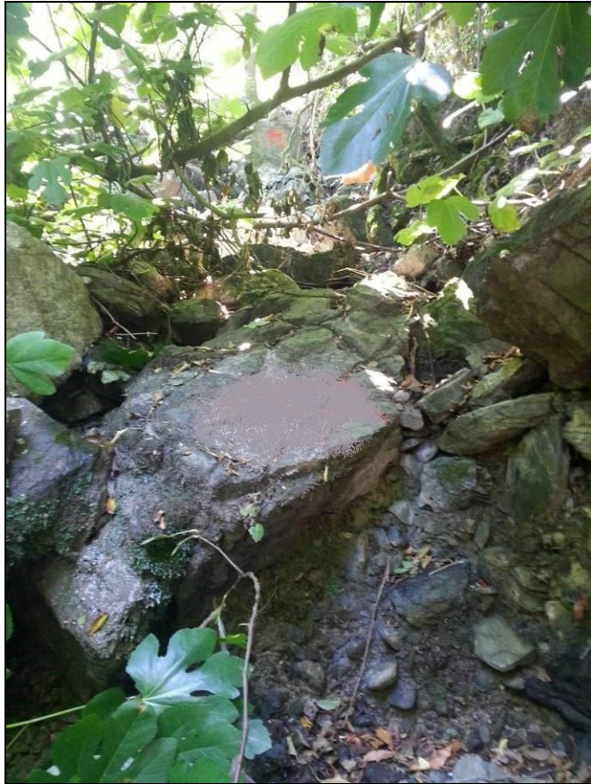
Foto 7: salto h 2 m alla progressiva 95-96 m
