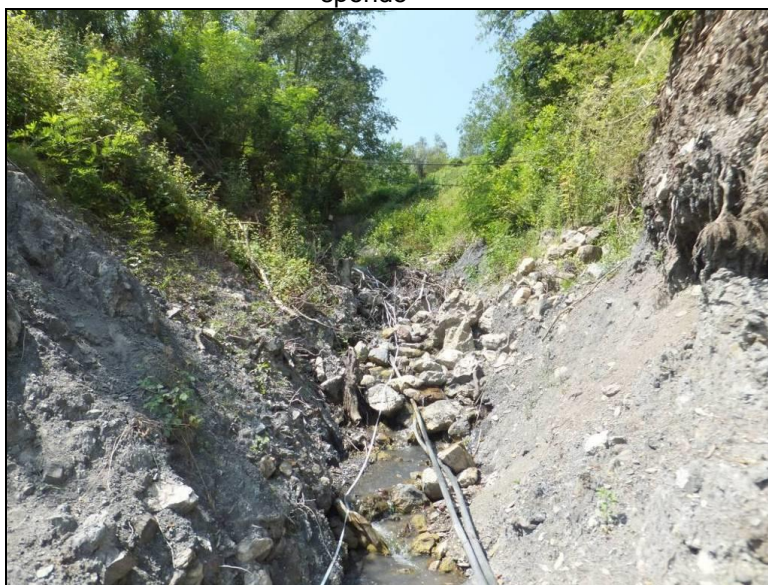
Foto 20: da progressiva 25m verso valle. Persiste situazione di elevato dissesto in entrambe le sponde
