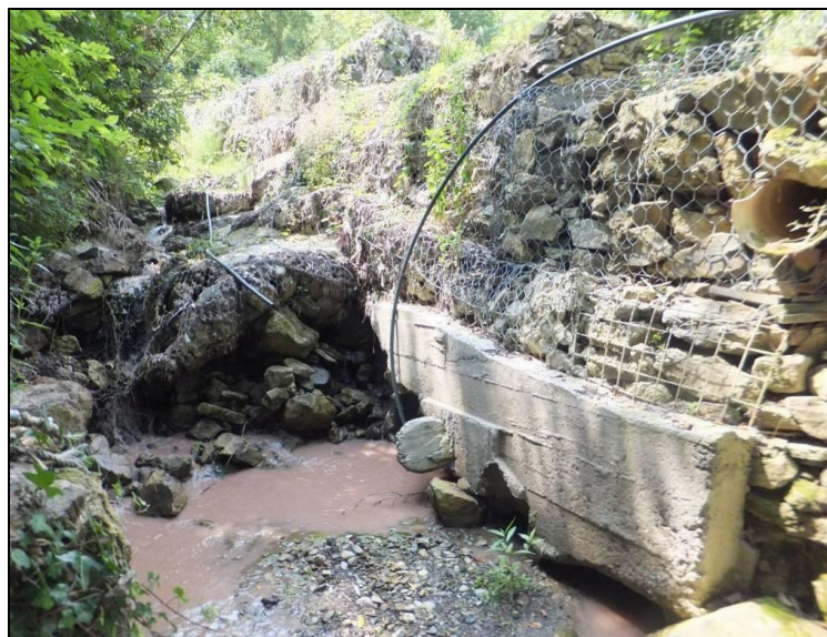
Foto 16: da progressiva 135 m verso monte. Briglia in massi e platea in gabbioni, entrambi in dissesto. Cordolo in ca sponda sx scalzato al piede
