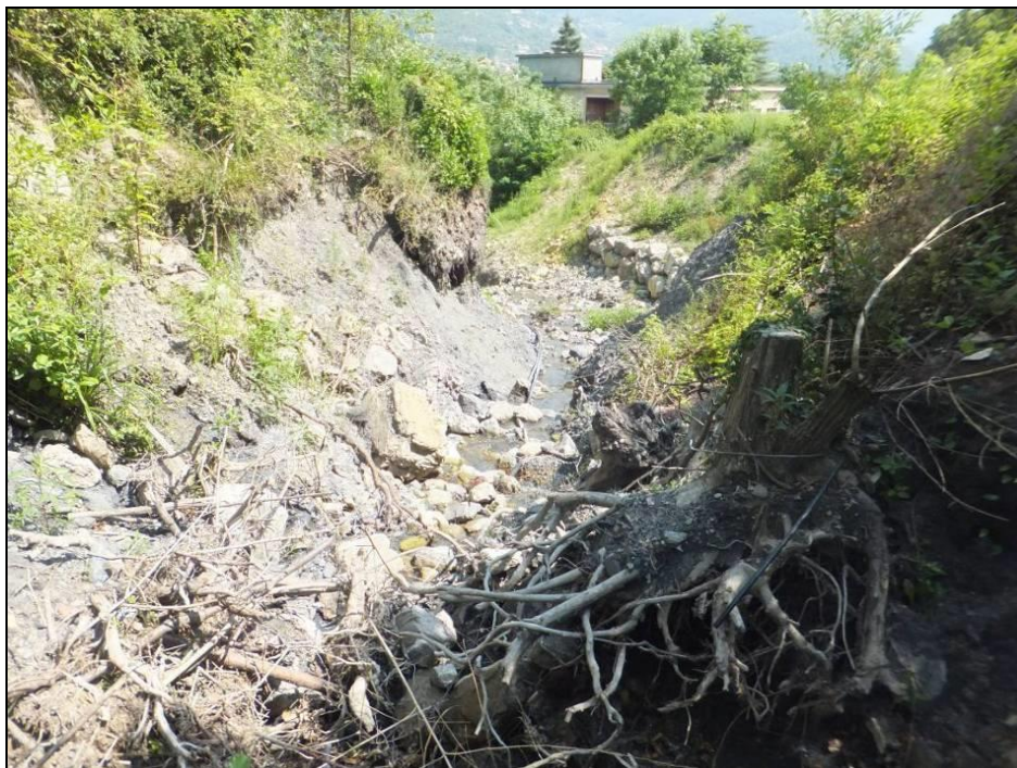
Foto 20: da progressiva 25m verso valle. Persiste situazione di elevato dissesto in entrambe le sponde
