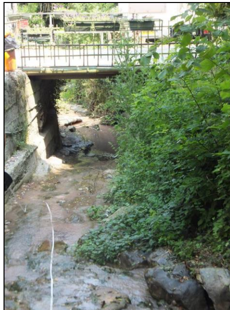
Foto 17: passerella carrabile area Camper vista da monte.
