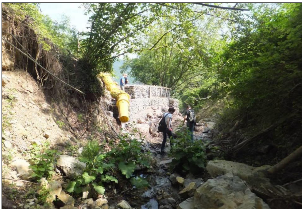
Foto 13: nuovo tratto d'argine in gabbioni presso area Camper tamoia
