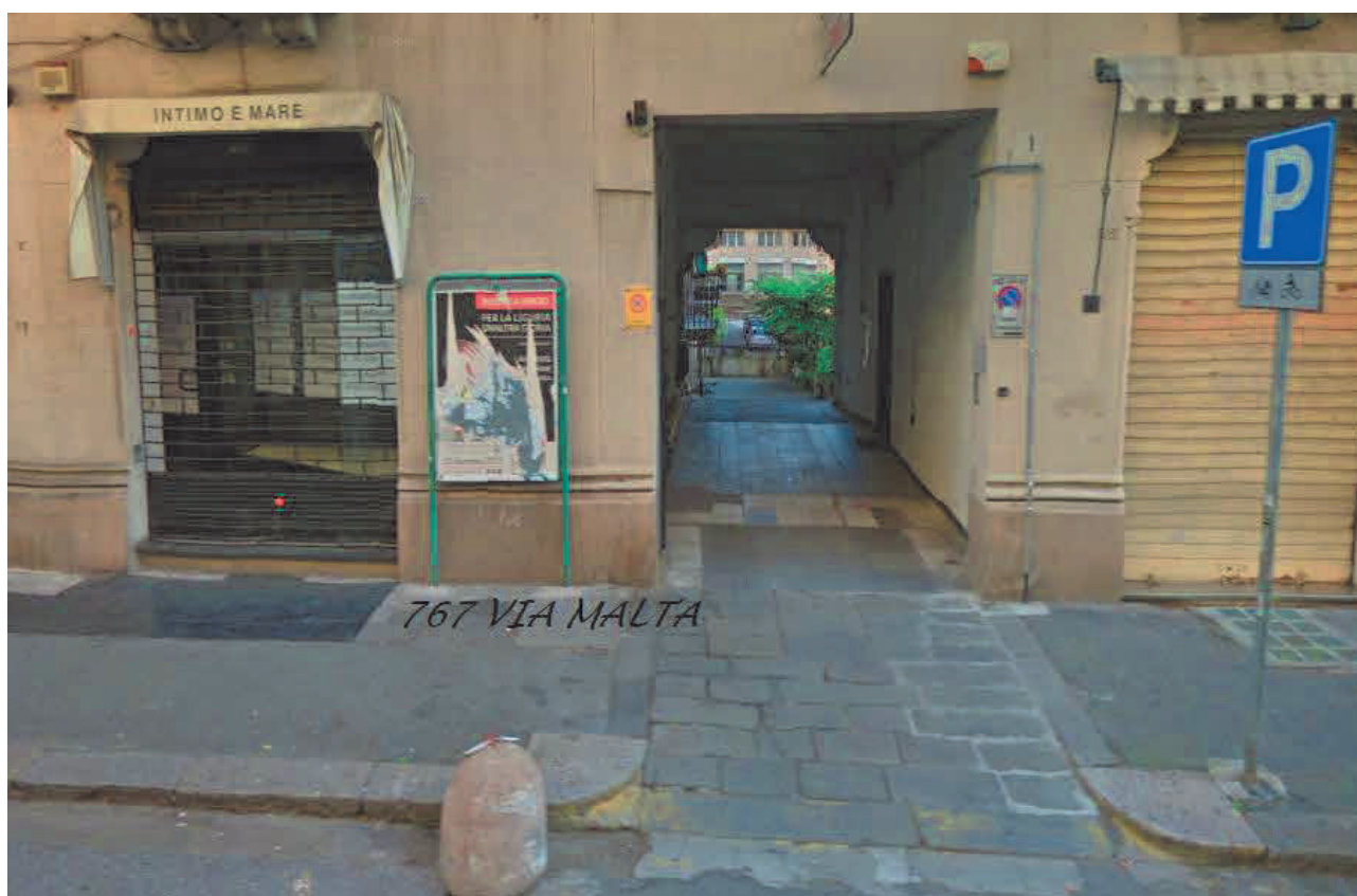
Lotto 23: Impianto n. 767 sito in Via Malta
