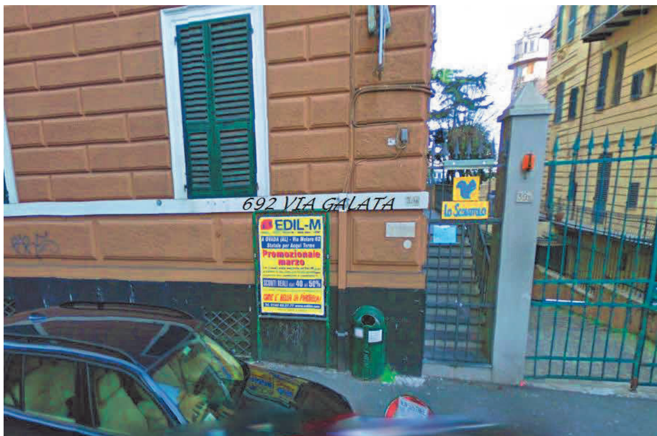
Lotto 16: Impianto n. 692 sito in Via Galata
