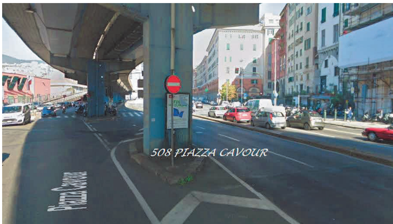
Lotto 7: Impianto n. 508 sito in Piazza Cavour
