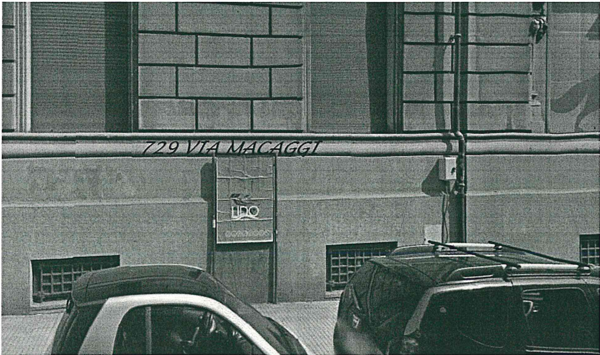
Lotto 19: Impianto n. 729 sito in Via Macaggi
