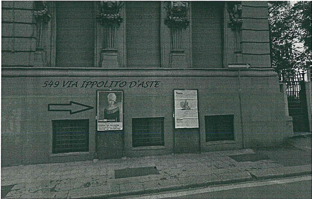
Lotto 11: Impianto n. 549 sito in Via Ippolito d'Aste
