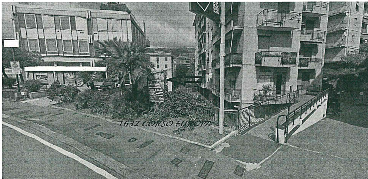
Lotto 45: Impianto n. 1632 sito in Corso Europa
