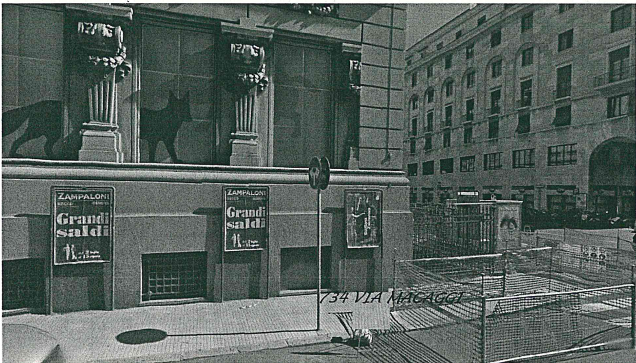
Lotto 20: Impianto n. 734 sito in Via Macaggi
