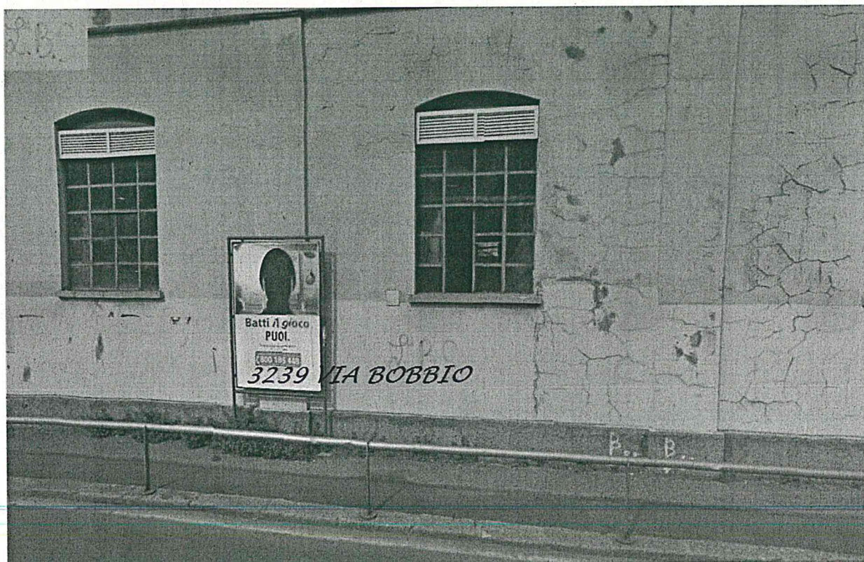
Lotto 62: Impianto n. 3239 sito in Via Bobbio
