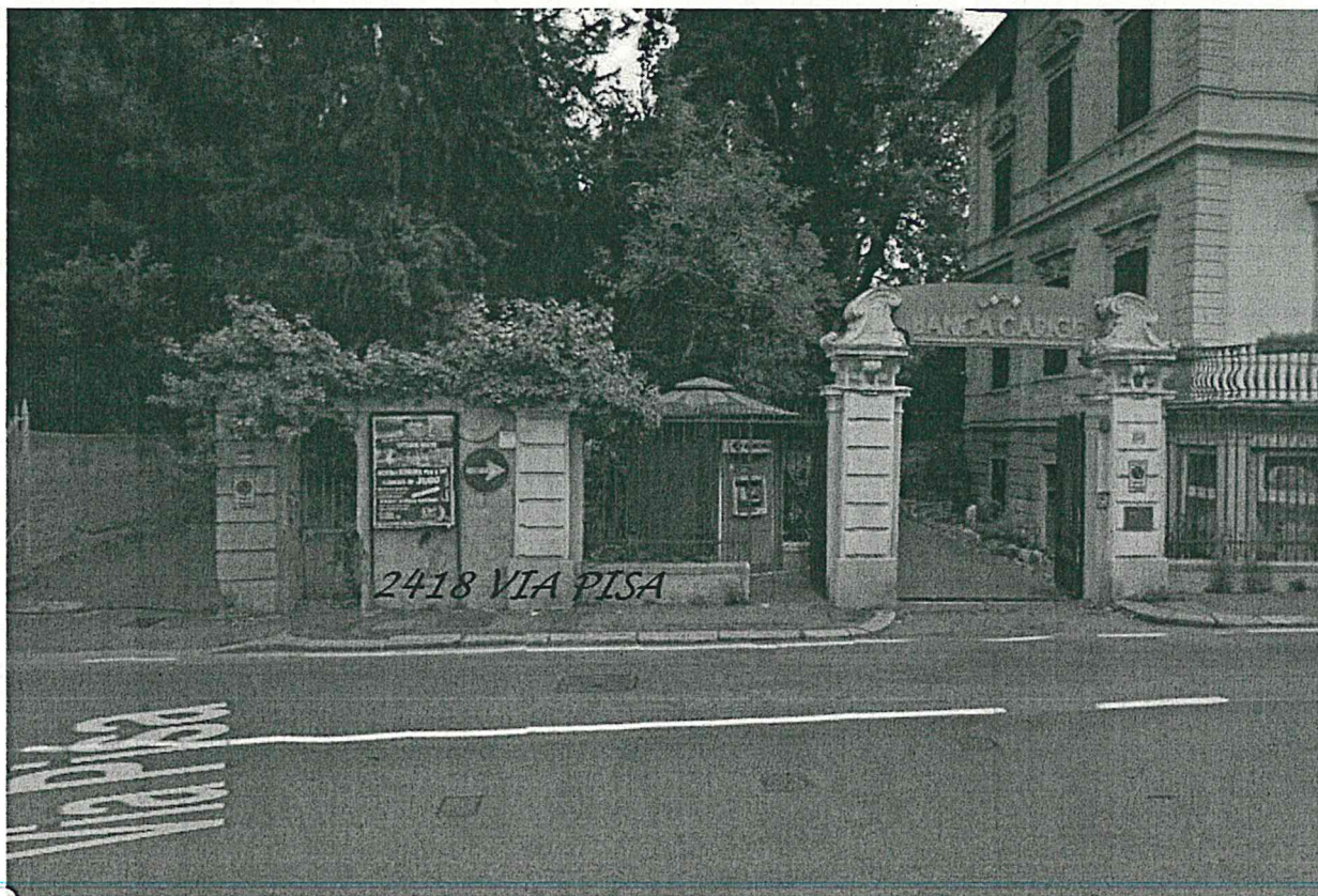
Lotto 54: Impianto n. 2418 sito in Via Pisa
