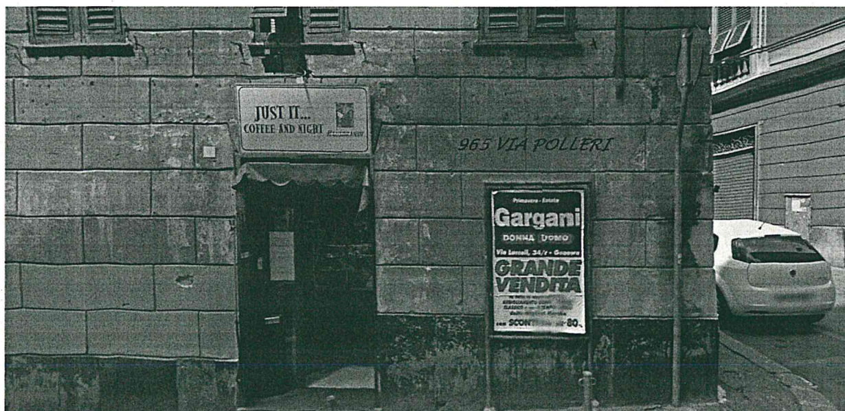
Lotto 31: Impianto n. 965 sito in Via Polleri
