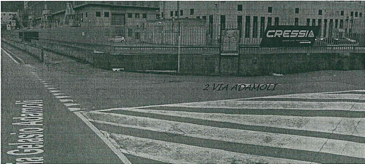
Lotto 1: Impianto n. 2 sito in Via Adamoli
