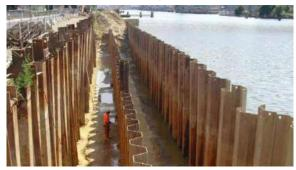
La scelta di questa metodologia, rispetto ad altre, comporta una serie di straordinari vantaggi in termine di riduzione dell'impatto ambientale. Infatti la fornitura di palancole **già pronte all'impiego munite di giunti impermeabili** permetterà oltre che una rapida infissione senza impatto sulle strutture esistenti di poter eseguire la quasi totalità delle lavorazioni in ambiente "confinato e asciutto" comportando:
