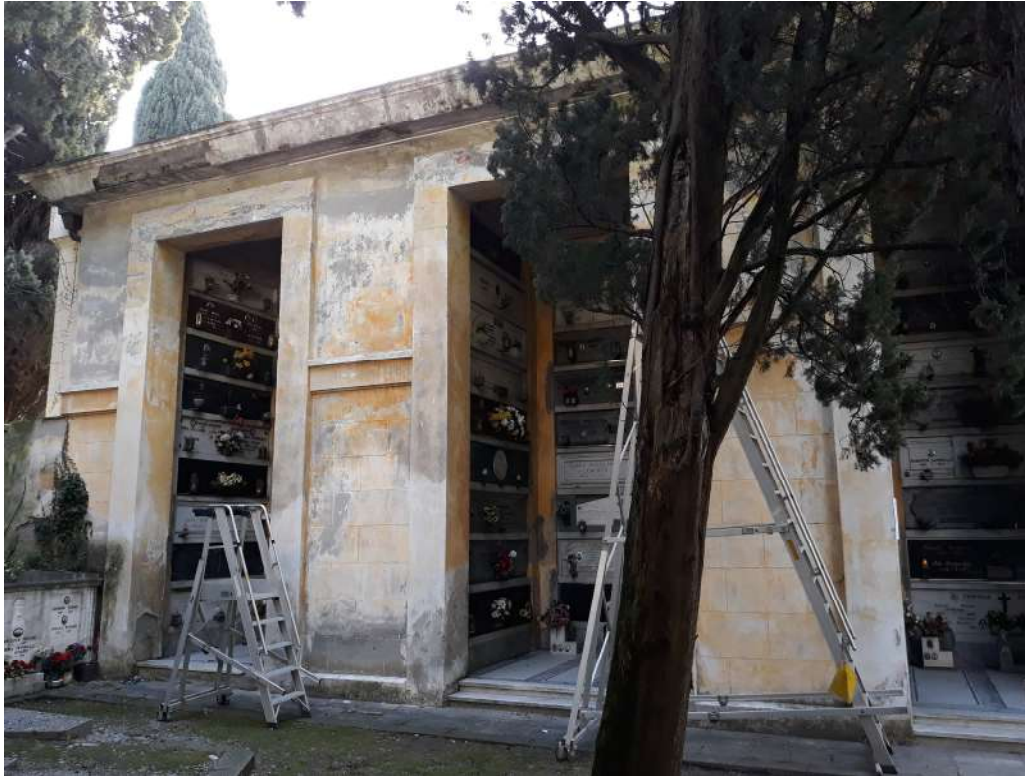
Foto 11 Prospetto Nord– 12 Prospetto Ovest
