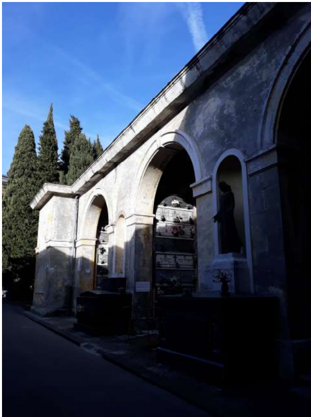
Foto 9 Prospetto ovest– 10 Interni logge e soffitti a cassettoni
