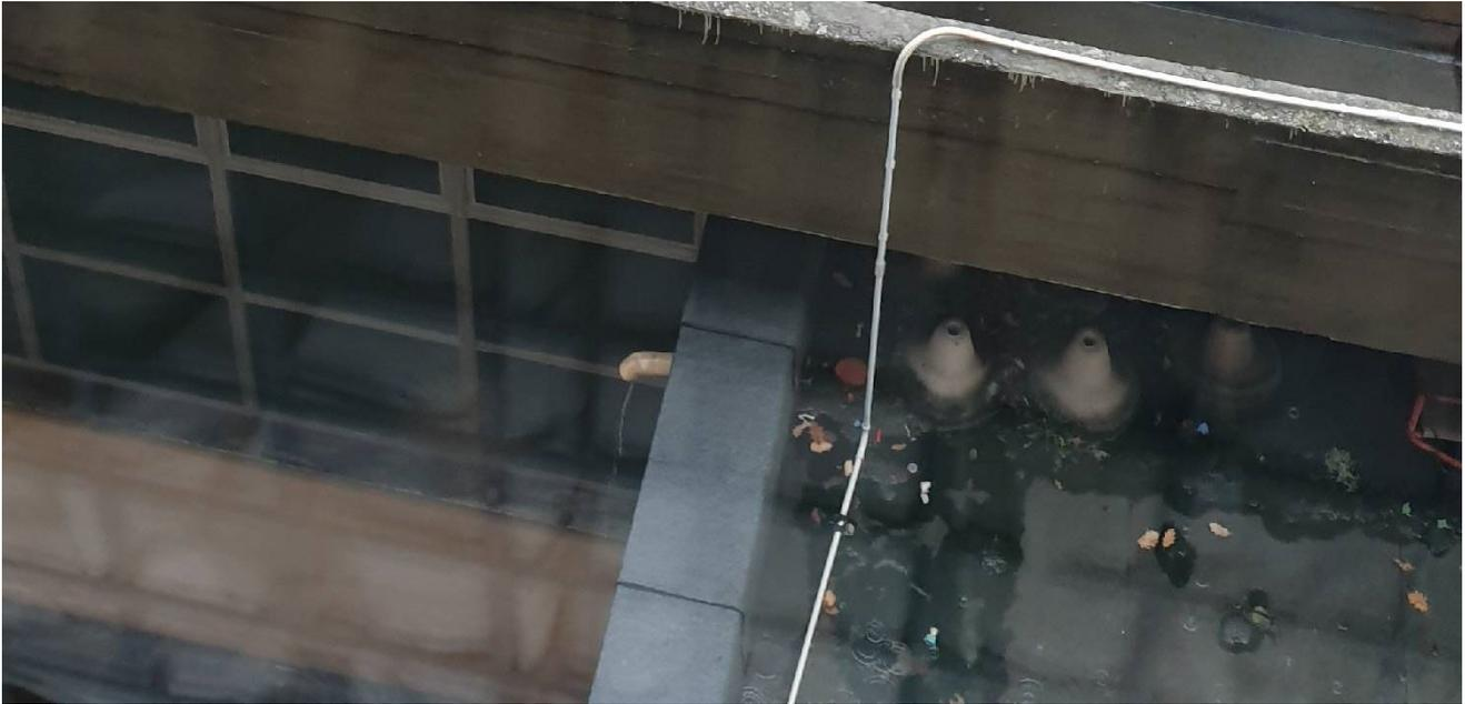
Fig. 3.2.3 – c )Linea dati fissate in modo approssimativo per le aule informatiche piano terzo.
