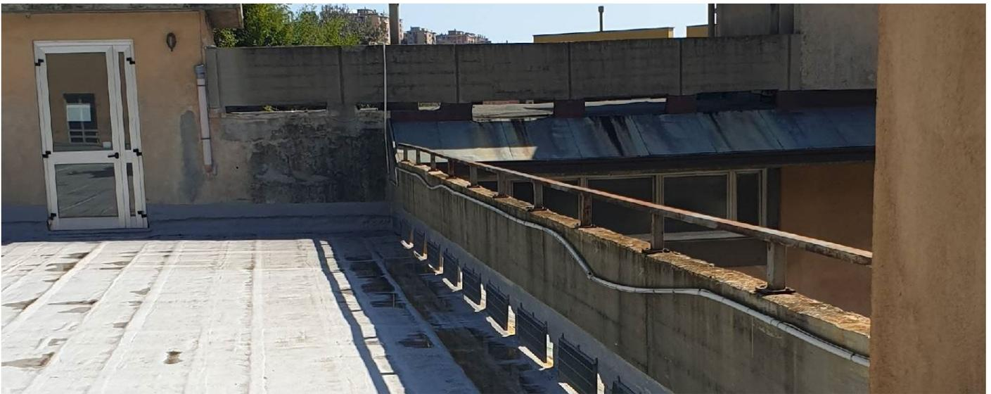
Fig. 3.2.2 – b )Linee elettriche e/o di segnale fissate in modo approssimativo piano secondo.
