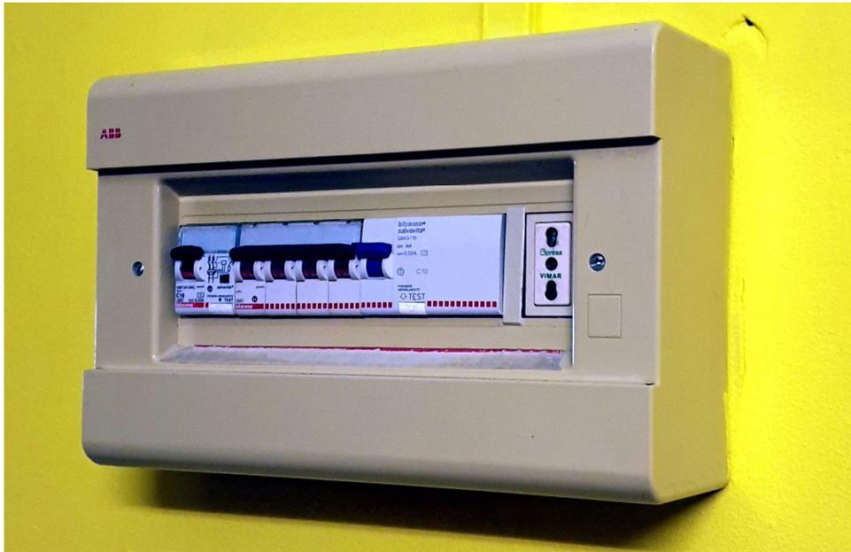
Fig. 3.1.1 – Tipico Quadro Elettrico di Piano. Non vi è portella e quindi i componenti sono direttamente accessibili. Inoltre si trovano posizionati a parete nei corridoi di normale transito delle scolaresche, nonché vie d'esodo in caso di emergenza.
