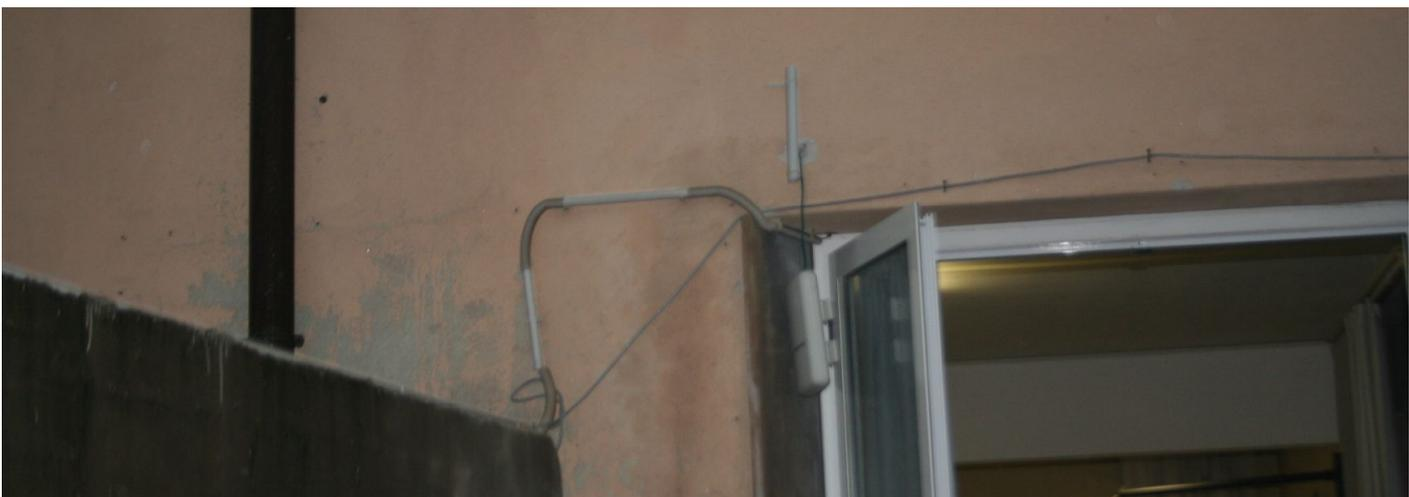
Fig. 3.2.1 – a )Linee elettriche e/o di segnale fissate in modo approssimativo piano primo.
