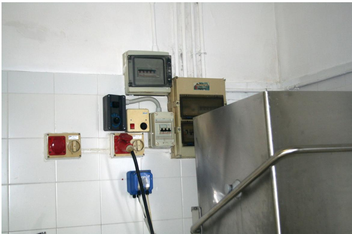
Fig. 3.1.3– Quadro Elettrico Cucina. Sono in realtà diversi quadri, posizionati dietro la macchina lavastoviglie, difficilmente accessibili ed esposti ad umidità e calore.
