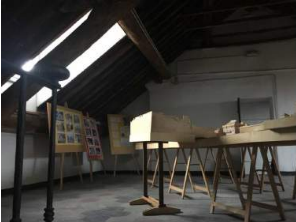
Foto: Locale sottotetto. E' visibile la pavimentazione in cementine che sarà soggetta a rimozione con recupero
