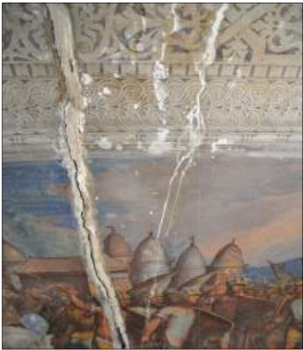
1 DSC_0718: Fessurazione, colature, efflorescenze saline e macchie dovute a infiltrazioni
