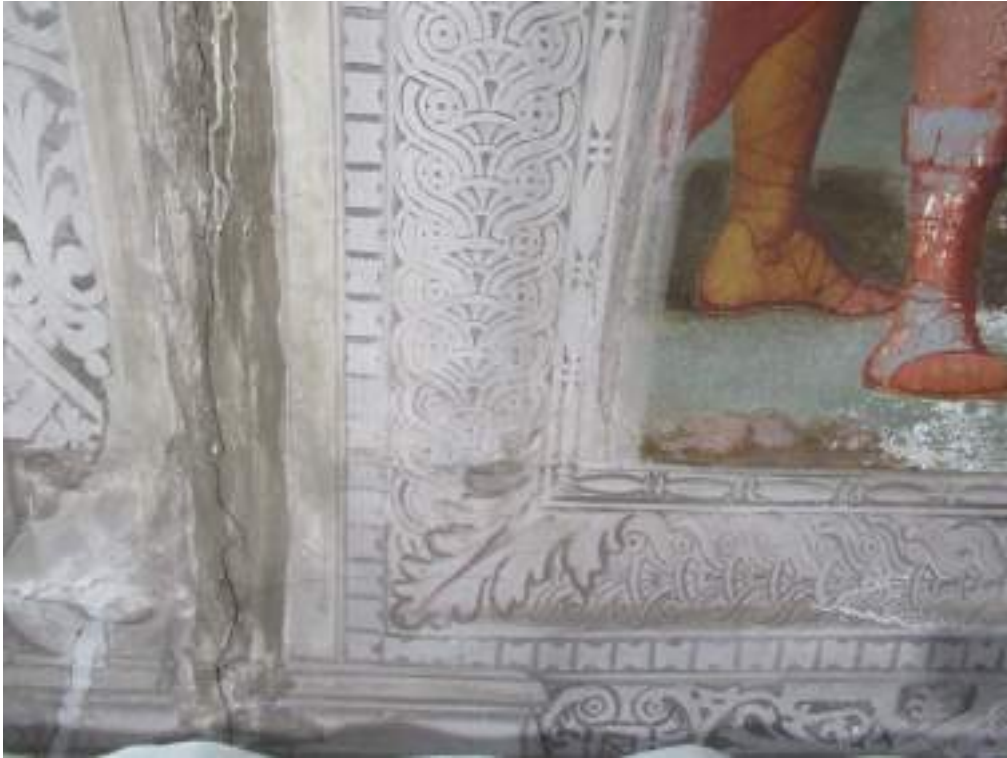
Img. 21 – IMG_0011: lato sud, ridipintura della cornice orizzontale
