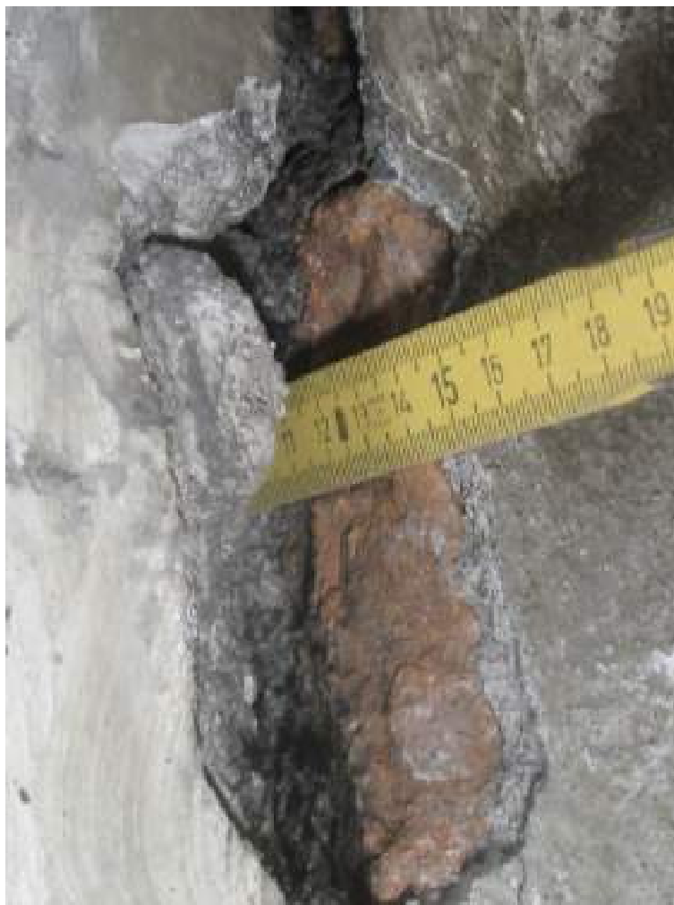
Img. 19 – IMG_0032: angolo sud-est, riempimento in mattoni, visibile dalla fessurazione verticale dell'ovale
