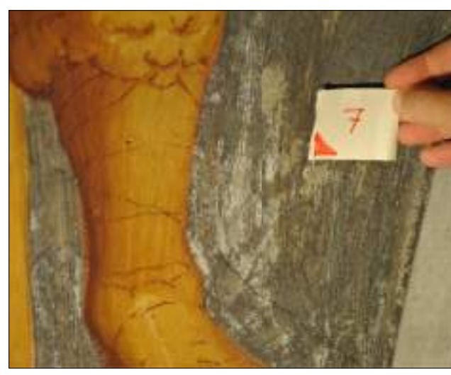
3 DSC_0657: riquadro con statua sud-est, strato compatto ad indicare una ricarbonatazione in superficie (campione n.7)
