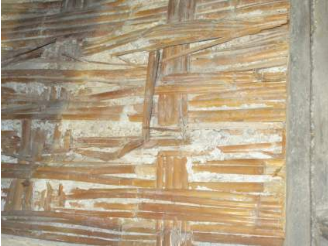
Img. 6 – IMG_0056: estradosso, stuoia di canniccio a seguito di parziale pulitura del deposito incoerente.
