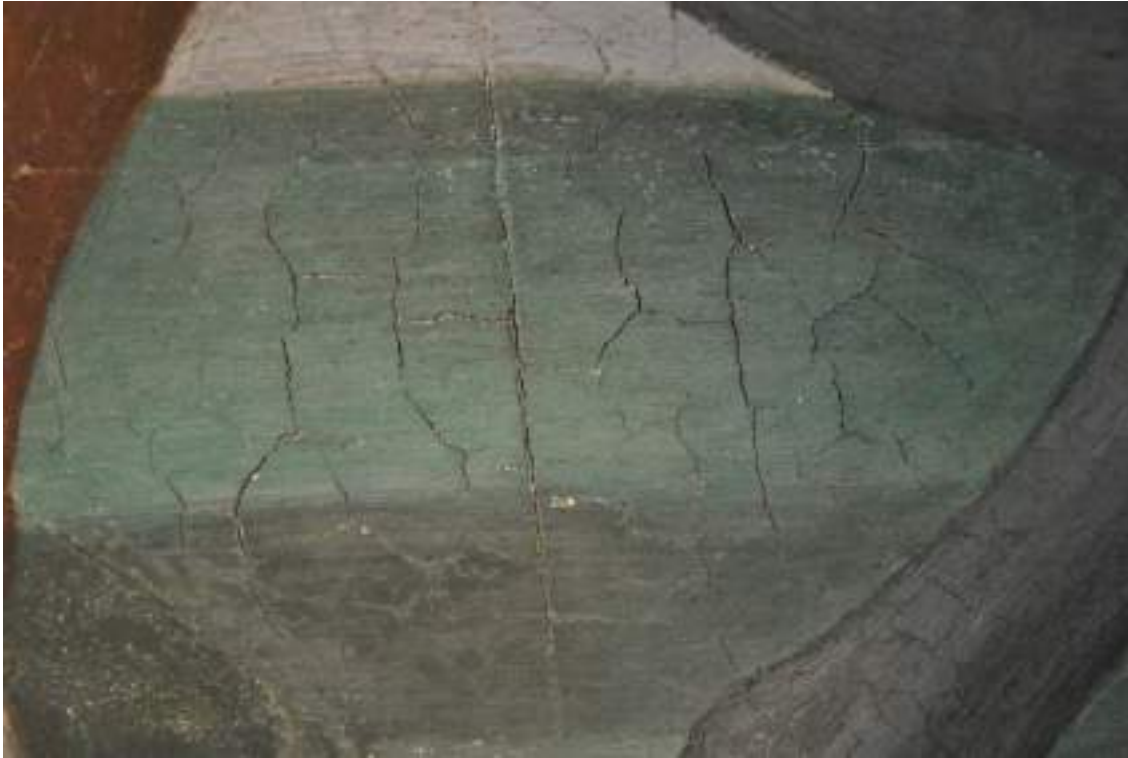
Img. 18 – DSC_0741: specchiatura ovest, crettatura dell'intonaco.
