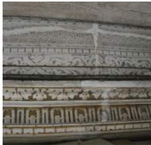
2 DSC_0006: ovest, sopra cornice e sotto cornice
