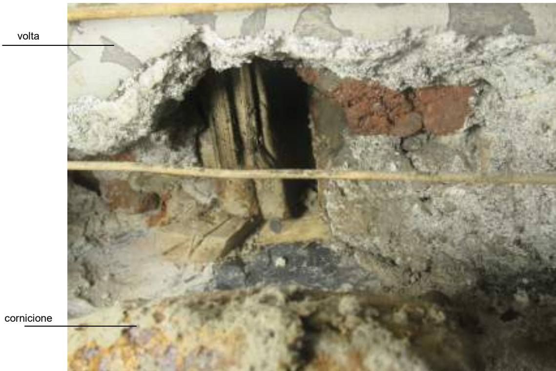
Img. 3 – IMG_0026: lato est, appoggio di una centina lignea, che costituisce parte della struttura portante della volta affrescata. Si nota la presenza di un inzeppamento in legno e di mattoni di riempimento.
