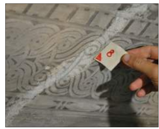
4 DSC_0659: cornice est, i sali sono presenti sulla stuccatura con integrazione pittorica semi-mimetica (campione n.8)
