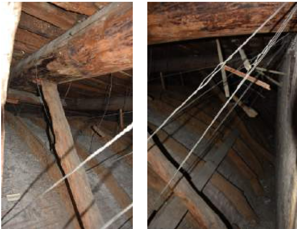
Imgg. 4-5 – DSC_0063 e DSC_0062: estradosso della volta. È visibile la stuoia di canne intrecciate fissata alle centine. Non sono presenti pendini lignei ma solo in filo metallico, forse opera di un intervento successivo.
