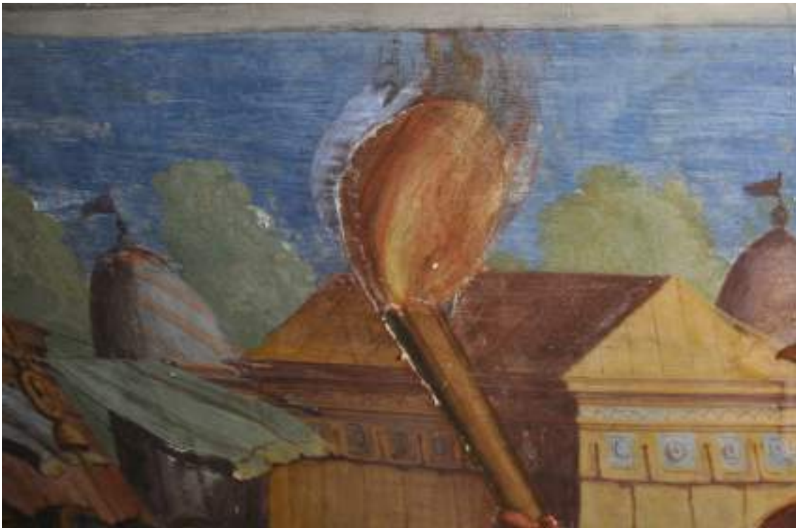
Img. 13 – DSC_0664: efflorescenze saline lungo i margini della giornata.
