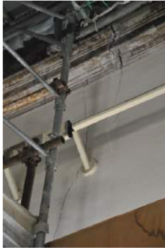
Imgg. 5,6 – DSC_0679 e DSC_0675: fessurazioni sulle pareti. A sinistra l'angolo nord-ovest e a destra l'angolo sud-est.
