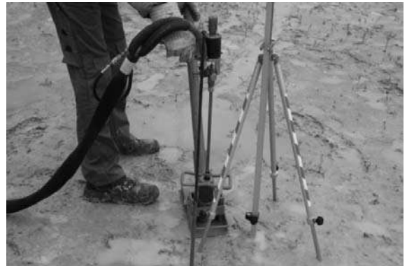
FIG. 17: ESECUZIONE DI UN'INIEZIONE CON CONTEMPORANEA ESTRAZIONE DELLA LANCIA
