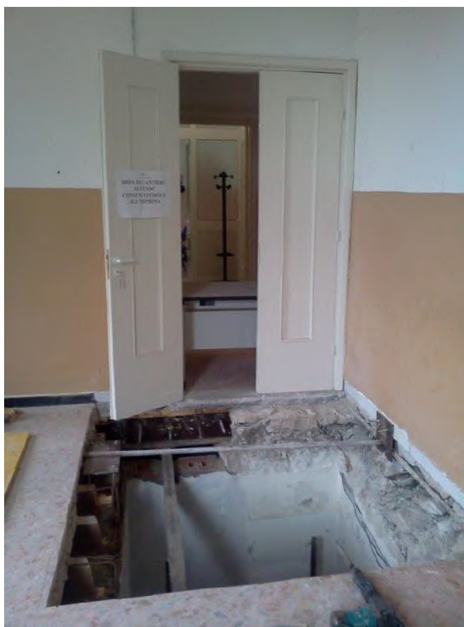
Fotografia relativa al foro nel solaio del piano primo realizzato per l'esecuzione della fossa dell'ascensore, da cui si può vedere la tessitura sia dei muri portanti in pietra sia del solaio in legno. Inoltre, si possono vedere le catene di piano, nelle dure direzioni nonché la putrella in acciaio di rinforzo trasversale ai travetti di legno.
