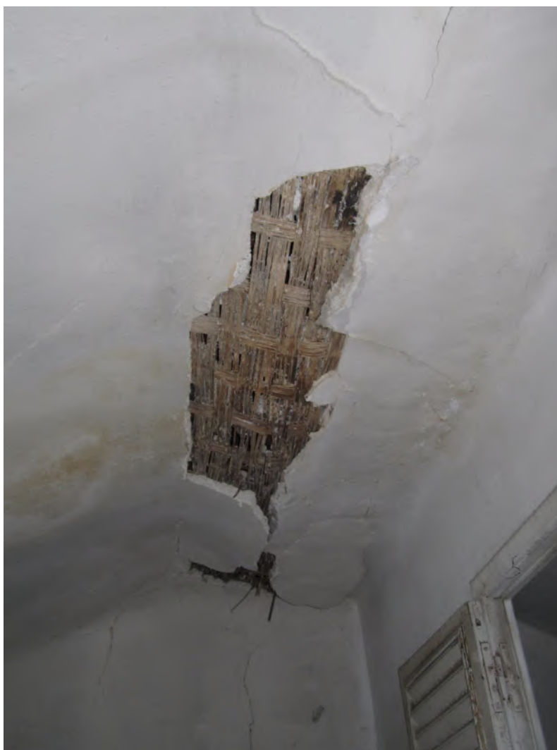
Figura 18. Particolare rigonfiamento del controsoffitto in cannicci, per infiltrazioni d'acqua dalla copertura con estesi distaccamenti di intonaco.
