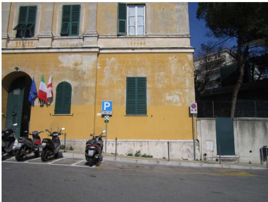
Figura 5. Particolare muro esistente a destra della facciata principale a delimitazione del giardino privato.
