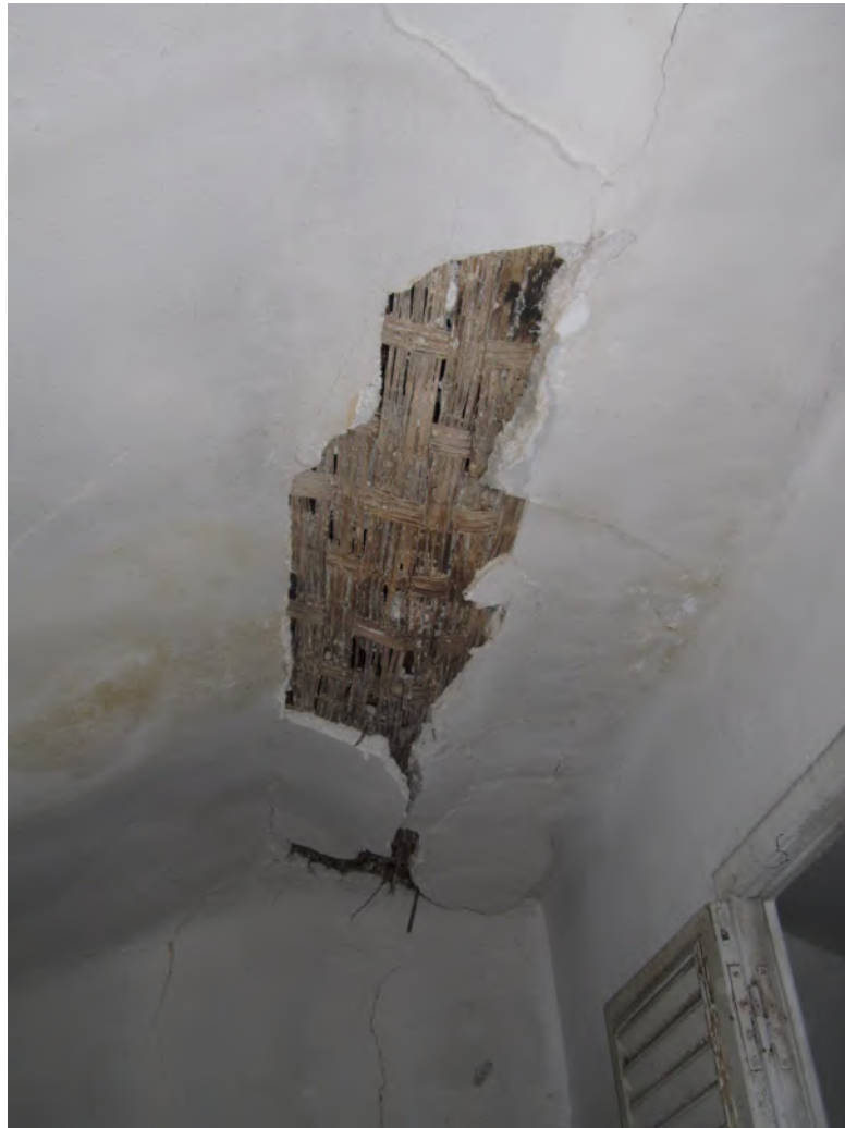
Figura 44. Particolare controsoffitto in cannicci esistente.
