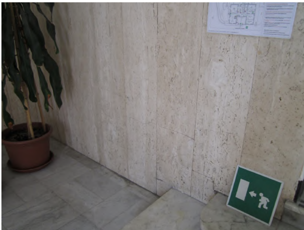
Figura 29. Particolare pavimentazione ingresso.
