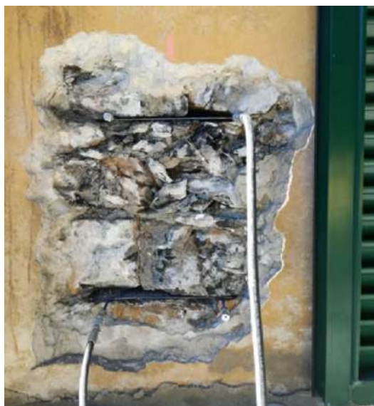
Figura 54. Tipico della trama muraria costituente i pannelli murari portanti al PT.
