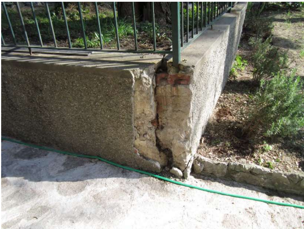
Figura 27. Apertura spigolo muro.
