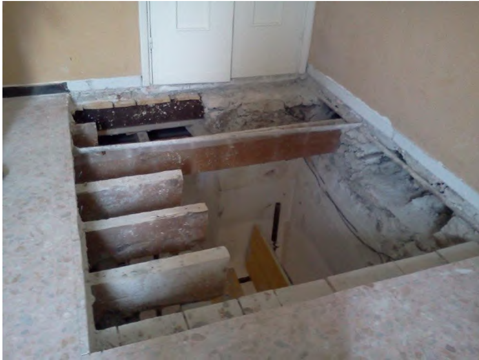
Figura 12. Fotografia relativa al foro nel solaio del piano primo realizzato per l'esecuzione della fossa dell'ascensore, da cui si può vedere la tessitura sia dei muri portanti in pietra sia del solaio in legno con i rinforzi in acciaio. Inoltre, si possono vedere le catene di piano, nelle due direzioni, inserite all'interno del solaio stesso.
