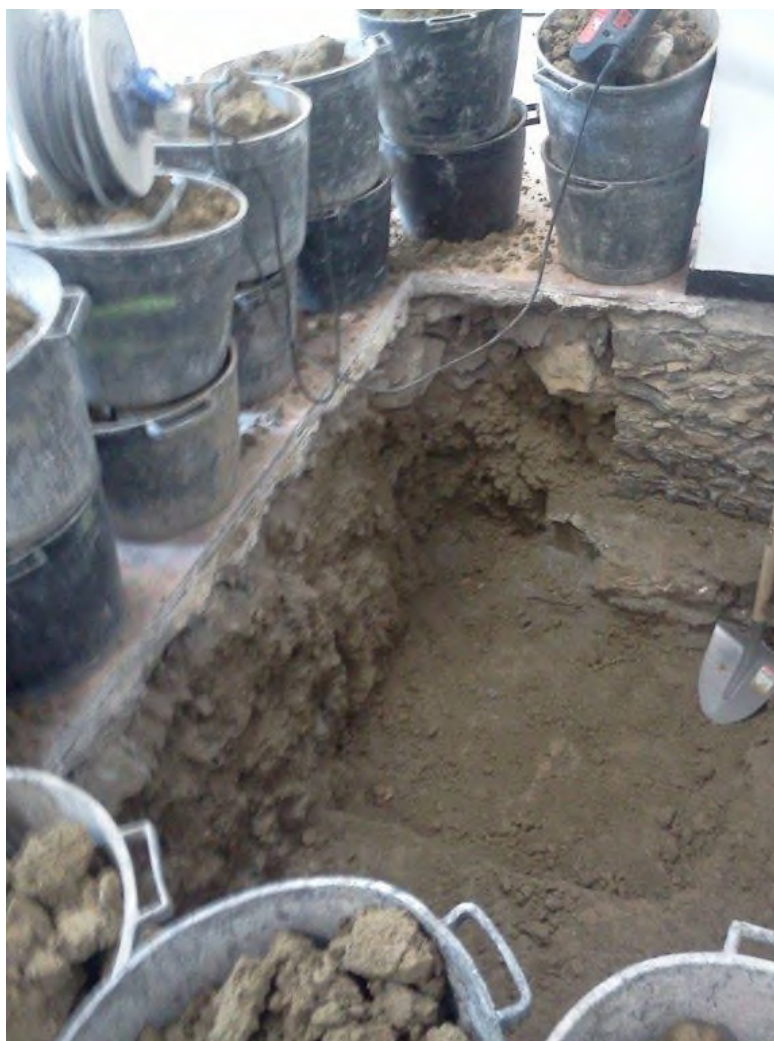
Figura 30. Fotografia eseguita dal Comune di Genova in occasione della realizzazione del vano ascensore.
