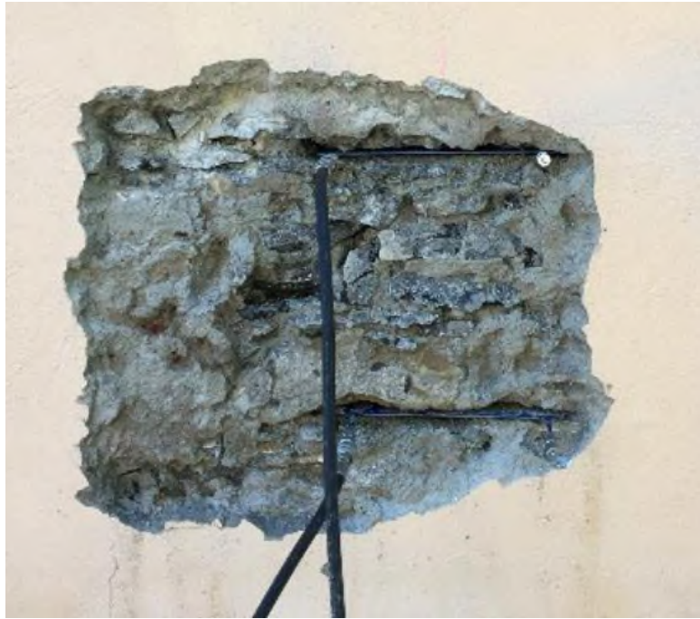
Figura 55. Tipico della trama muraria costituente i pannelli murari portanti al P1.
