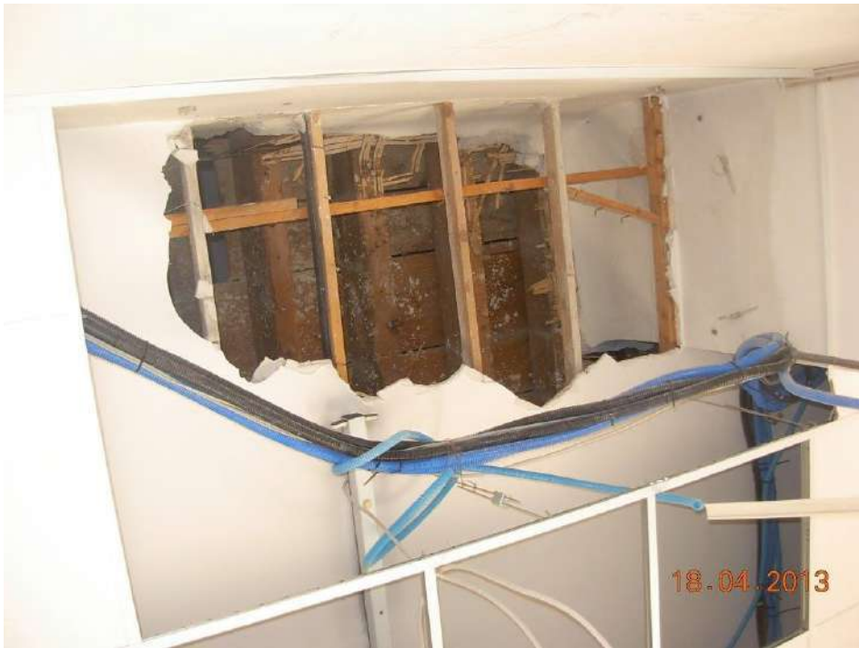
Fotografia relativa alla tessitura del solaio in legno e della struttura di controsoffitto esistente.
