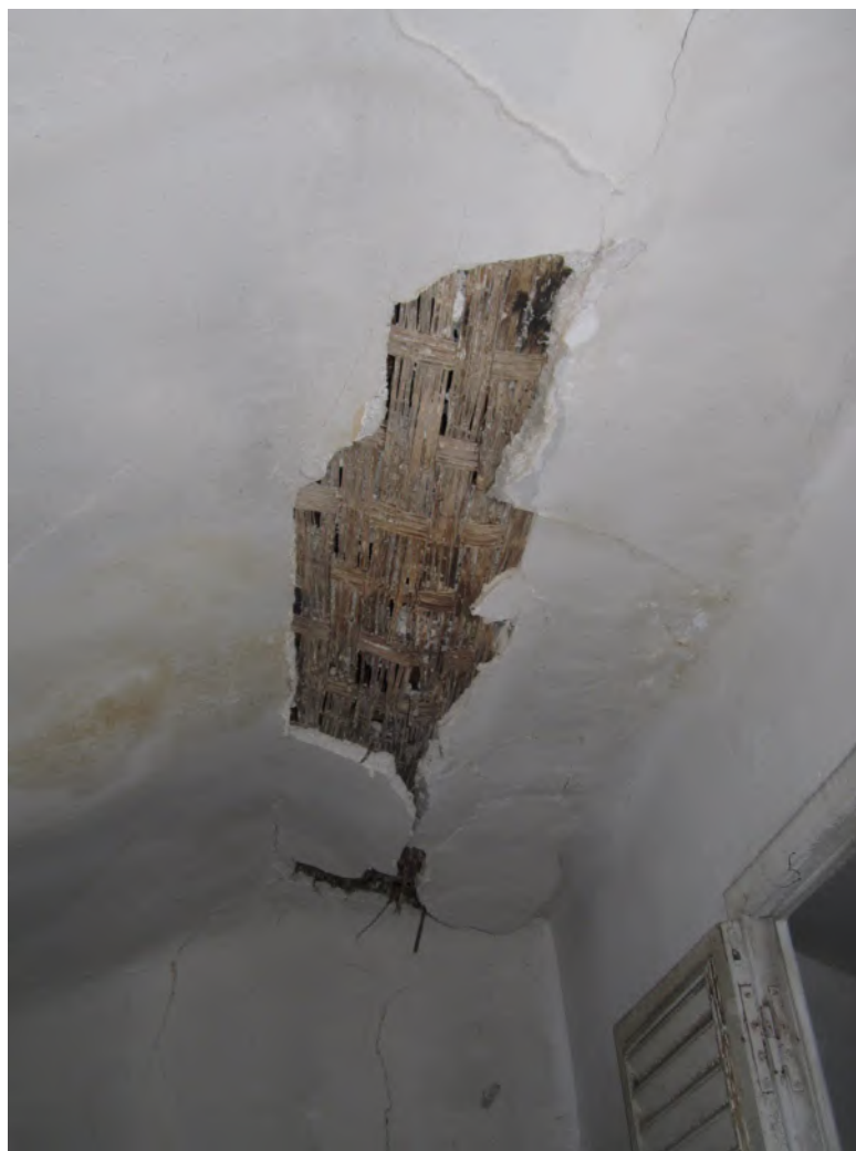
Figura 43. Particolare controsoffitto in cannicci esistente.
