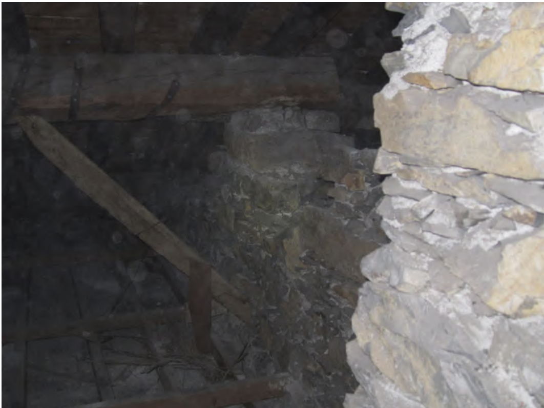
Figura 17. Particolare della struttura muraria in pietra nuda presente nel sottotetto
