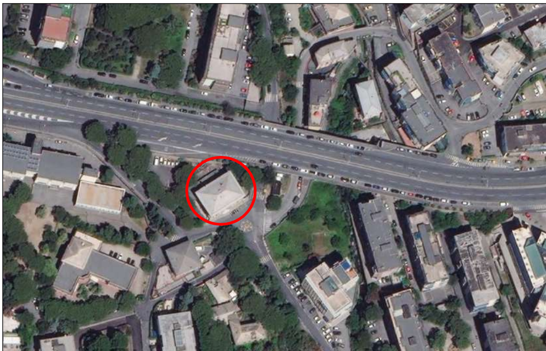
COMUNE DI GENOVA – VISTA AEREA DI DETTAGLIO
