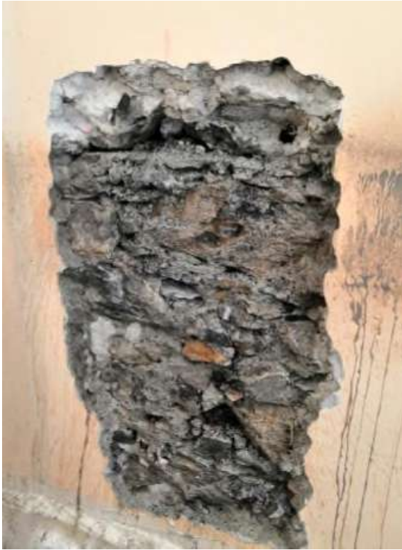
Figura 5. Tipico della trama muraria costituente i pannelli murari portanti al P2.
