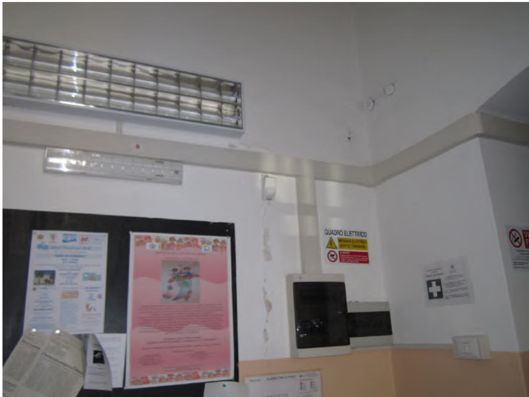
Figura 37. Lesione su parete portante centrale piano primo lato scala.
