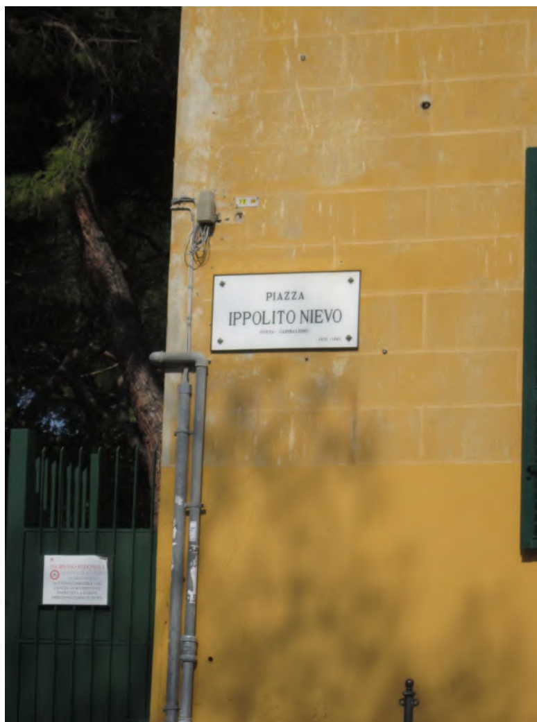
Figura 23. Lesione sub-verticale nell'angolata sinistra del prospetto nord-ovest.
