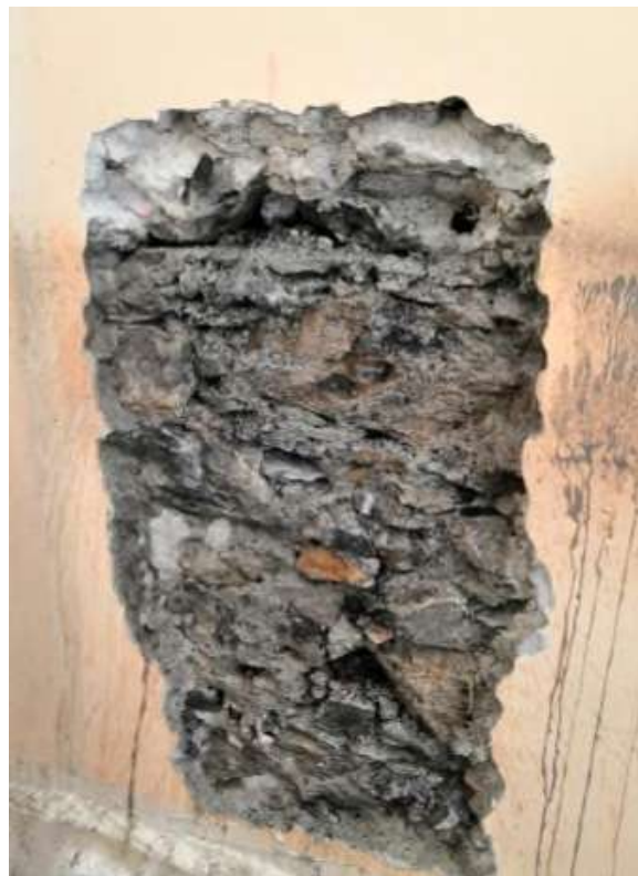
Figura 56. Tipico della trama muraria costituente i pannelli murari portanti al P2.
