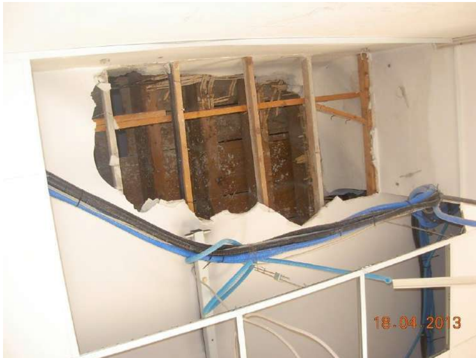
Figura 13. Fotografia relativa alla tessitura del solaio in legno e della struttura di controsoffitto esistente.
