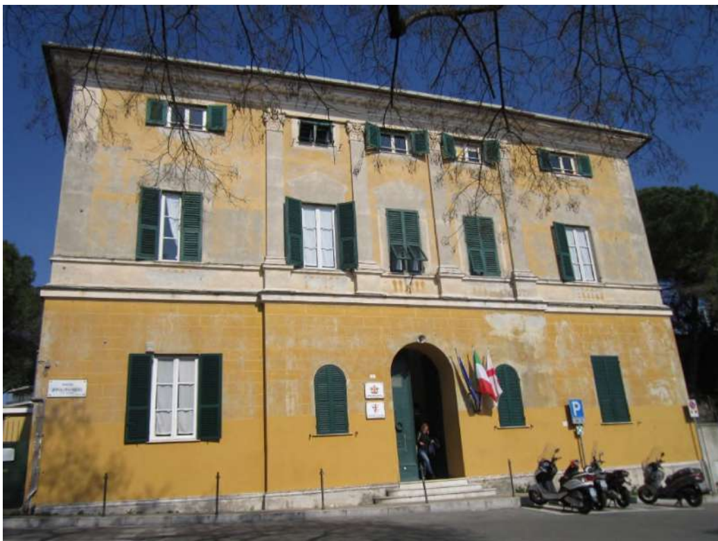
Figura 2. Facciata principale edificio in Piazza Ippolito Nievo n.1
