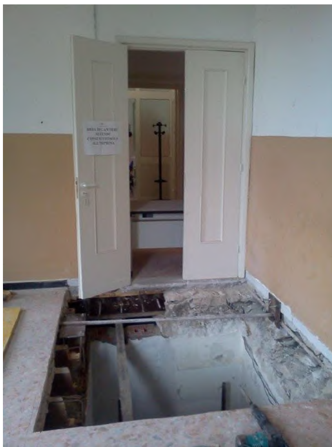
Figura 15. Fotografia relativa al foro nel solaio del piano primo realizzato per l'esecuzione della fossa dell'ascensore, da cui si può vedere la tessitura sia dei muri portanti in pietra sia del solaio in legno. Inoltre, si possono vedere le catene di piano, nelle due direzioni nonché la putrella in acciaio di rinforzo trasversale ai travetti di legno.
