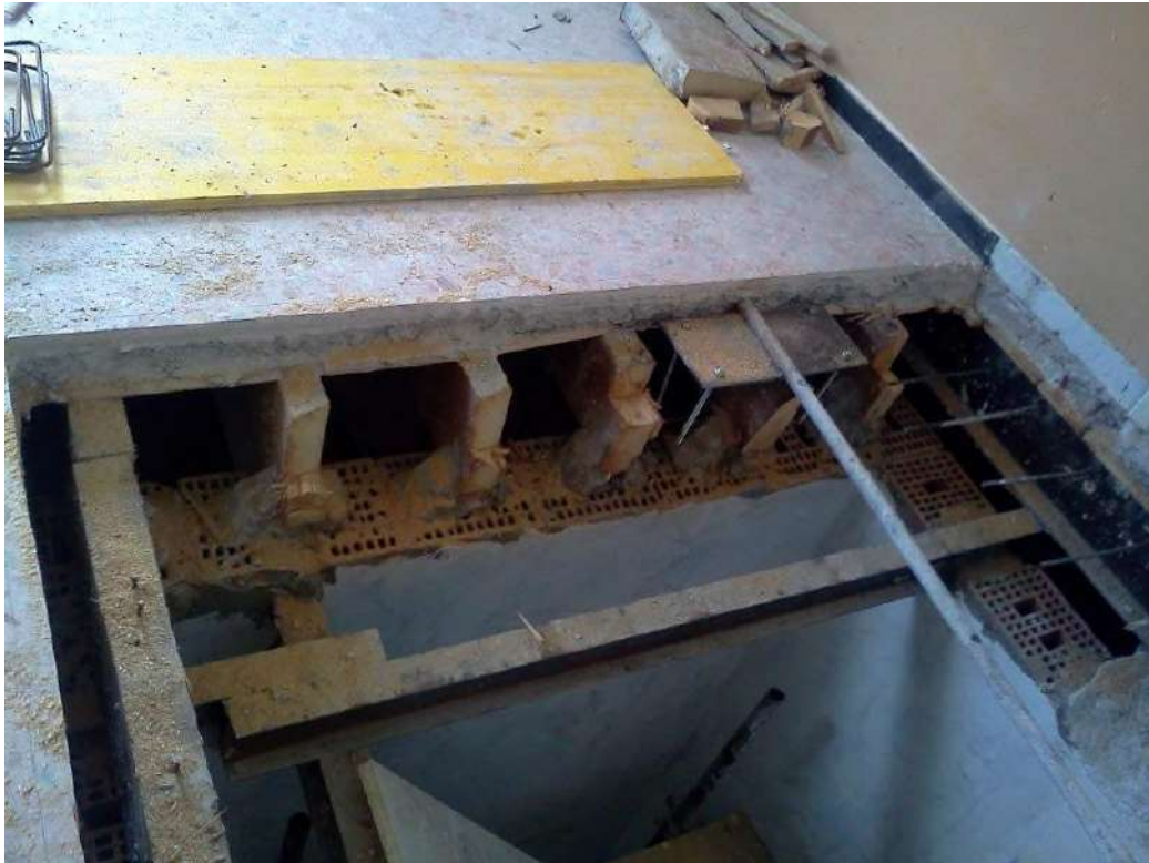
Figura 35. Fotografia eseguita dal Comune di Genova in occasione della realizzazione del vano ascensore.
