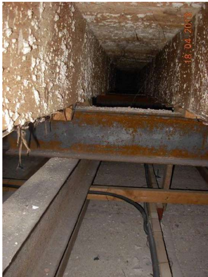
Fotografia relativa al particolare della tessitura del solaio in legno e della struttura di rinforzo in acciaio.
