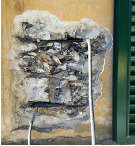
Figura 3. Tipico della trama muraria costituente i pannelli murari portanti al PT.
