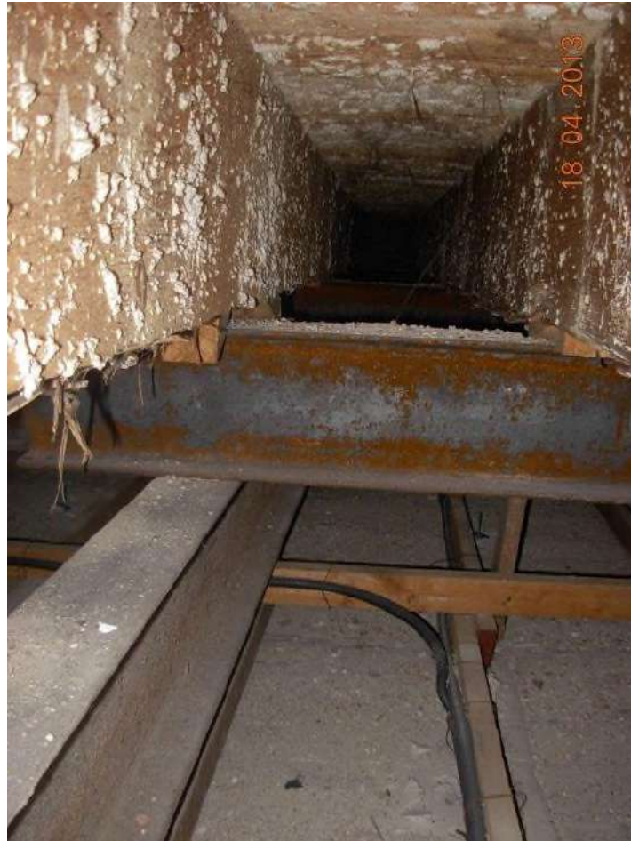
Figura 14. Fotografia relativa al particolare della tessitura del solaio in legno e della struttura di rinforzo in acciaio.
