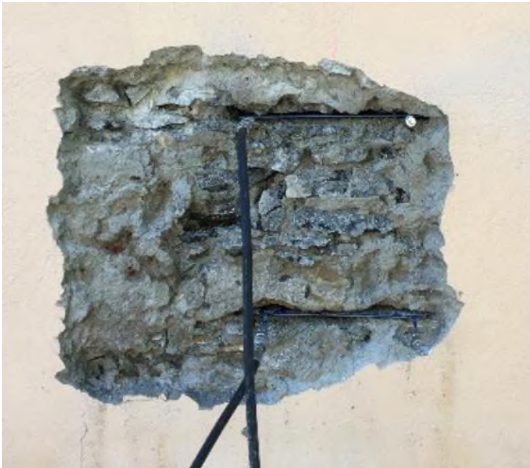
Figura 4. Tipico della trama muraria costituente i pannelli murari portanti al P1.
