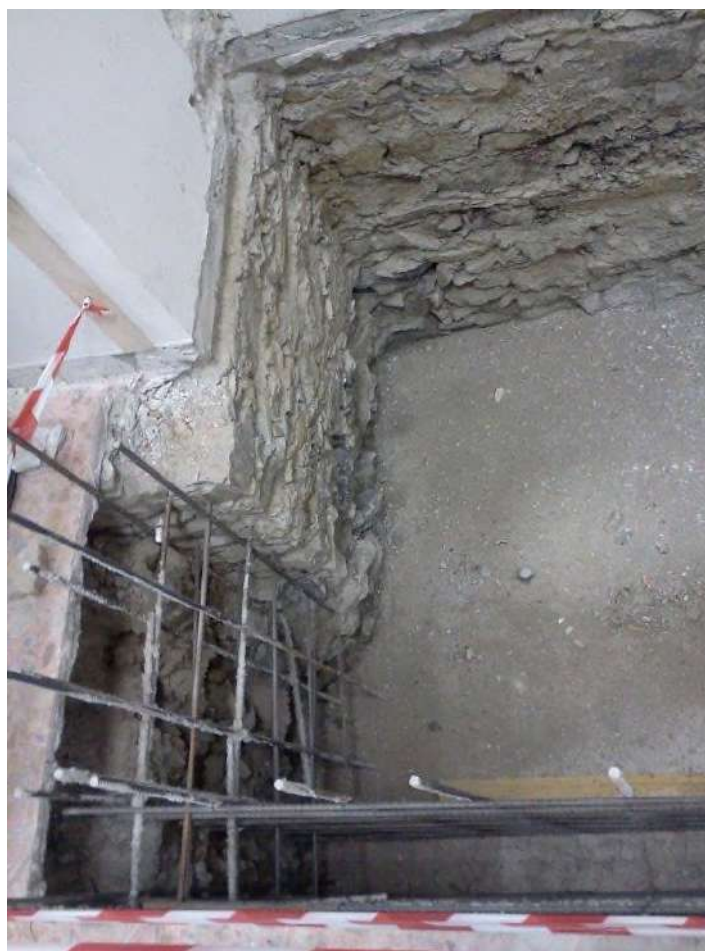
Figura 11. Fotografia particolare relativo allo scavo eseguito per l'esecuzione della fossa dell'ascensore, da cui si può vedere la tessitura muraria portante in pietra
