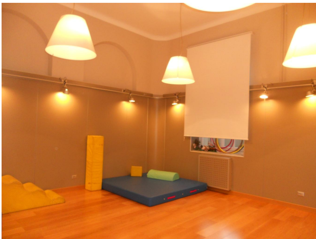
Foto n. 5 – Aula del secondo piano: trattamento con vernice ignifuga del pavimento in legno
