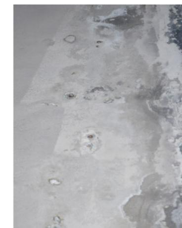
Macchia di umidità ed efflorescenza salina (interno retro archi)
