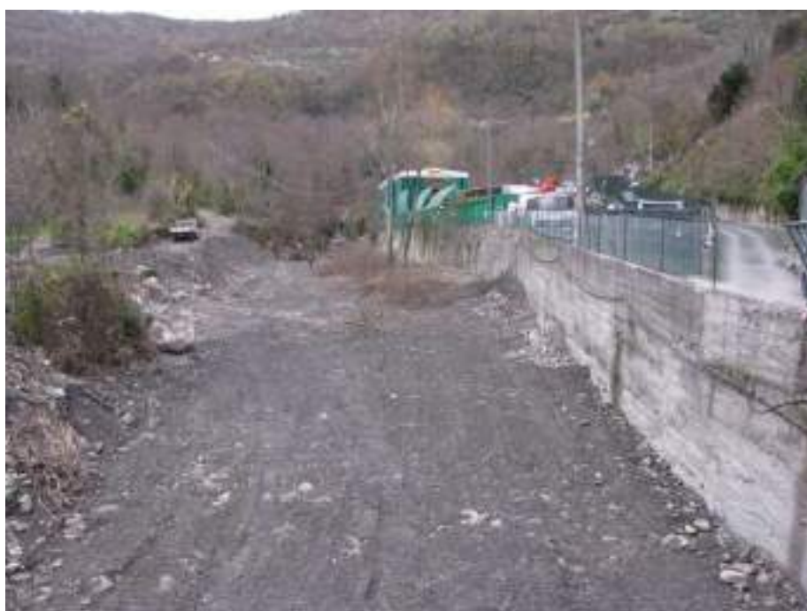
Foto 6 – Il Rio Maggiore ripreso dal ponte che chiude il settore di intervento, evidentemente ingombro di materiali e con sovralluvionamento ancora evidente nella foto in basso (post-alluvione)
