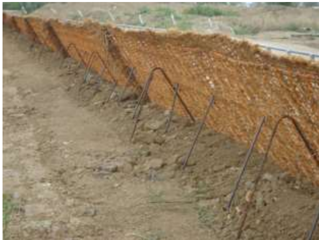
Tiranti di irrigidimento del frontale
