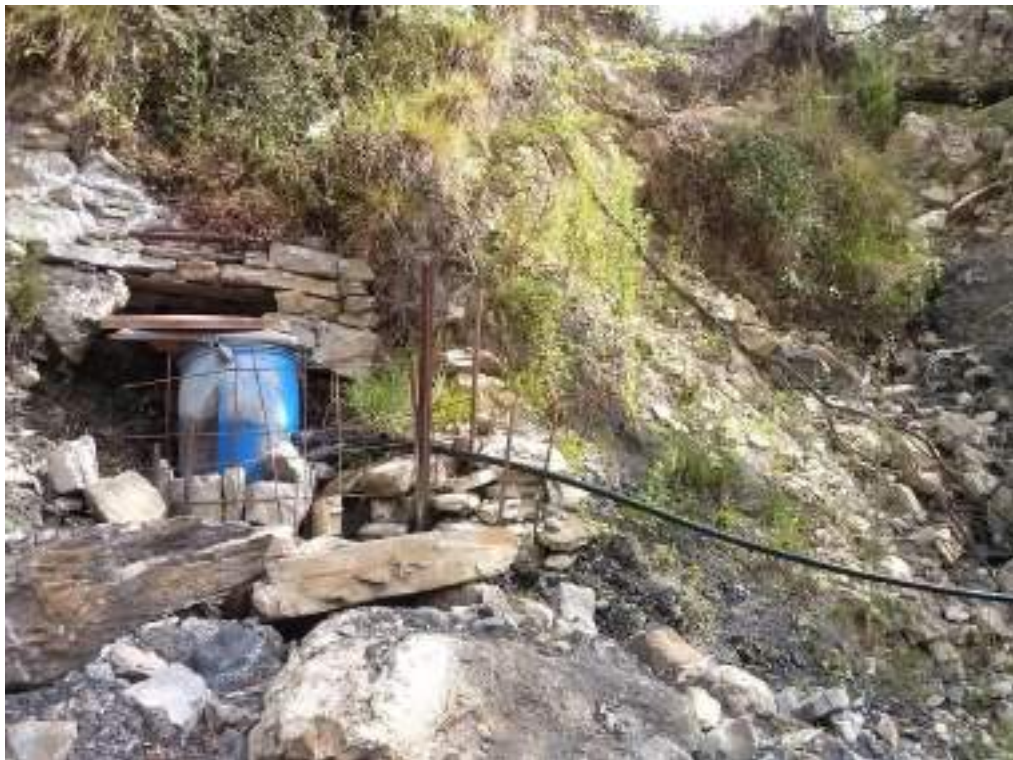
Foto 14 – Rudimentale opera di captazione di una sorgente in sponda sinistra del Rio Maggiore nei pressi della confluenza con il rio Bastia.
