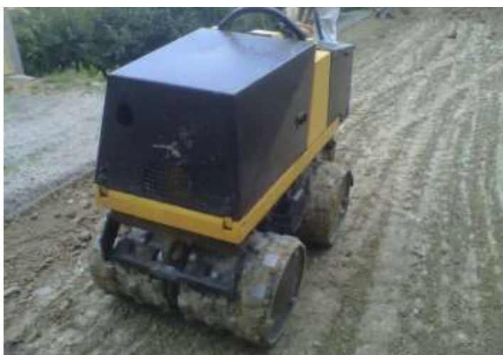
Compattazione del materiale per ciascuno degli strati
