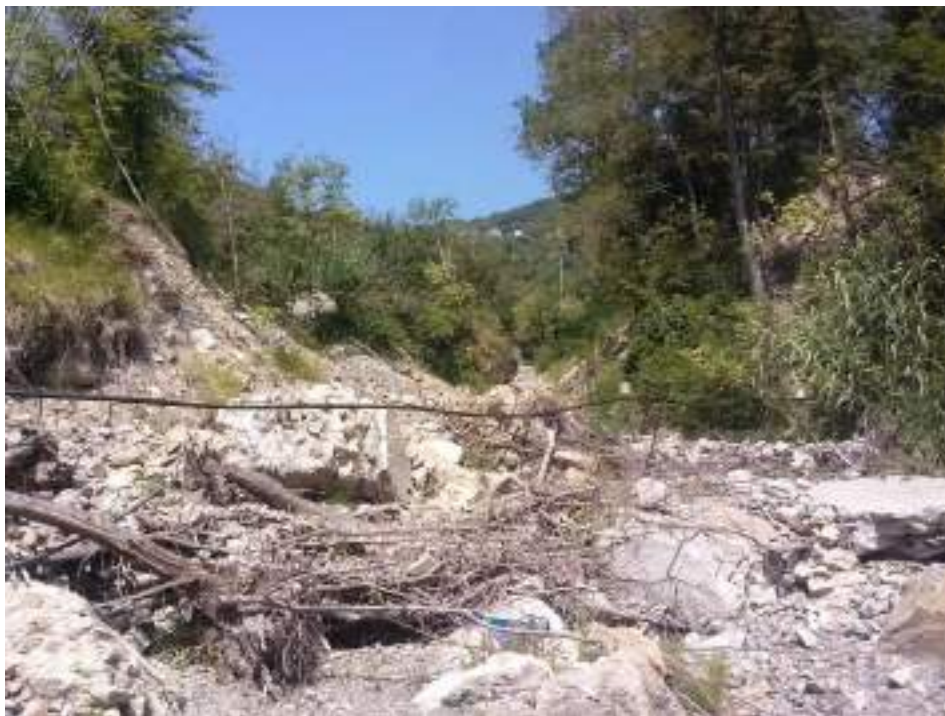
Foto 1 – Rio Maggiore nel tratto a monte della grossa briglia di quota 110. Si nota l'ingente quantità di materiale depositato di varia pezzatura e le diffuse forme di erosione spondale
