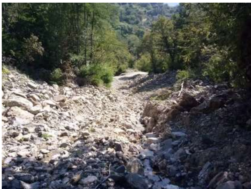
Foto 17 – Il Rio Bastia nel tratto a monte della strada e briglia di cui alla foto precedente dopo gli interventi propedeutici di riprofilatura in alveo
