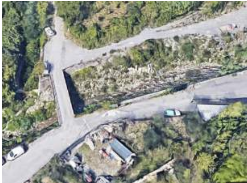
Veduta del ponte a valle dell'area di intervento
