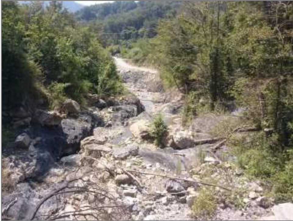
Figura 5_parte valliva della zona di intervento, si nota la presenza di grossi blocchi in alveo
