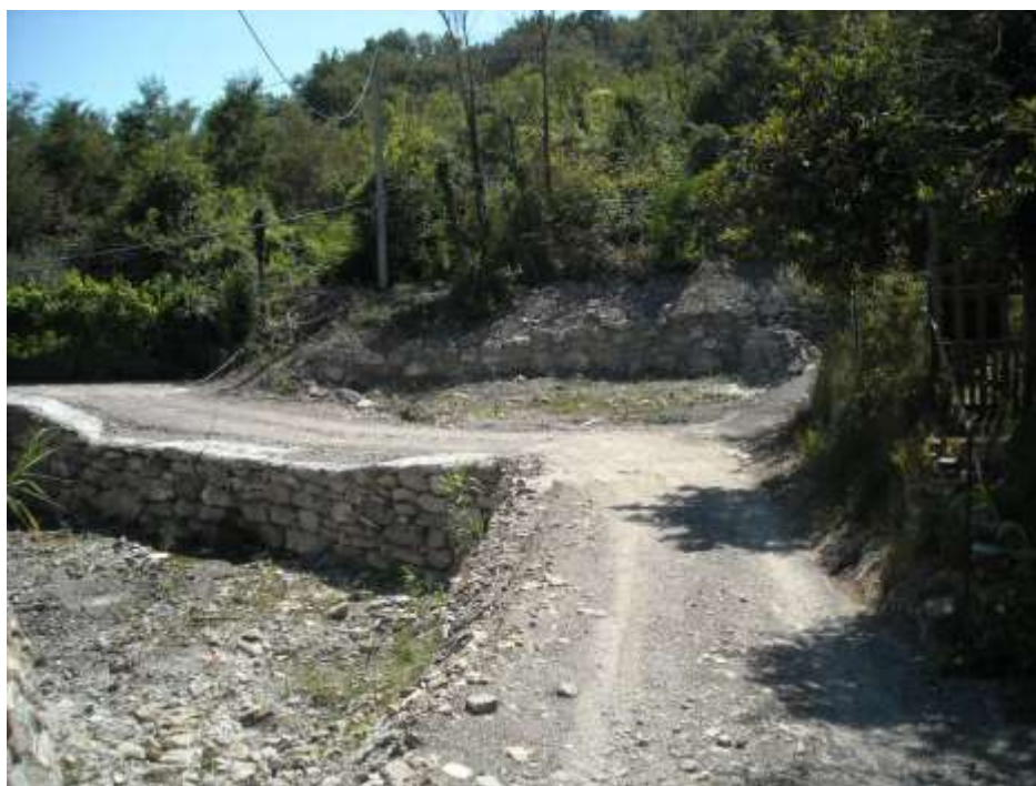
Foto 7 – Briglia in corrispondenza della quale si realizzerà la tombinatura sul Rio Maggiore.
