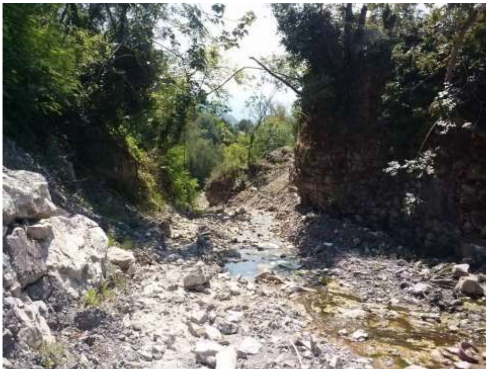
Foto 10 – Il Rio Maggiore nel settore iniziale del tratto in esame, in cui si notano a sinistra le opere di difesa spondale in massi già eseguite e sulla destra i residui di vecchi muri citati nel testo e di cui alla foto successiva ripresa da valle verso monte.
