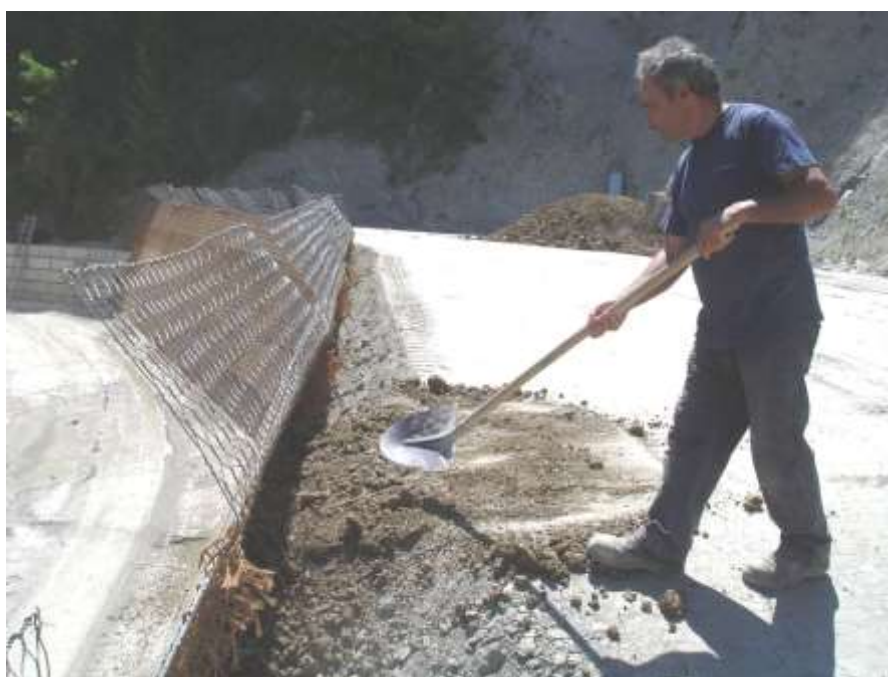
Riempimento a tergo del paramento
