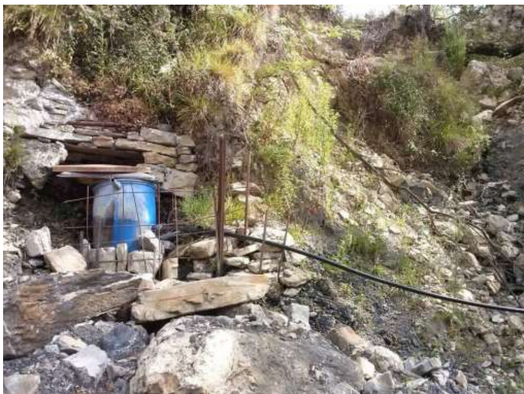
Foto 1 – Dissesto in sponda sinistra a margine di una sorgente e relativa “opera” di captazione.
