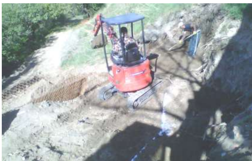
Riempimento e stesa degli strati
