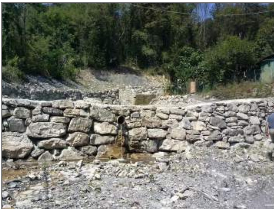
Figura 4_Briglia esistente sul Rio Maggiore realizzata durante i lavori del Lotto 1
