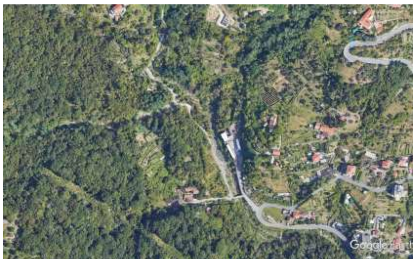
Figura 3 - Foto aerea del settore in esame nel bacino del Rio Maggiore (fonte Google-Earth).
