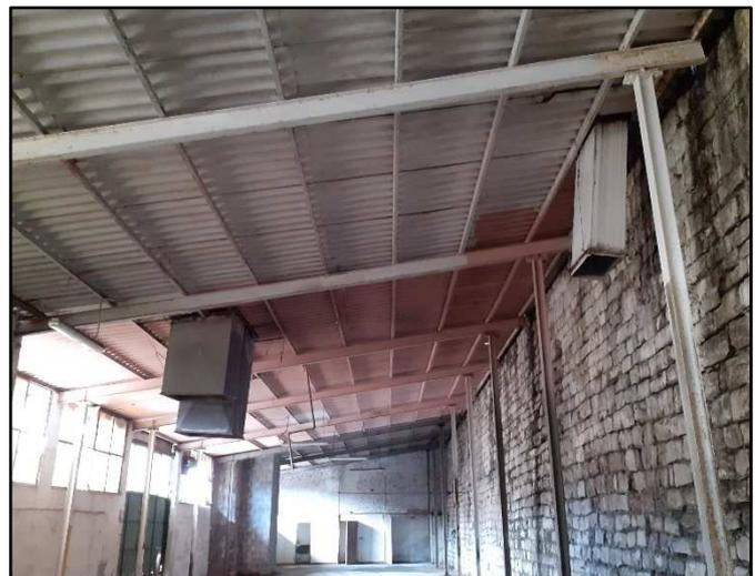
*Figura 5. foto esemplificative della tipologia di materiali potenzialmente contenenti amianto*
