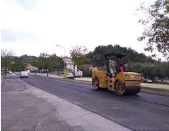
Rifacimento manti stradali
