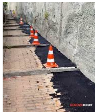
Ripristino impianti fognari
