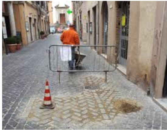
Ripristino pavimentazioni stradali
