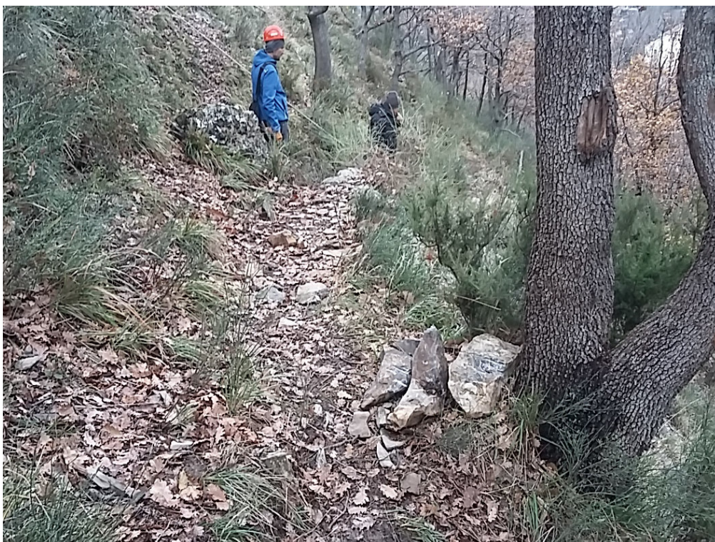
Foto 18 – In primo piano parti di blocco lapideo frantumato e sistemato in posizione di sicurezza.
