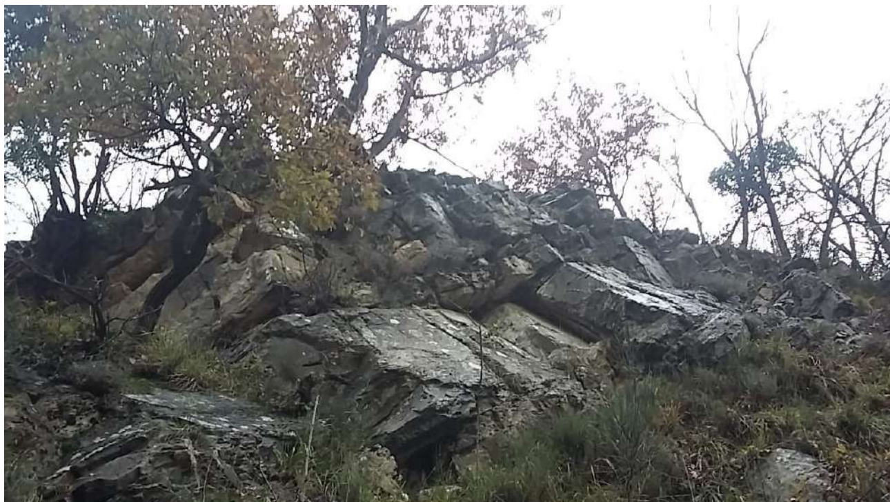
8. Immagine della situazione esistente nella porzione sud del pendio (ZONA A)
