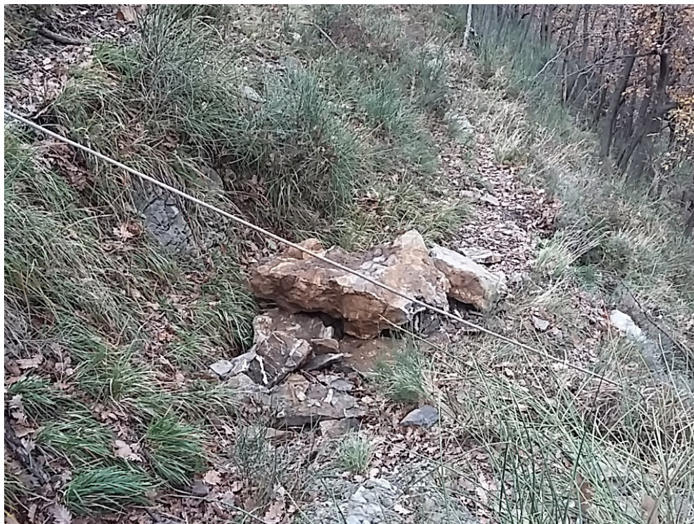
Foto 19 – Blocco lapideo frantumato e sistemato in posizione di sicurezza.
