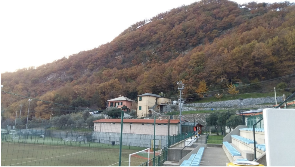
Foto 3 – A monte delle civili abitazioni il versante interessato dagli interventi in progetto.
