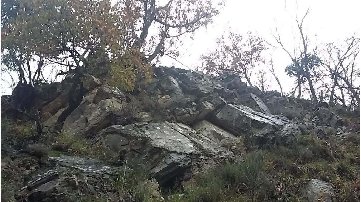
Foto 14 – Affioramento roccioso con porzioni dislocate e instabili a sud della frana.
