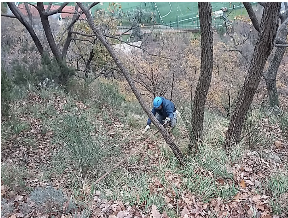
Foto 17 – Rocciatore impegnato in operazioni di ispezione e disaggio.
