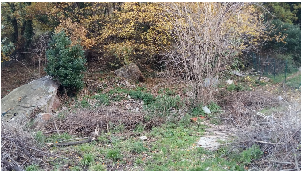
Foto 4 – Settore poco acclive al piede del versante in frana, in adiacenza a Via Livello. Evidenti lo stato di incuria e alcuni massi ciclopici derivanti dall'evento in questione.
