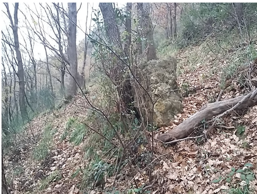
Foto 9 – Masso trattenuto da albero a nord della frana.
