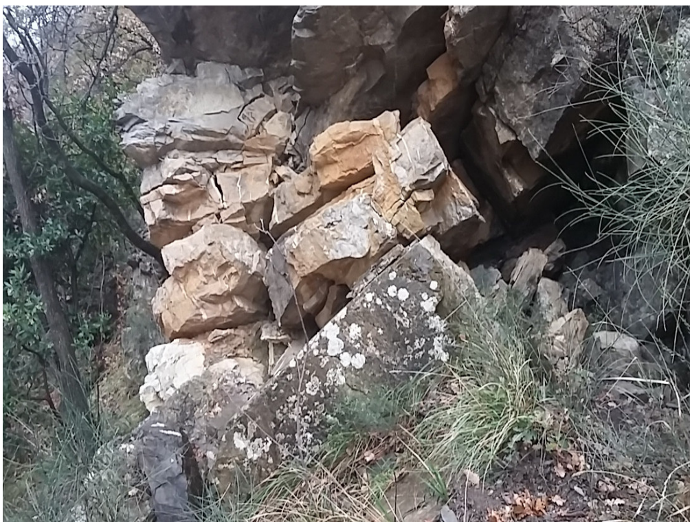
Foto 13 – Blocchi lapidei completamente dislocati dall'ammasso roccioso a sud della frana.
