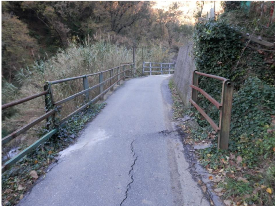
Foto 3 – Vista su Intervento 1 (estremità nord)
