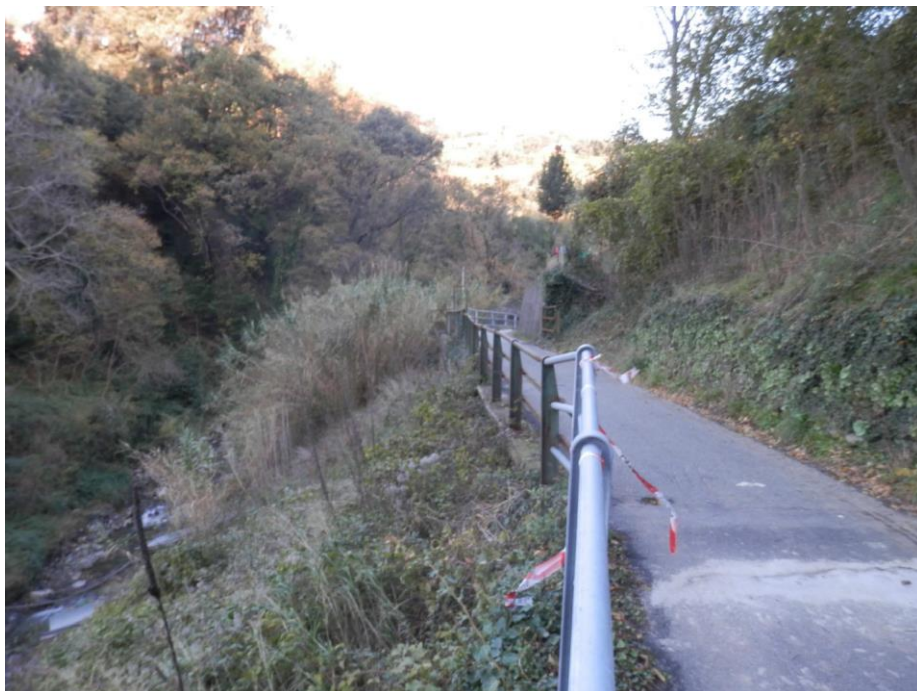
Foto 2 – Vista della scarpata sul Rio San Pietro – Intervento 1
