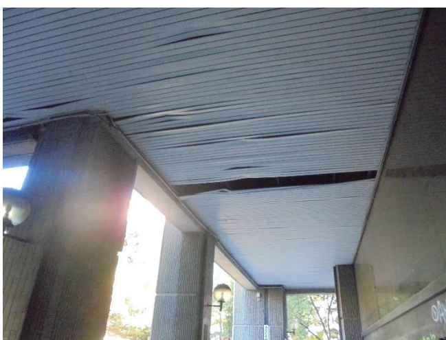
Figura 1- controsoffitti danneggiati
