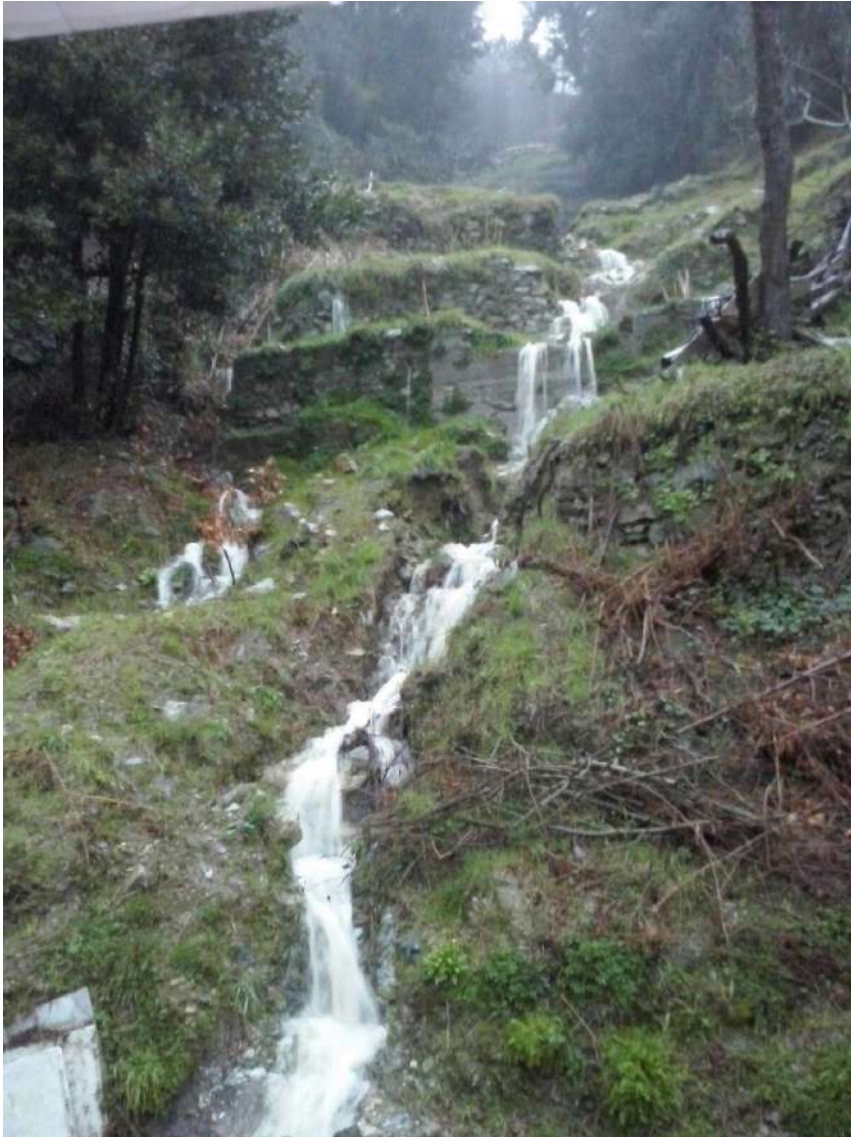
Foto 9 – acqua piovana che è libera di attraversare il versante, non essendo regimata.
