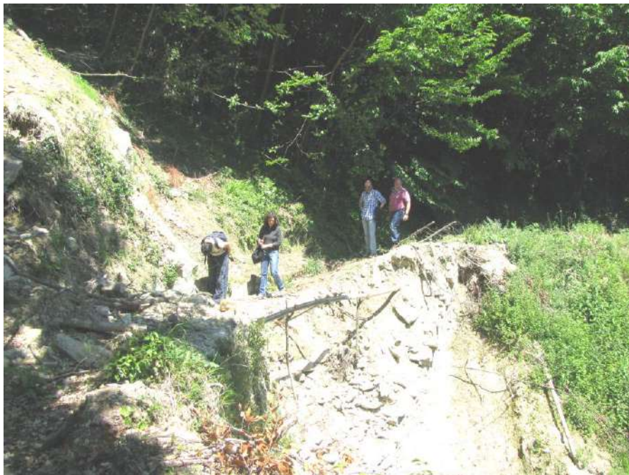
Foto 4- vista d'insieme del sentiero a quota 187, dove passava la condotta idrica distrutta dalla frana. si notano i muri in pietrame crollati a valle del sentiero.
