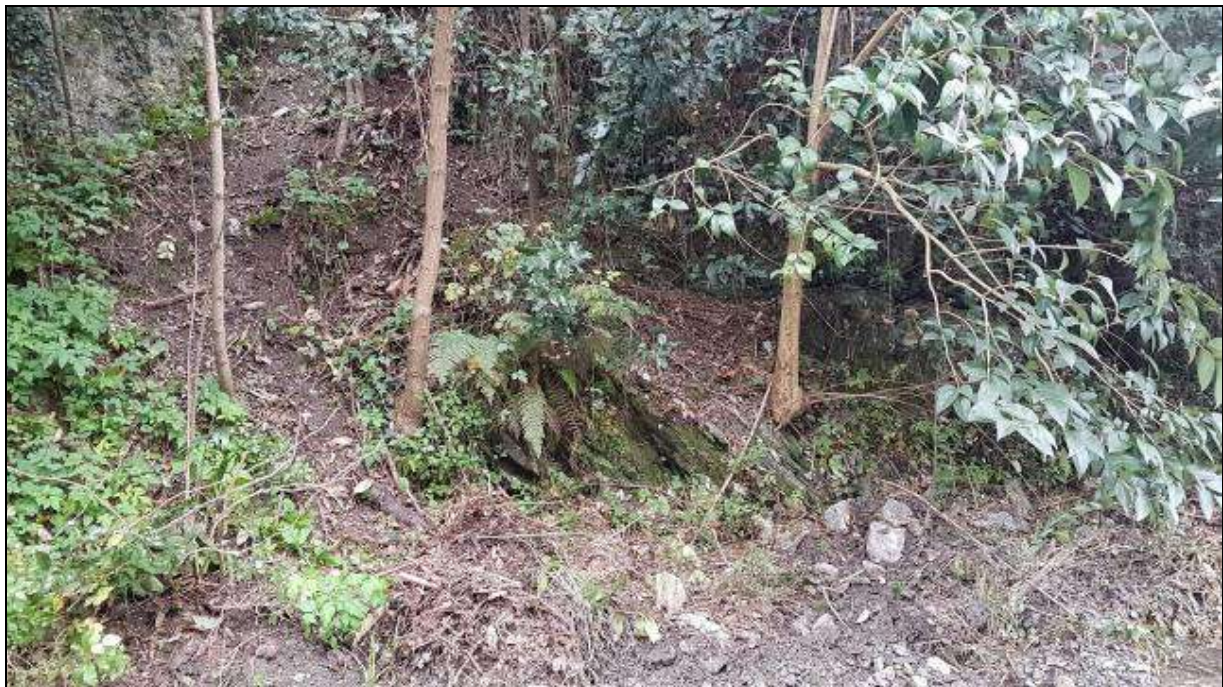
Foto 5 – Affioramenti di argilliti in sponda sinistra
