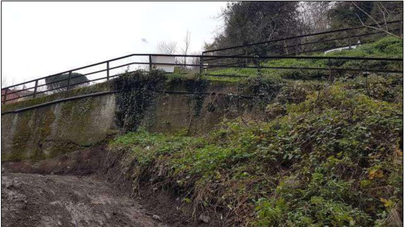
Foto 4 – Sponda destra, muro contenimento della stradina di accesso al ponte.
