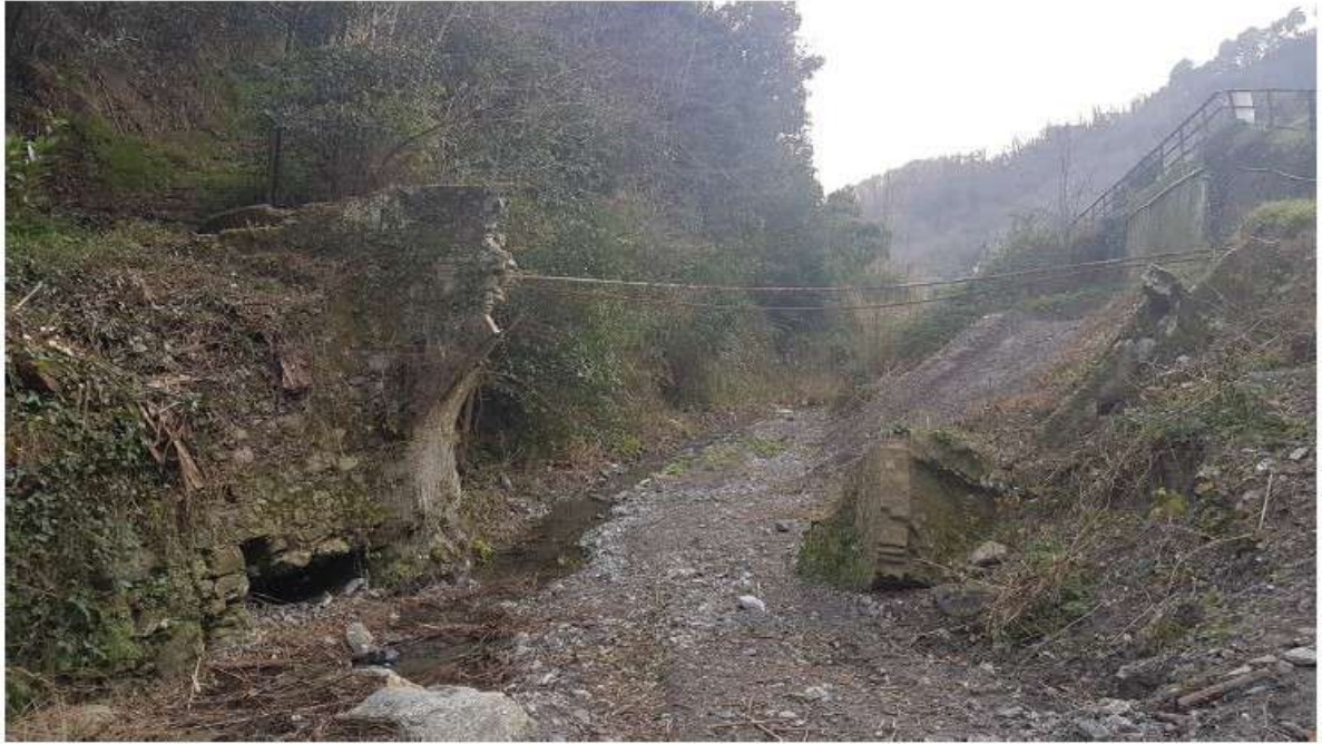
Foto 3 – Vista verso valle
