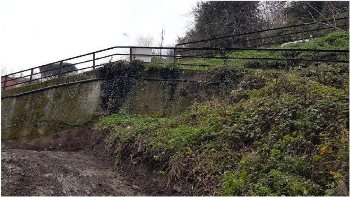
Foto 7 – Sponda destra, muro contenimento della stradina di accesso al ponte.
