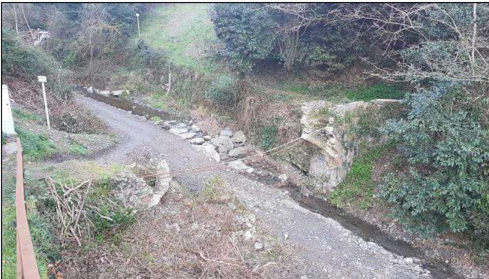
Foto 1 – Stato attuale della zona d'intervento.
