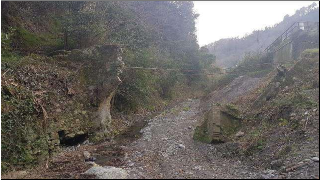
Foto 2 – Vista verso valle
