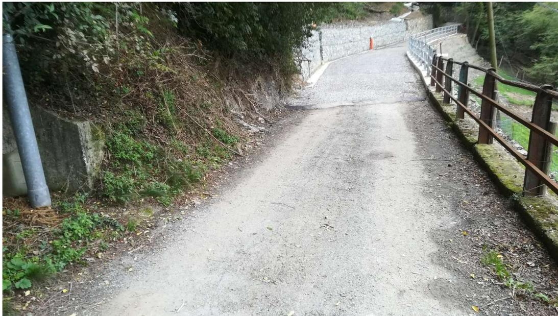
*Fig. 5 – Tratto a progetto con prevista cunetta a monte e attraversamento tubo acque bianche*
