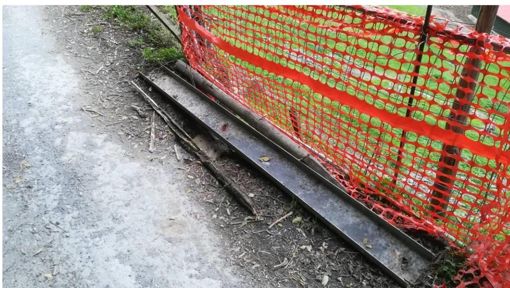
Foto 3 – Dettaglio del punto in maggiore erosione per indisciplina delle acque e cedimento del sedime stradale
