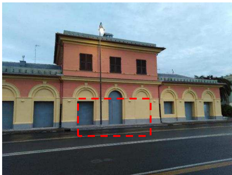
Figura 16. Fronte Sud corpo centrale – Localizzazione parapetto di protezione
