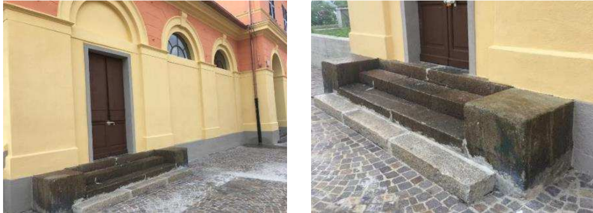
Figura 15. Scala di accesso nel locale accessorio del corpo di Levante
