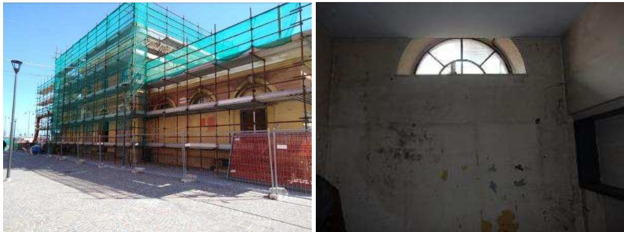
Figura 2. Il fronte Nord su cui verranno aperti i due varchi e una vista dall'interno della porzione di muratura da demolire
