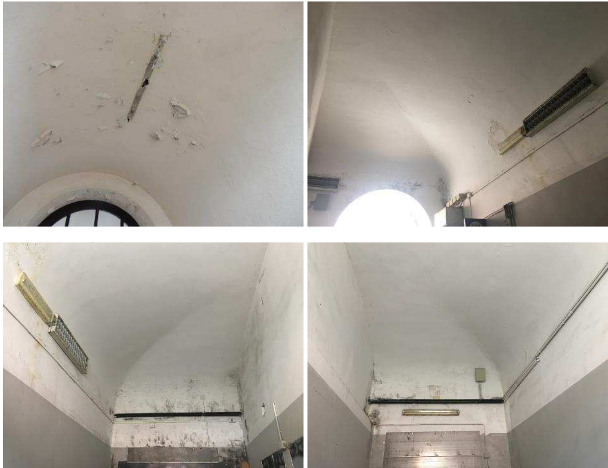
Figura 14. Le volte in canniccio dei locali posti a piano terra
