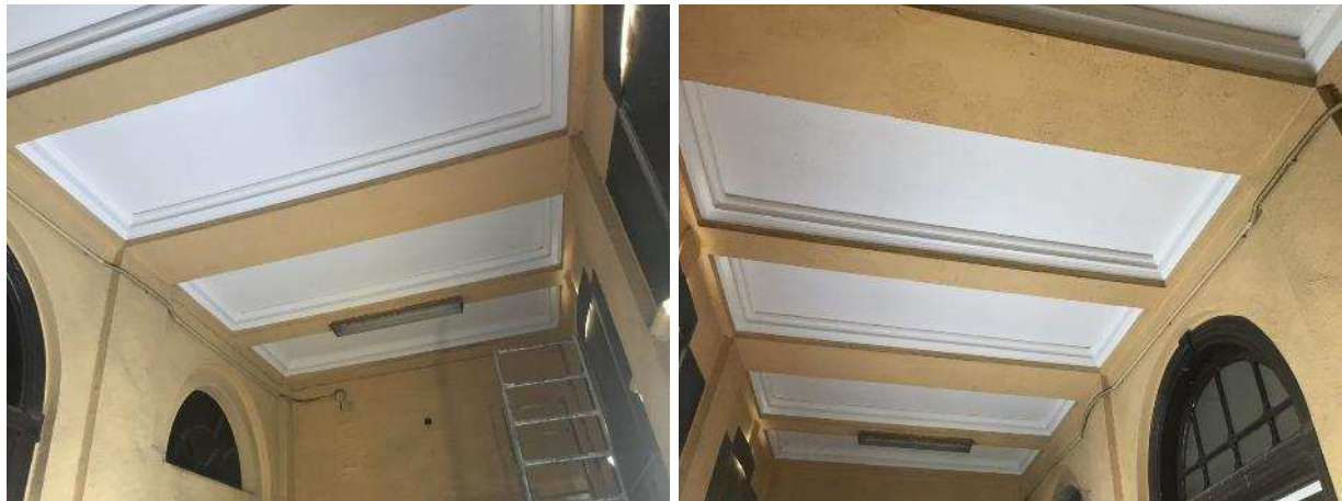
Figura 12. Controsoffitto piano dell'atrio del corpo centrale sul fronte Nord
