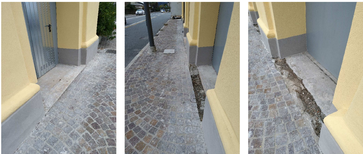
Rimozione piatte e punti di integrazione pavimentazione in porfido
