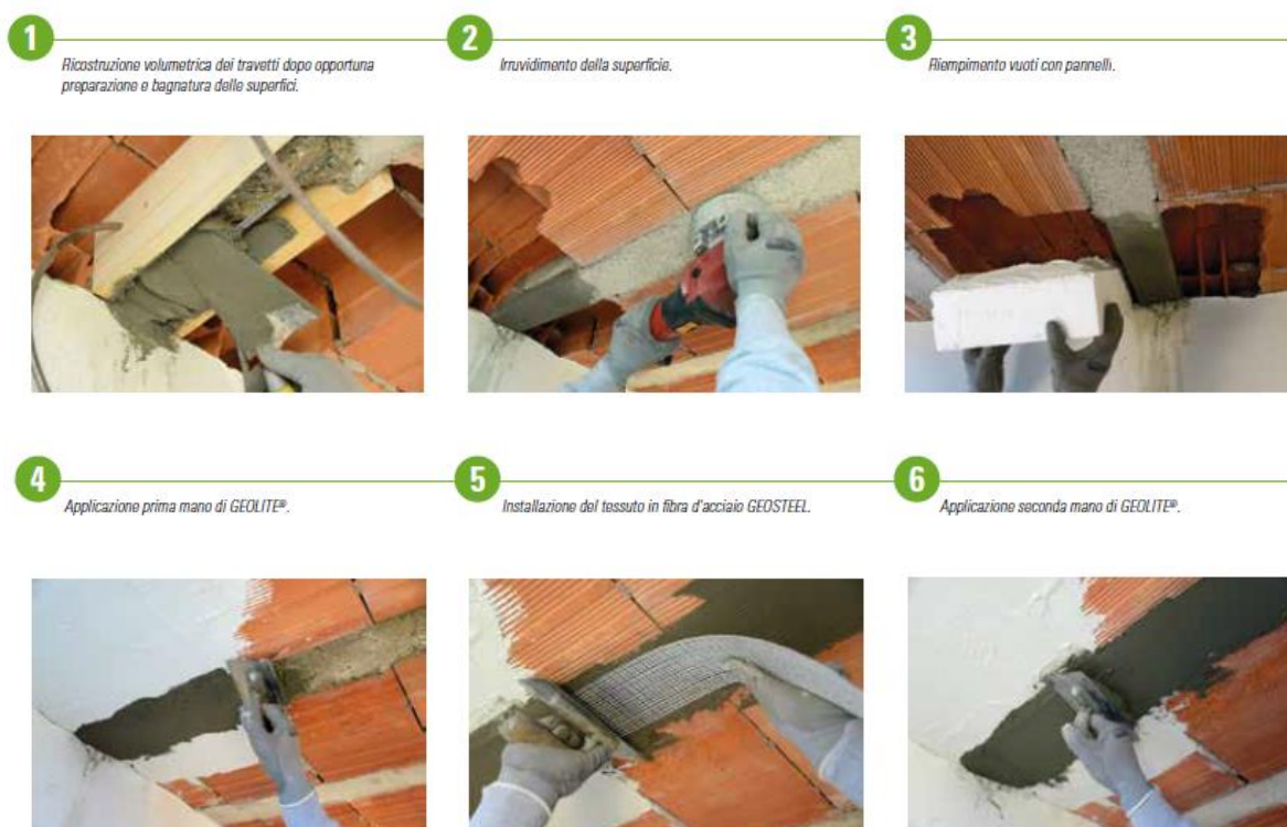
Figura 20.1.1 – Specifiche fasi intervento di consolidamento all'intradosso
