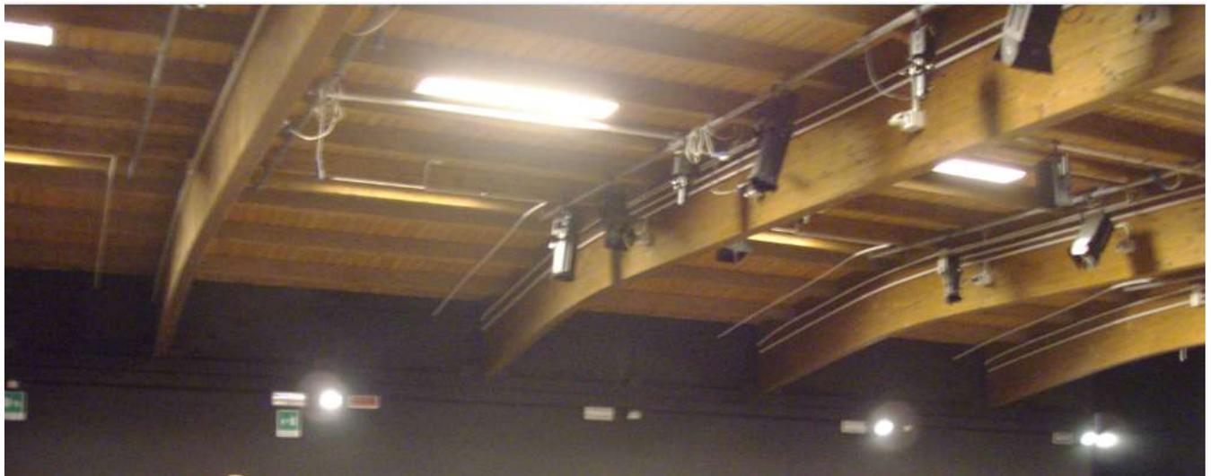
Figura 3 –Dettaglio interno copertura teatro impiantistica da smontare/rimontare dopo trattamento ignifugo degli elementi lignei – esterno copertura piana
