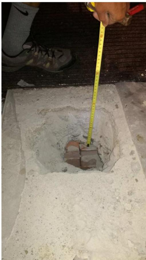
Figura 28 Spessore porzione cls del solaio
