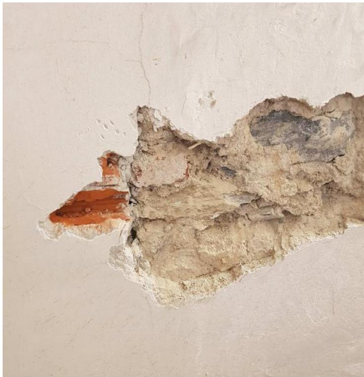
**Figura 4.** Particolare del saggio sulla muratura di confine tra il vano tecnico e le scale
