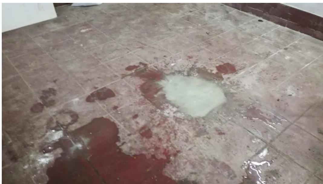
**Figura 27** Preforo ripristinato con malta cementizia
