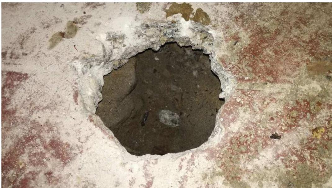
**Figura 24** Preforo nella soletta del vano caldaia
