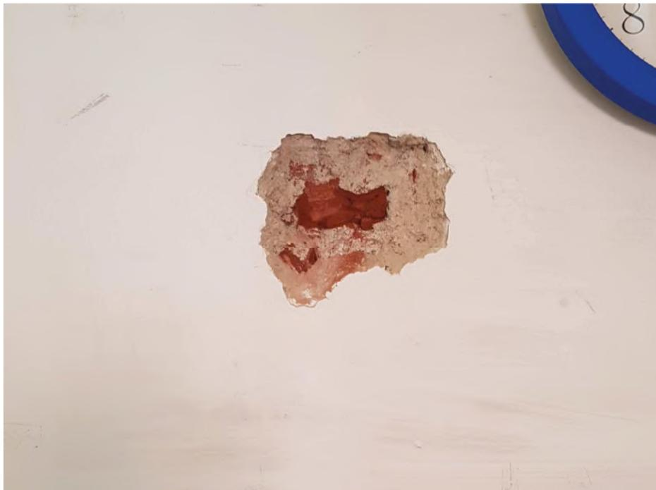
**Figura 6.** Particolare del saggio sulla muratura del vano scale
