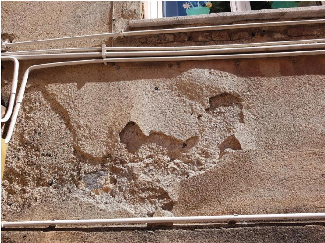
**Figura 1.** Particolare del saggio esterno sulla muratura di facciata
