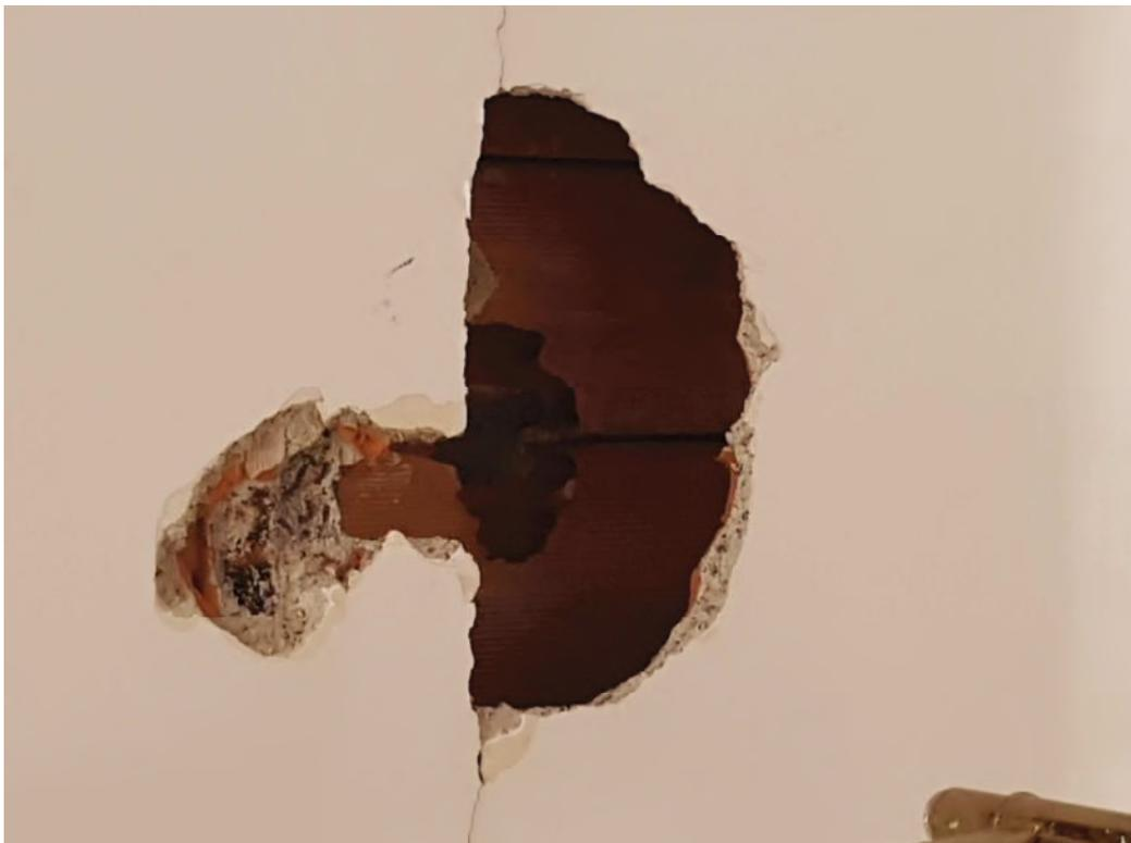
**Figura 8.** Saggio sul solaio dei piani superiori
