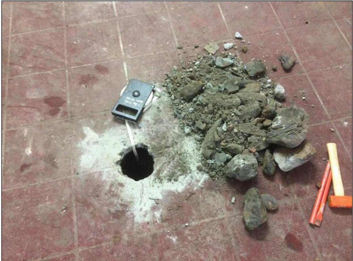
Foto 2. Particolare della soletta e materiale estratto dal foro di avvio all'interno del locale sede dell'intervento in progetto.
