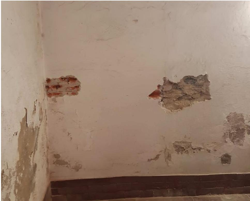
**Figura 3.** Saggio sulla muratura di confine tra il vano tecnico e le scale
