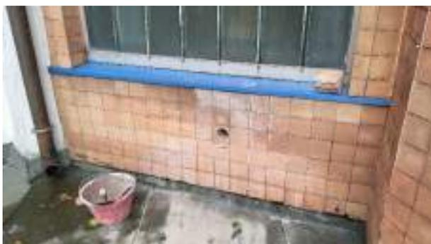
Figura 12. Identificazione posizione carotaggio
