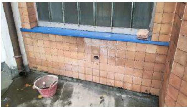
Figura 12. Identificazione posizione carotaggio
