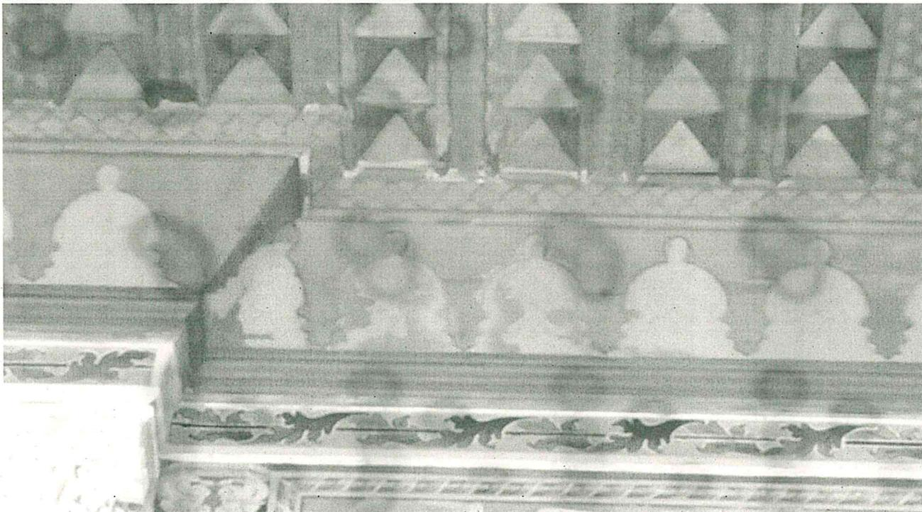
sala del capitano – dettaglio dell'infiltrazione della sguscia sui due lati
