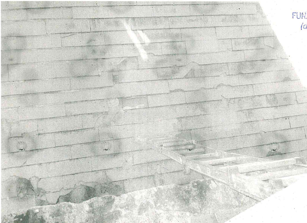
Esempi di falde con abbadini sfaldati ed a rischio di caduta
