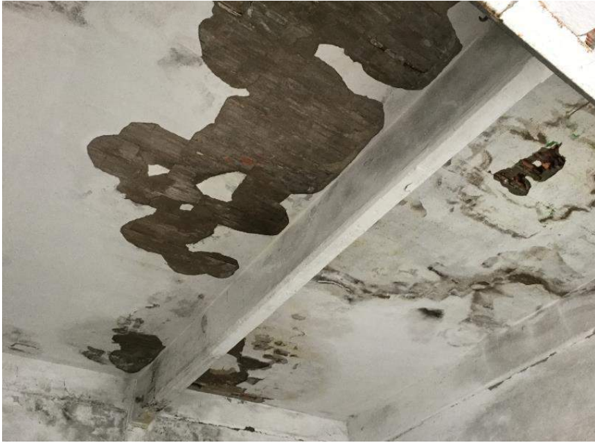
Foto 2: Trave c.a. e solai latero cementizi
