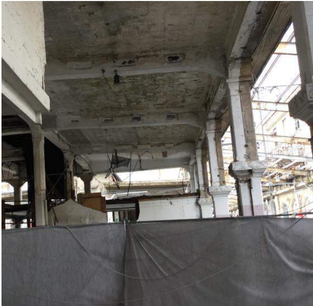
Foto 12: Vista edificio centrale con travi forate
