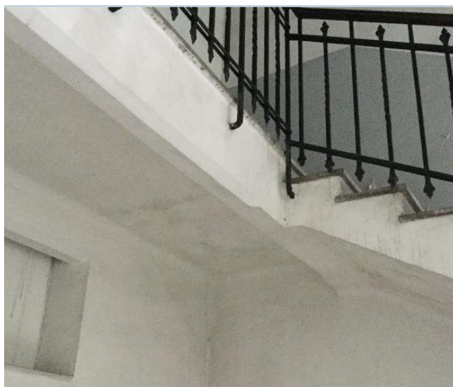
Foto 6: Scale interne, particolare
