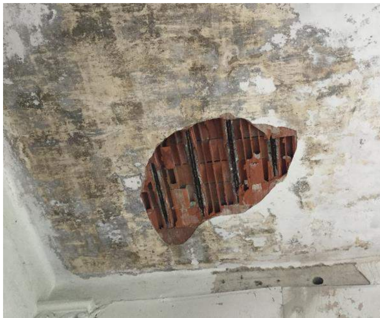
Foto 8: Solaio sfondellato
