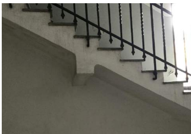
Foto 5: Scale interne, particolare trave
