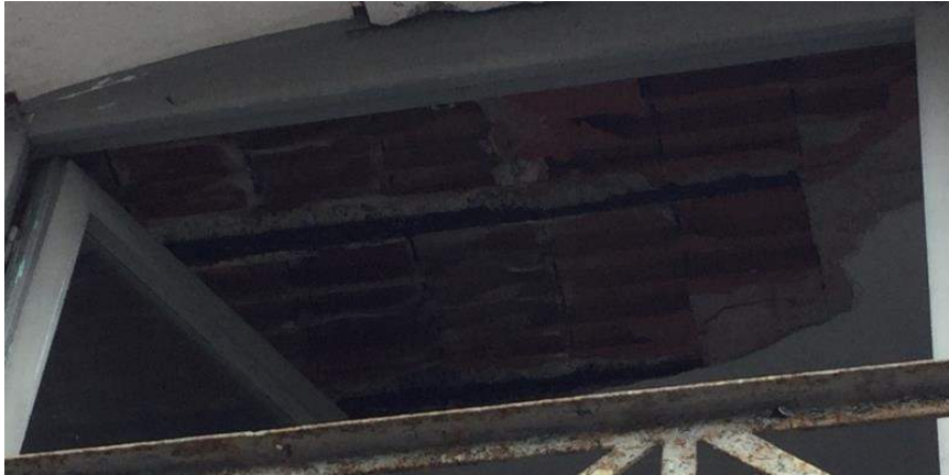
Foto 7: Solaio sfondellato
