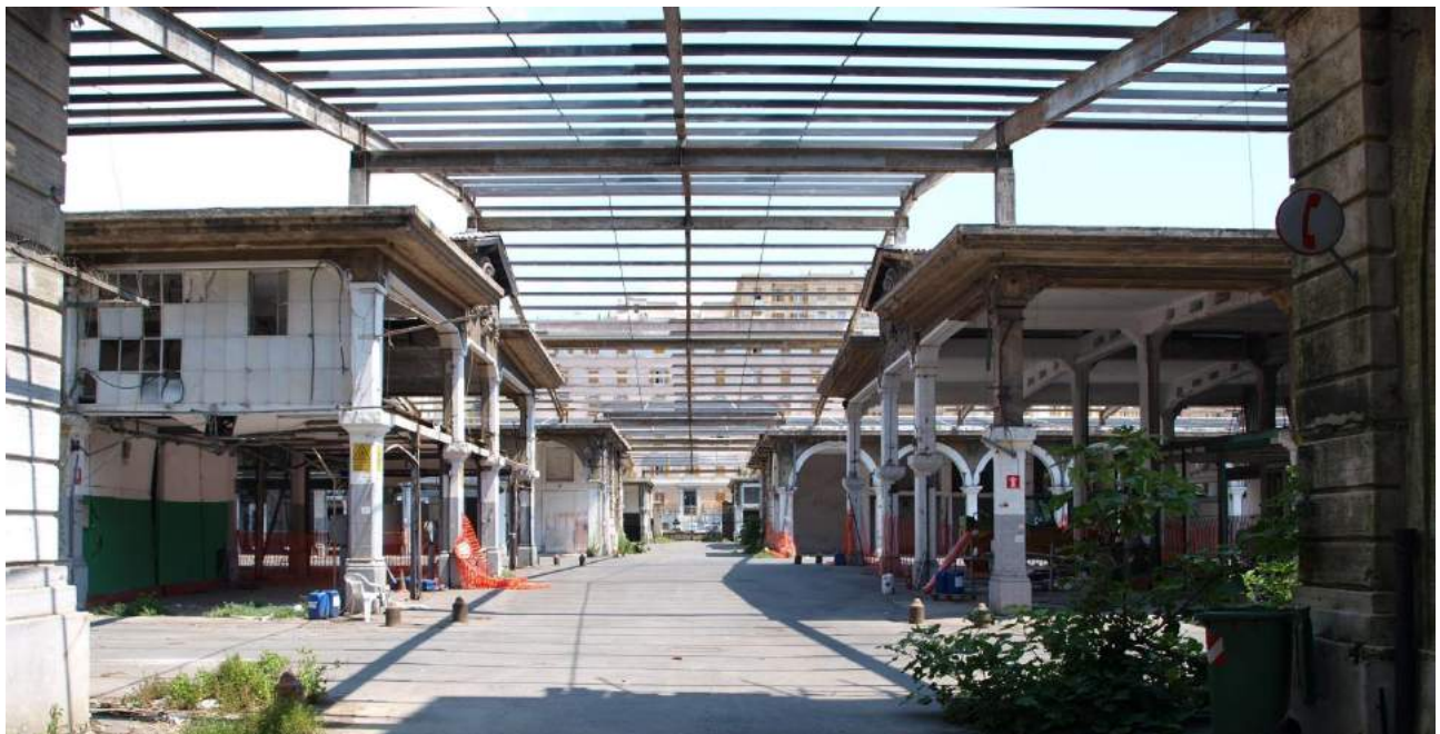
Foto stato attuale interna al mercato: asse centrale
