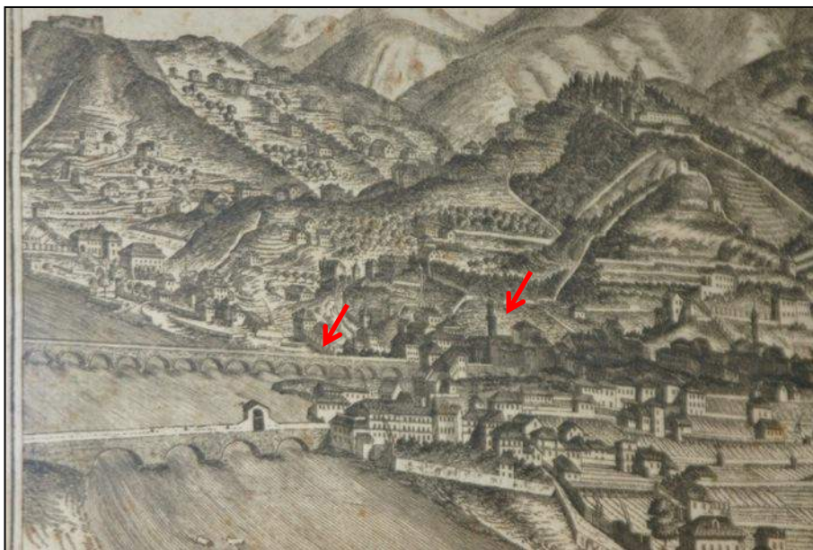
Figura 14. Raccolta di diverse vedute della Città di Genova e delle principali sue parti e fabbriche di A. Giolfi (1769): particolare della tavola in cui sono rappresentati il ponte e il complesso di S. Agata ( Galata Museo del Mare )
