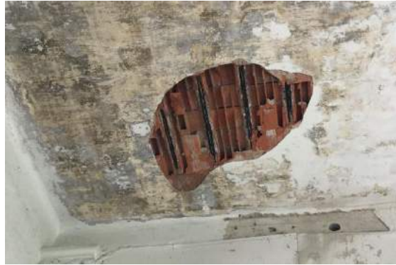
Foto 21: Solaio sfondellato
