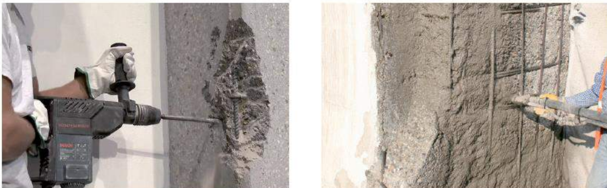
Foto 22: Esempio ripristino copriferro
