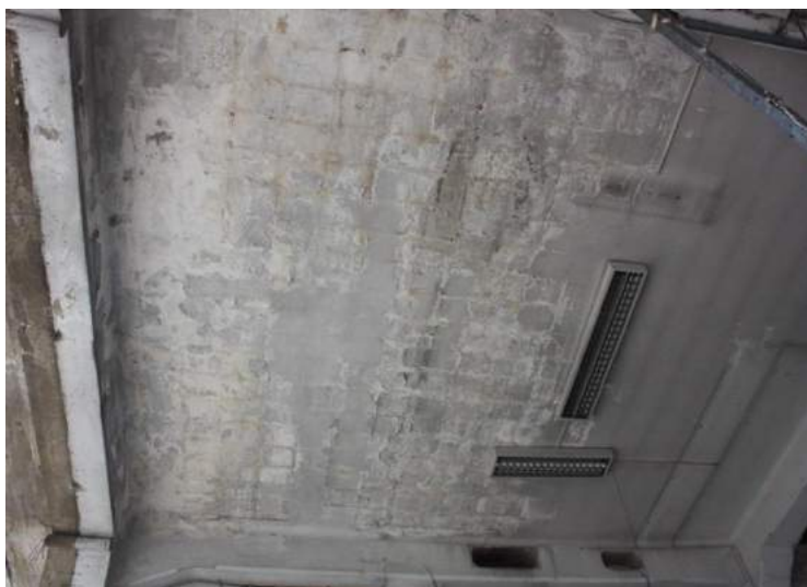
Foto 16: Efflorescenze saline
